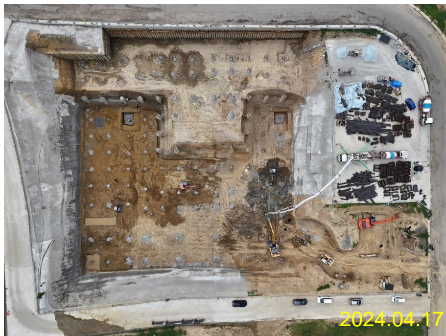
主殿土方開挖
