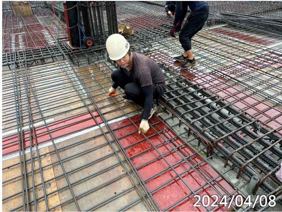
女寮1區B1F版鋼筋綁紮
