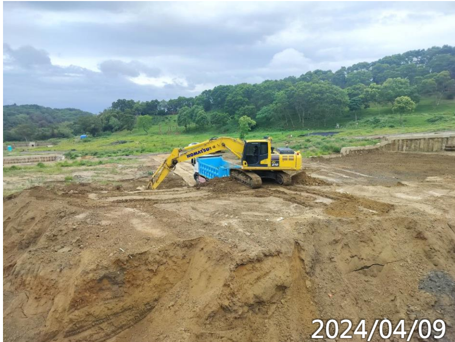
齋堂第二層土方開挖
