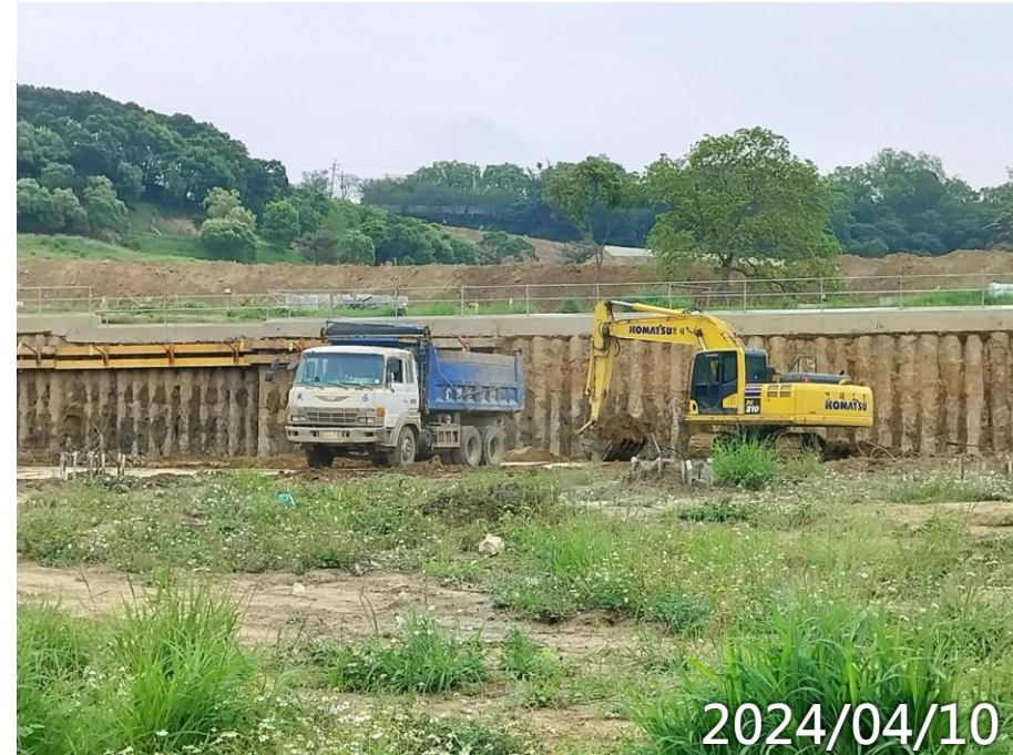
齋堂第二層土方開挖
