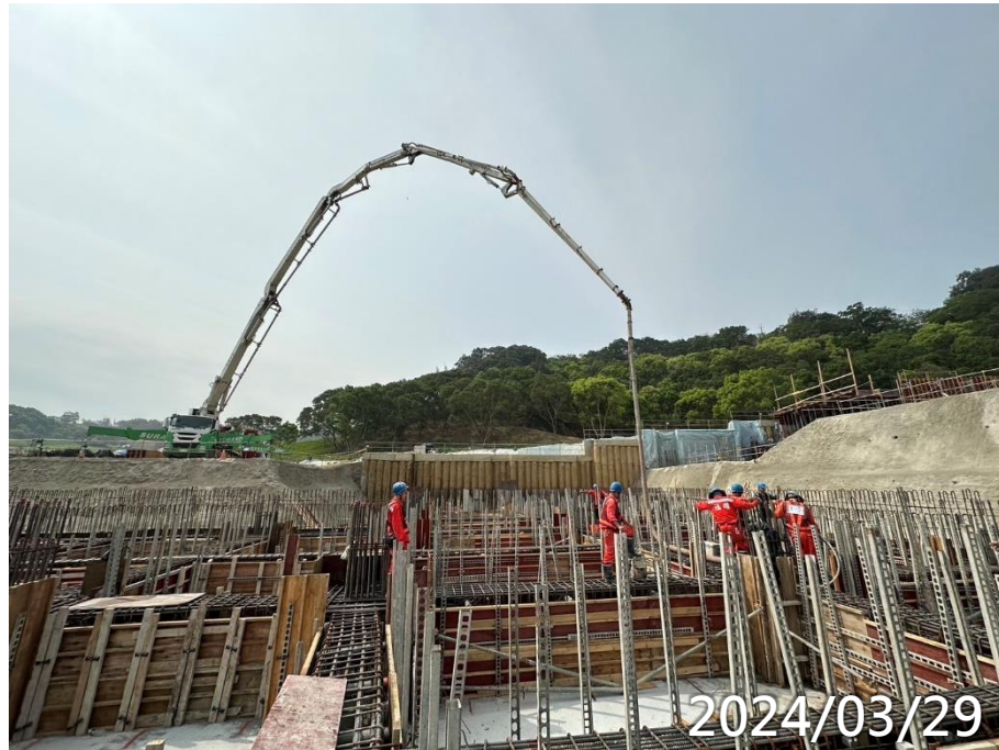
女寮1區地梁澆置
