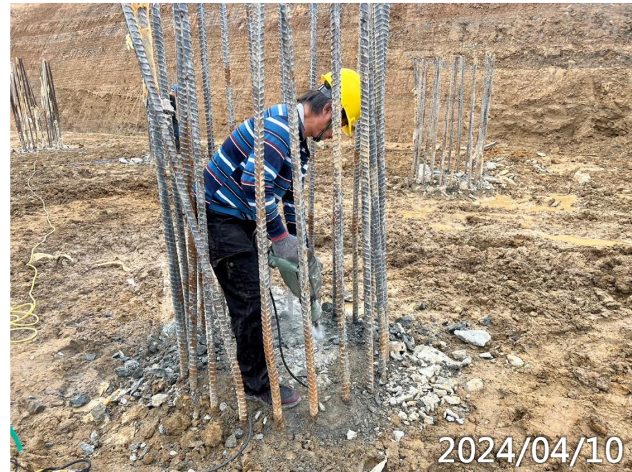
主殿基樁樁頭劣質打除
