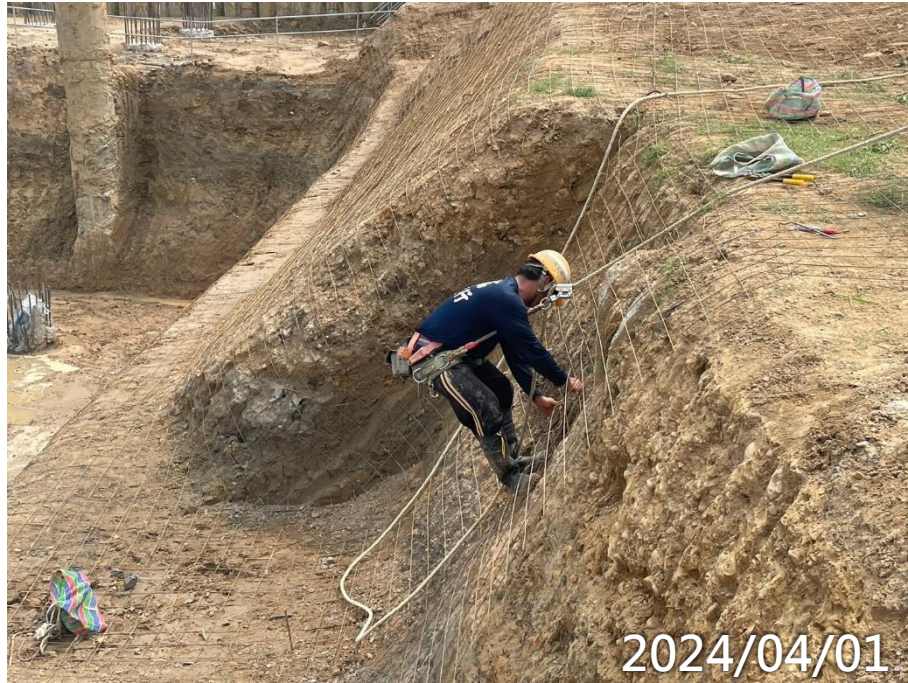
主殿噴漿護坡
