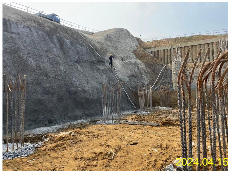
主殿噴漿護坡
