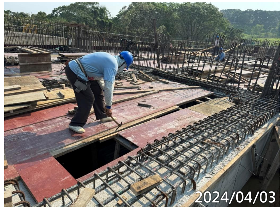
女寮1區B1F版鋼筋綁紮
