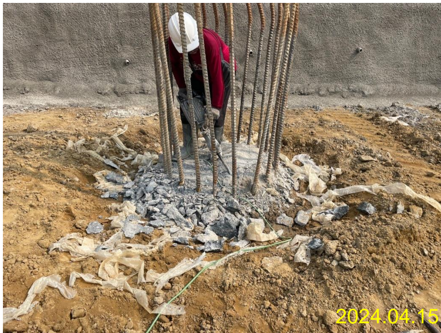
主殿樁頭劣質打除
