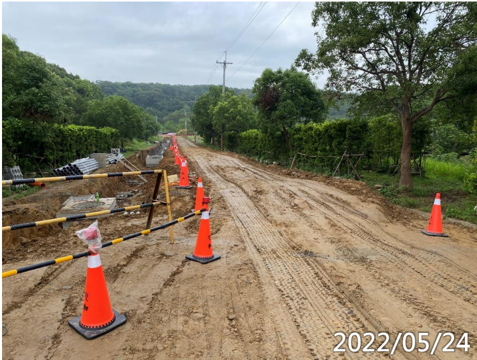
高低壓及弱電管路施工
