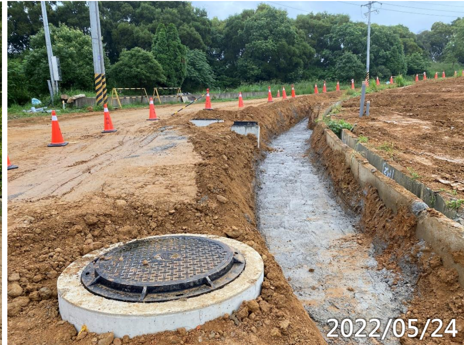
給水及消防管路CLSM打底
