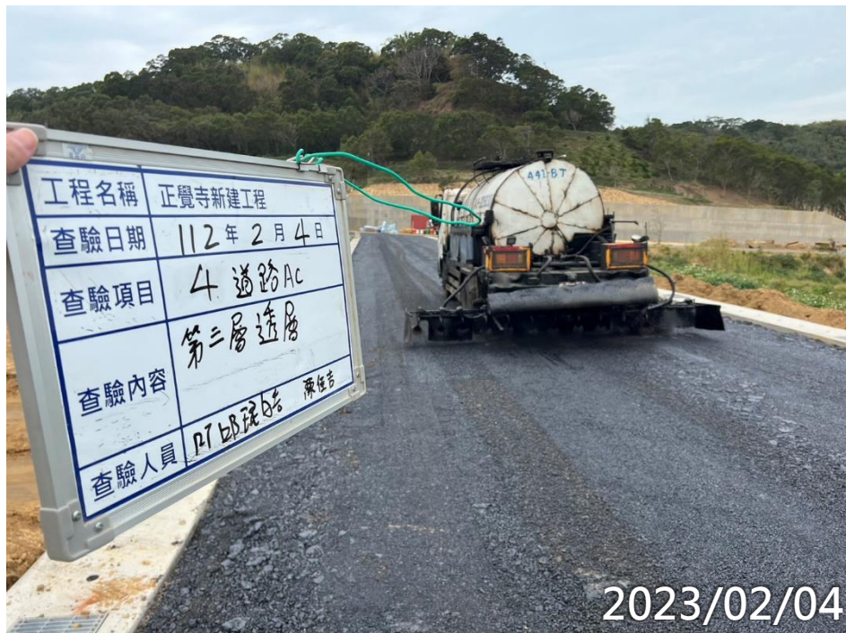
4道路AC第三黏層油施作
