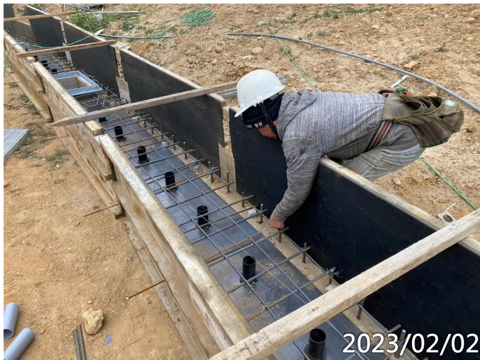
AU-45既有水溝加蓋施作
