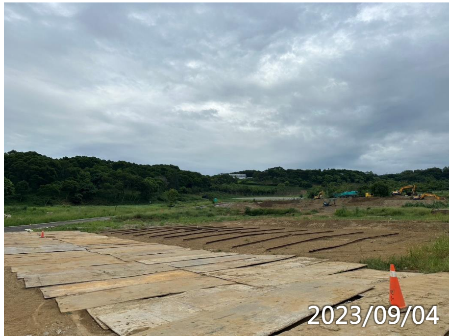
汙水廠、玄文動線鋼板鋪設
