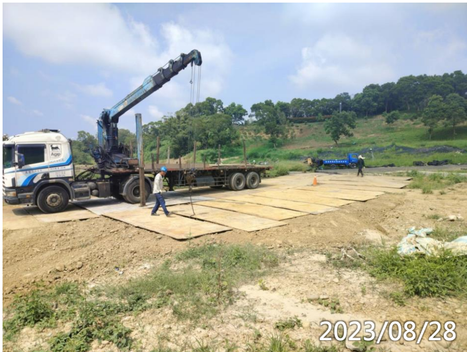
汙水廠、玄文動線鋼板鋪設
