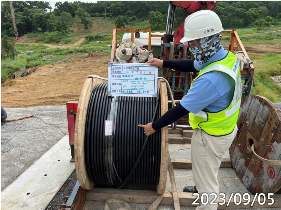
臨時電電線材料進場查驗
