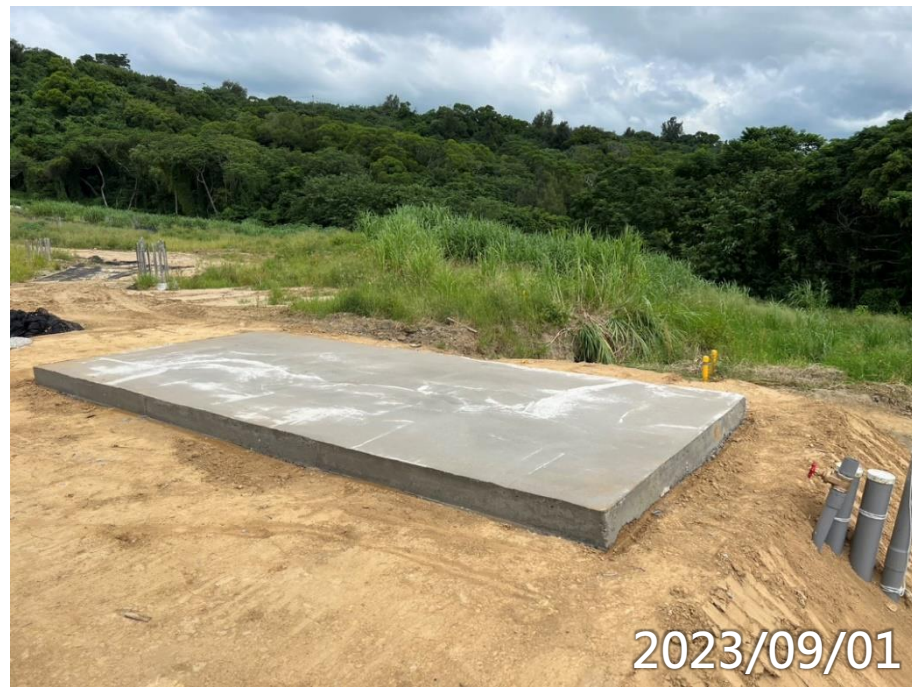
污水處理廠臨時水電基礎座
