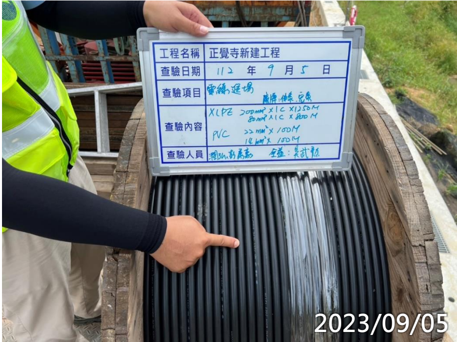
臨時電電線材料進場查驗
