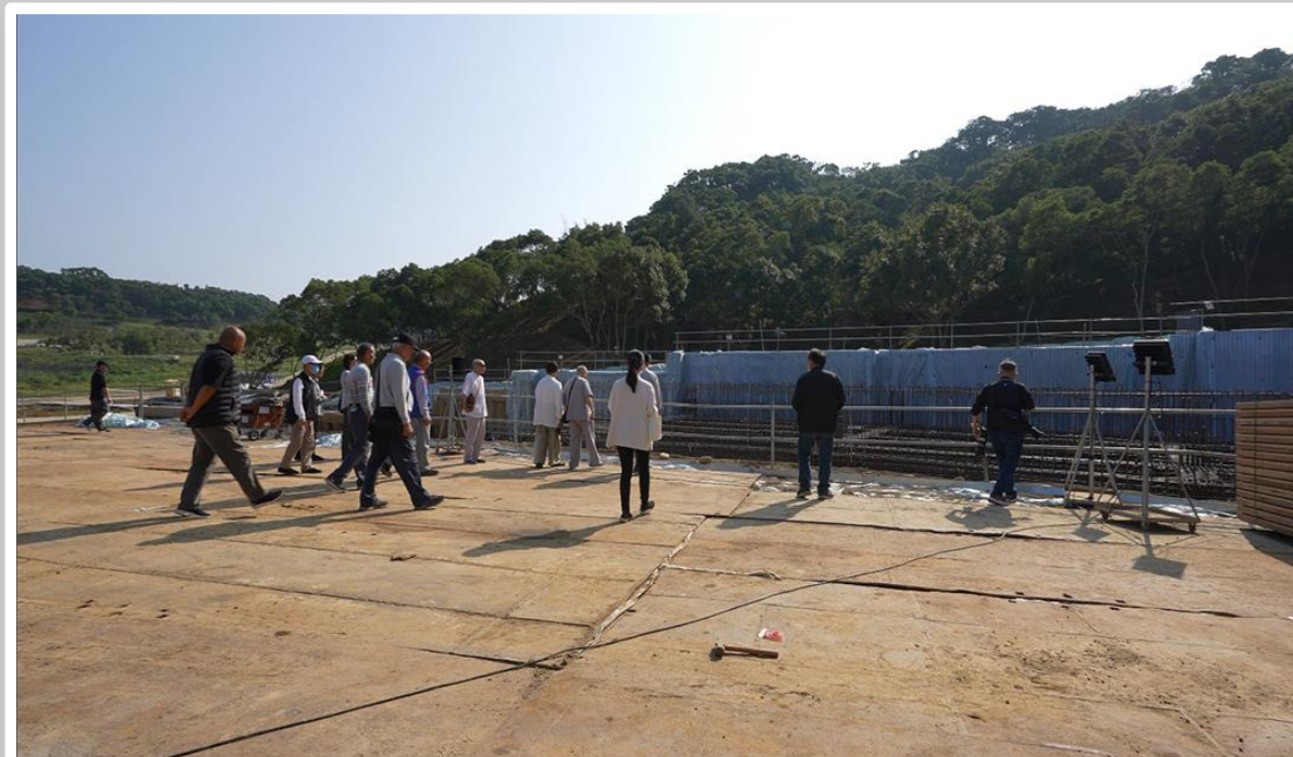
查看女寮施工現況 2023.12.08
