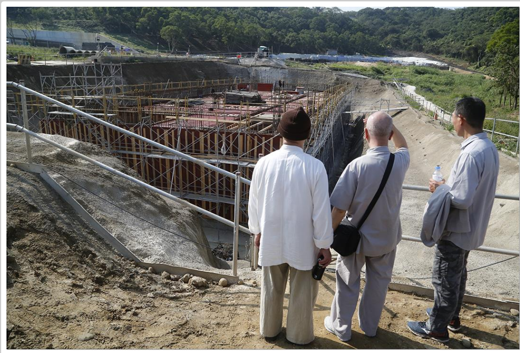
查看污水處理場施工現況 2023.12.08
