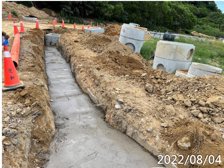
#5至#25汙水管路CLSM回填
