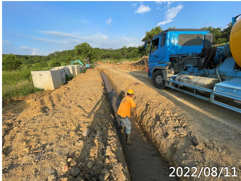
#5至#25污水管路CLSM打底
