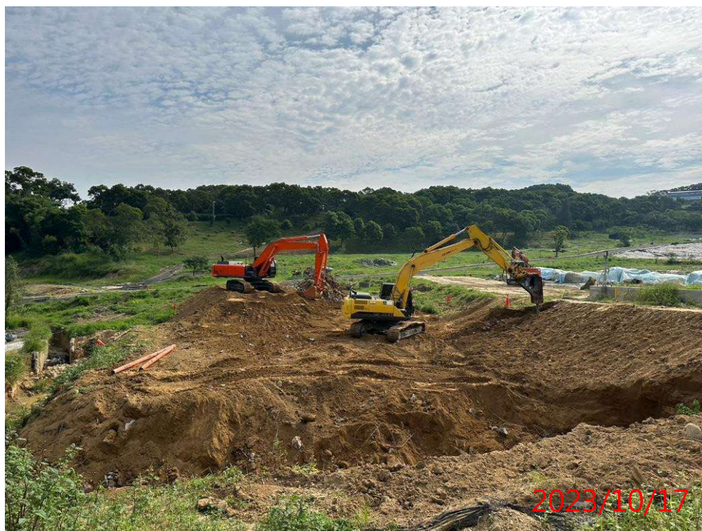
污水處理廠土方施工動線整地
