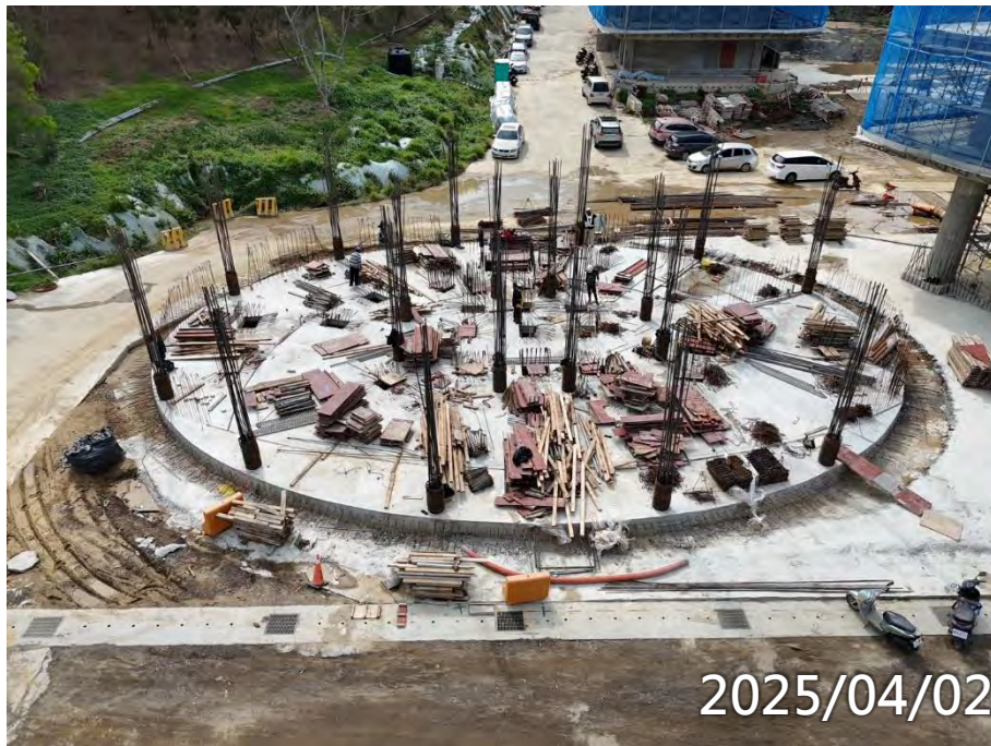
1F柱牆施作 筏基拆模
