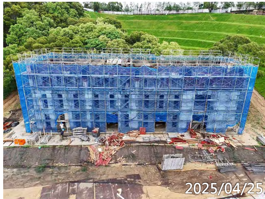
3F柱牆、RF梁版鋼筋模板水電 屋頂鋼構預埋備料
