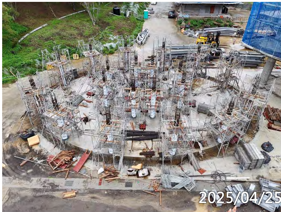
1F柱牆鋼筋模板水電施作
