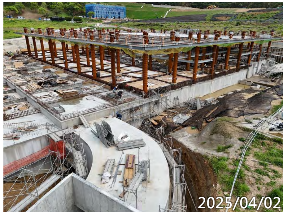
高版區1MF、2F鋼承鈑施作 低版區1F梁版鋼筋模板水電施作
