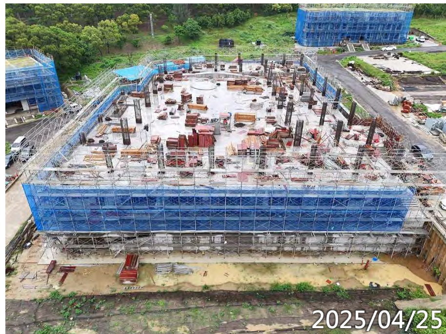
4F柱牆鋼筋模板水電施作
