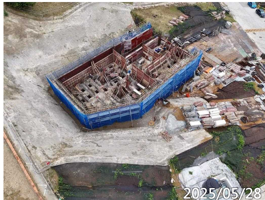
高版區2F柱牆鋼筋水電施作
