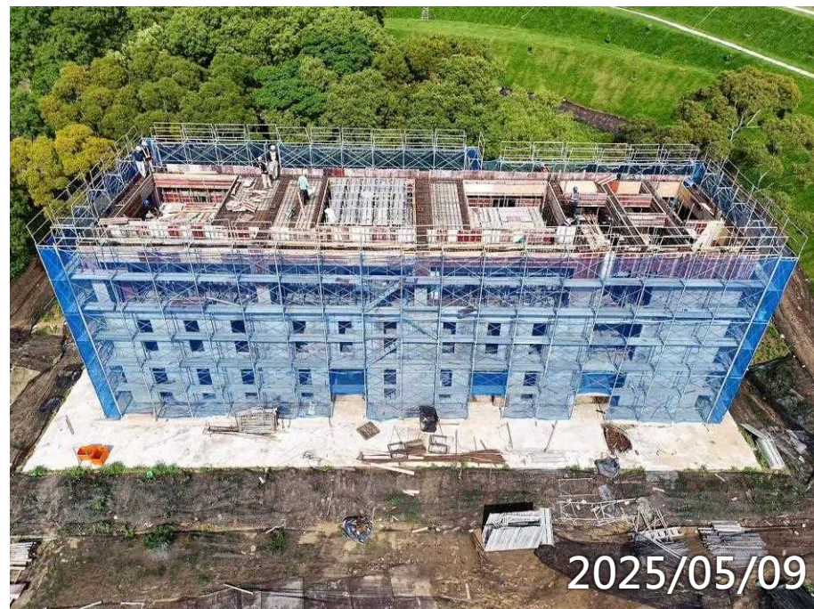
3F柱牆、RF梁版鋼筋模板水電 屋頂鋼構預埋 B1F、1F泥作吊線 B1F、1F輕隔間放樣
