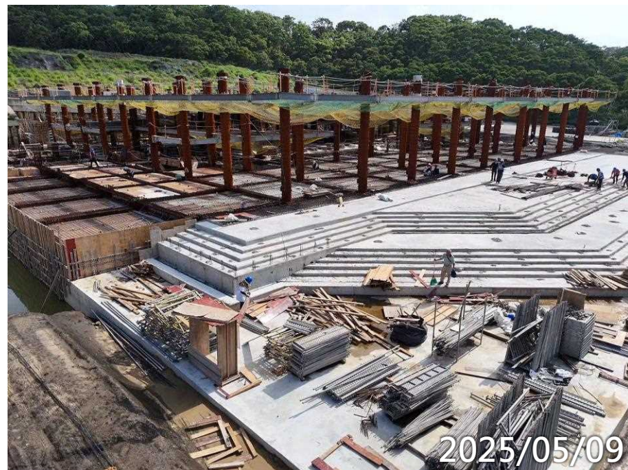
高版區花台、擋土牆施作 低版區1F梁版施作 2F鋼承鈑施作
