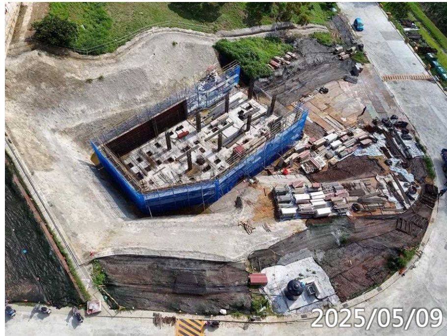
高版區2F柱牆鋼筋水電施作
