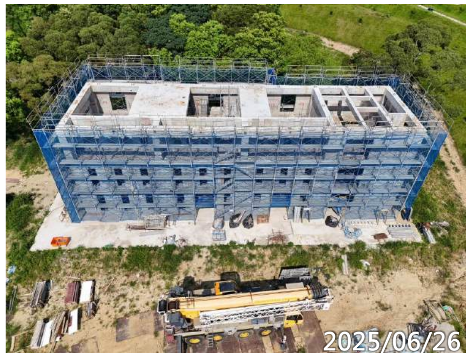
B1F-2F泥作打底 B1F-2F輕隔間放樣 屋頂鋼構吊裝
