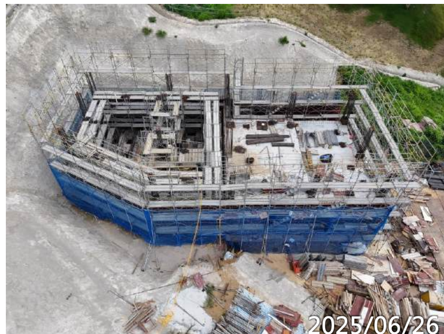
高版區3F柱牆鋼筋綁紮
