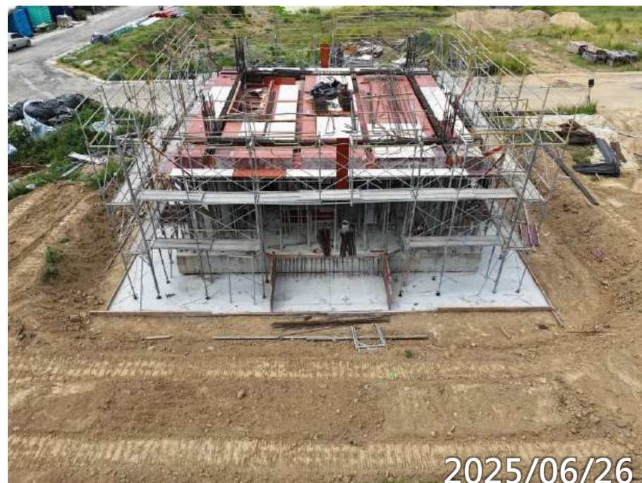
2F梁版鋼筋模版水電施作 施工架搭設
