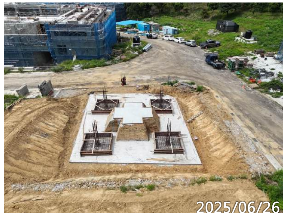
基礎版鋼筋模板水電施作
