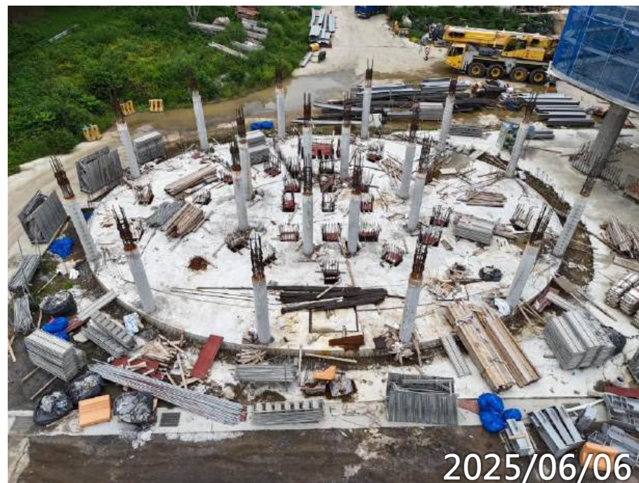
筏基清潔拆模口回封
