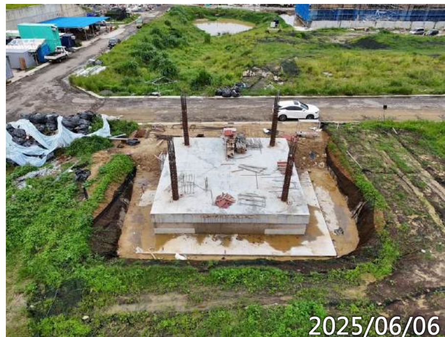
1F柱鋼筋綁紮 土方回填
