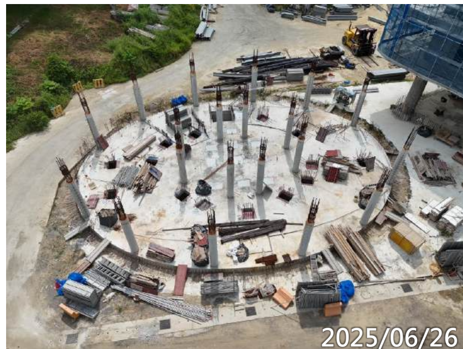
筏基清潔拆模口回封
