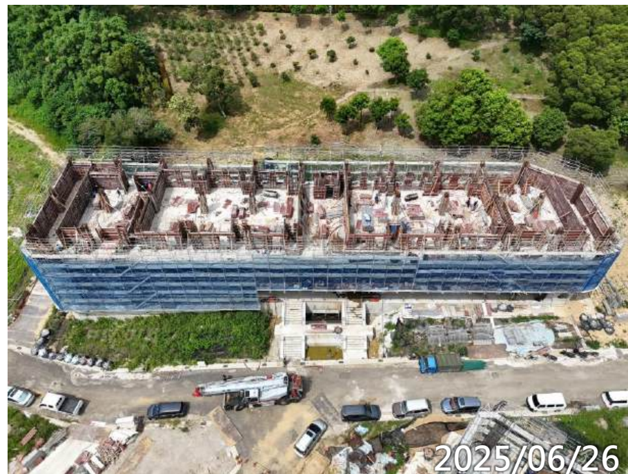
3F柱牆鋼筋綁紮、單面模施作 B1F泥作打底粉刷
