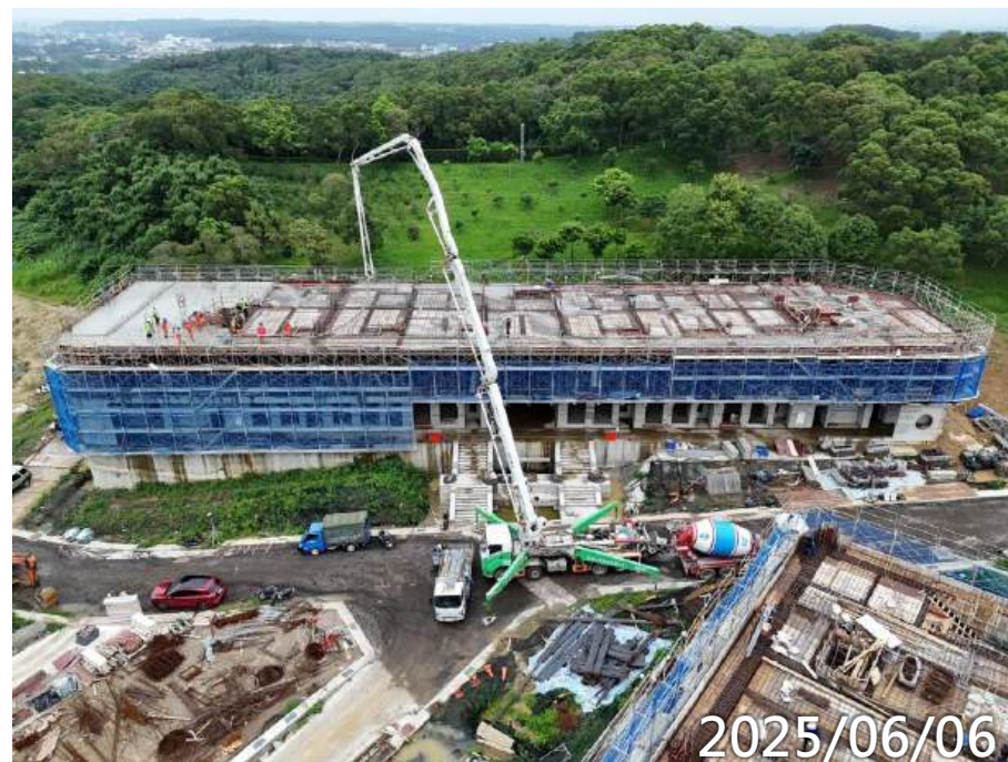
2F柱牆、3F梁版澆置 B1F泥作吊線
