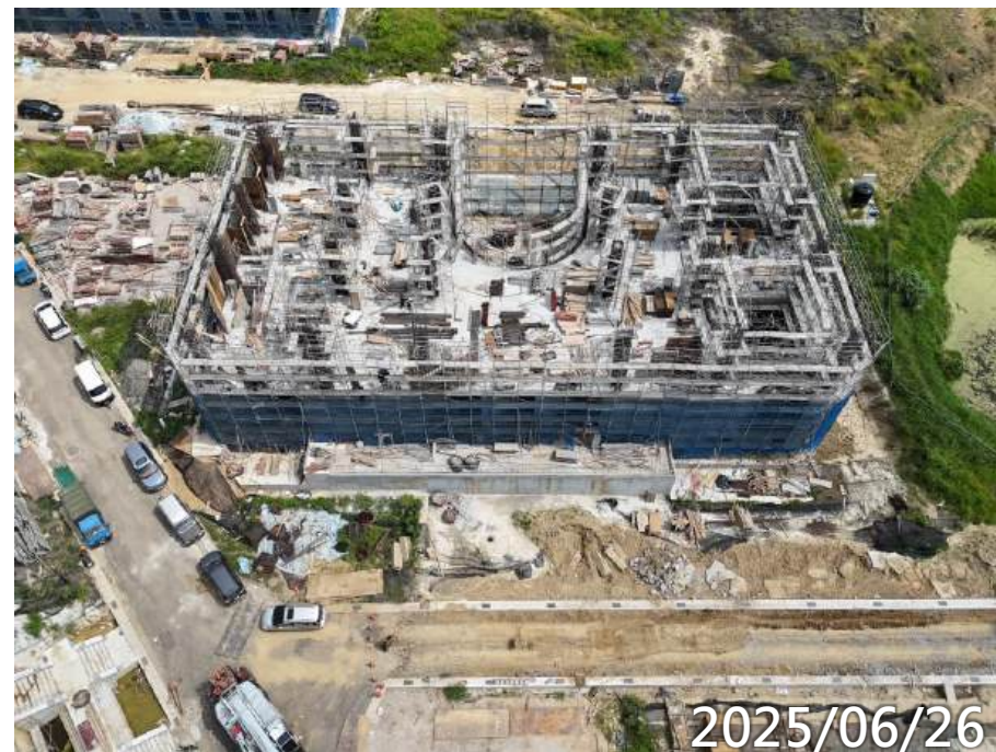
2F柱牆鋼筋模板施作
