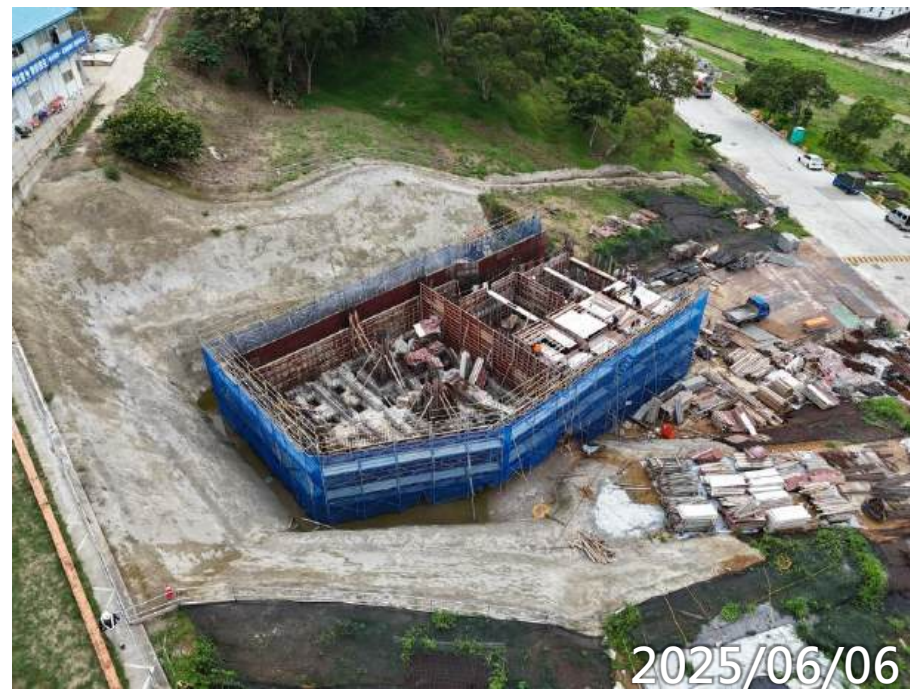
高版區2F柱牆鋼筋水電施作
