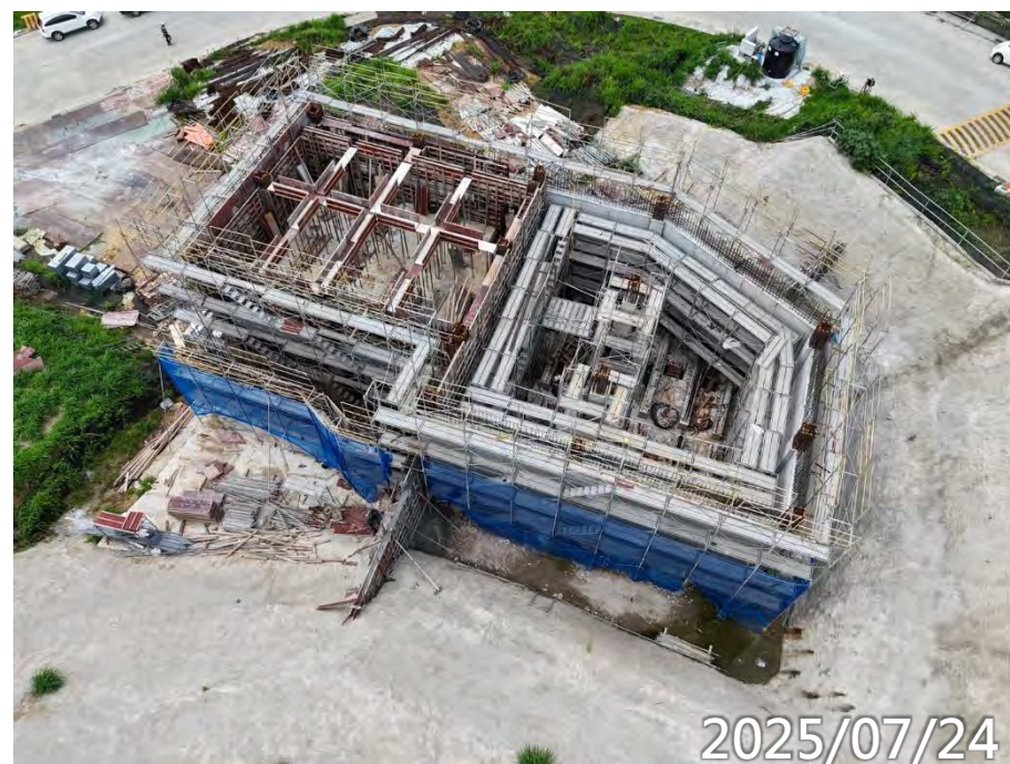
高版區3F柱牆鋼筋模板水電
