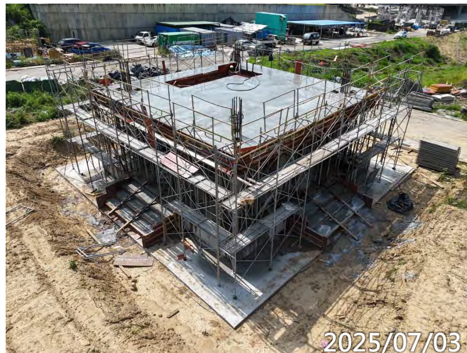
2F梁版澆置
