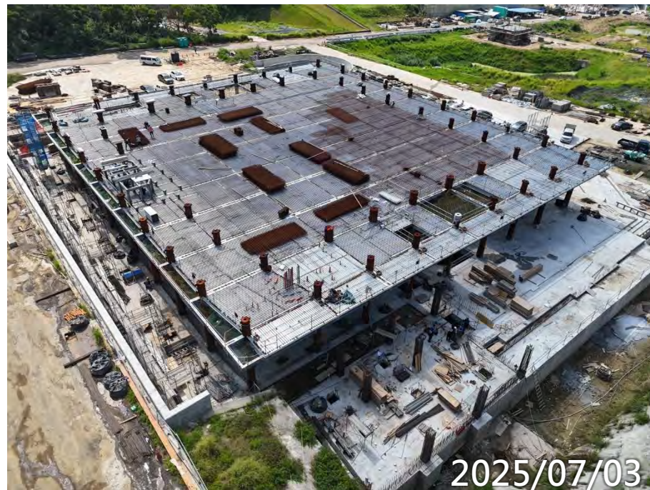
2F水電放樣、鋼筋綁紮
