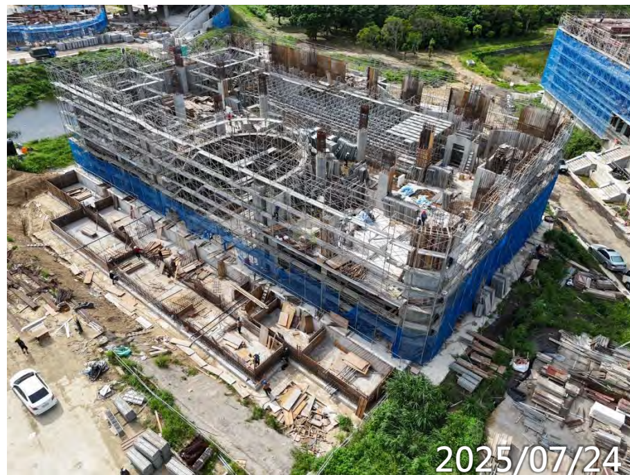
2F柱牆鋼筋模板施作 1F景觀梯施作 B1F泥作打底
