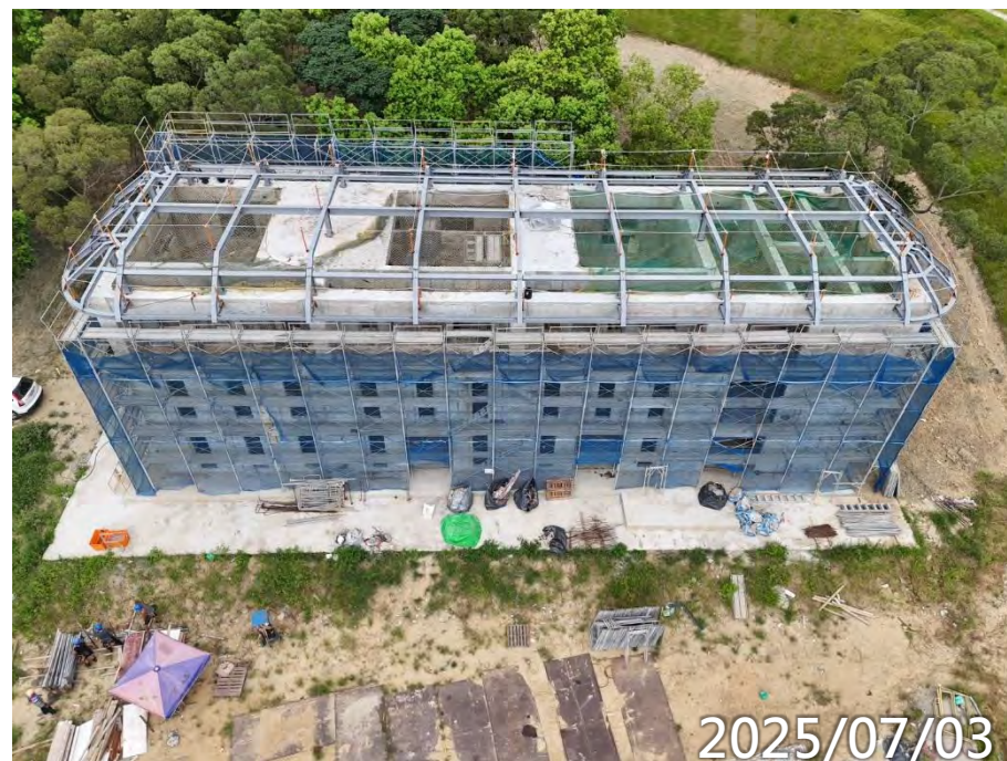
B1F-2F泥作打底 B1F-2F輕隔間放樣 屋頂鋼構電銲校正
