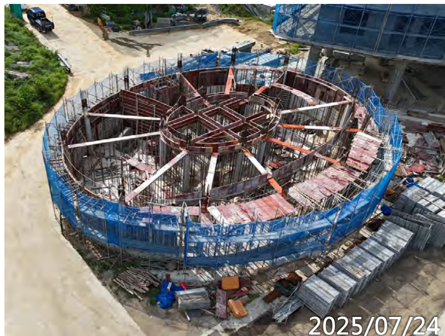
2F梁版模板施作
