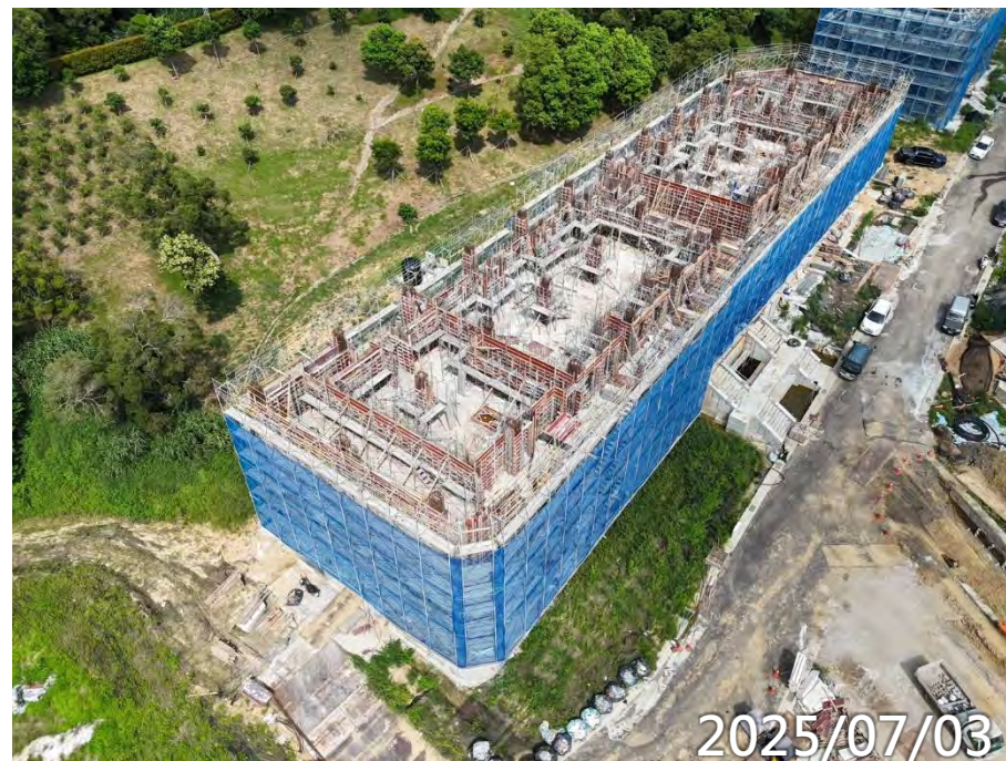
3F柱牆鋼筋模板水電 B1F泥作打底粉刷
