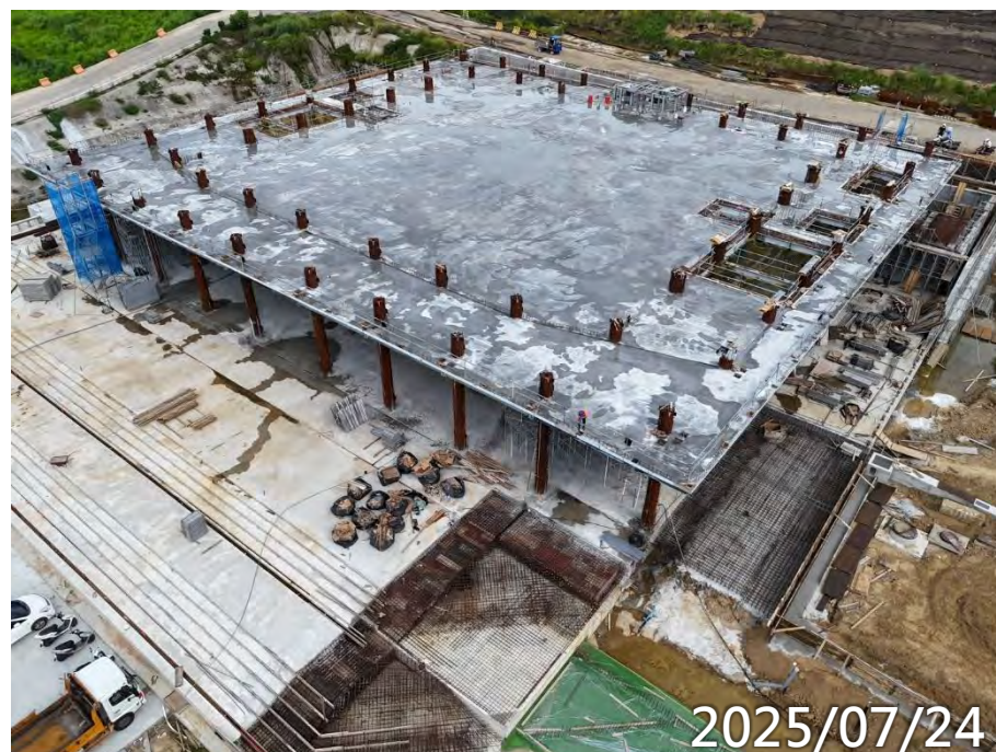
2F版澆置 車道頂版聚脲防水施作
