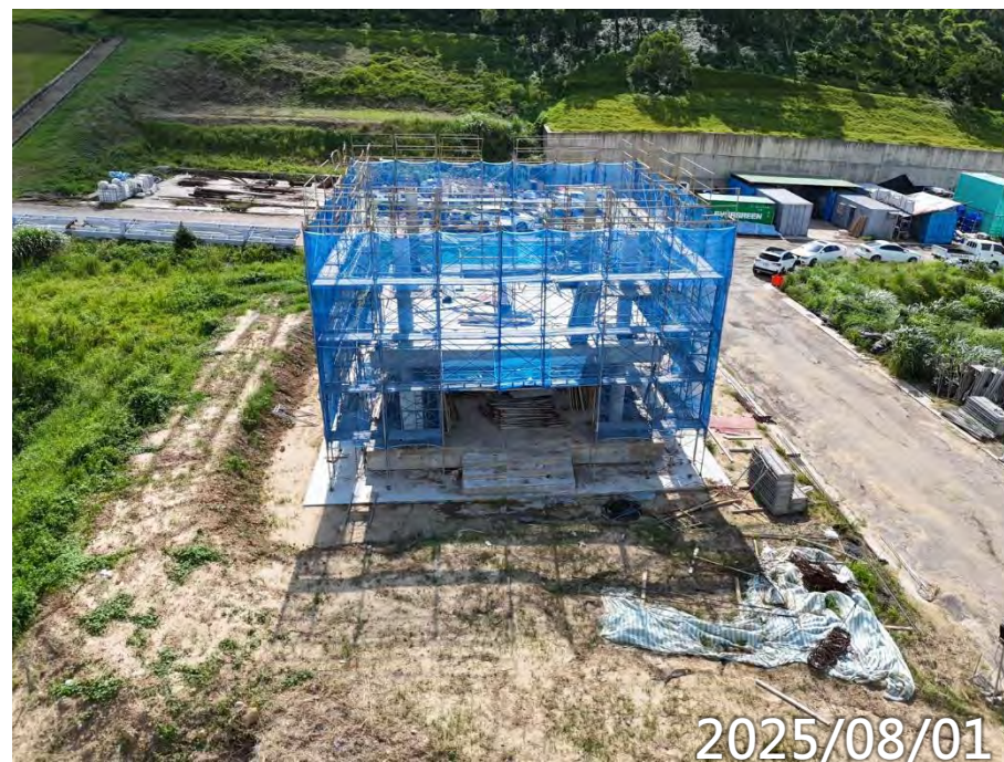
鋼構屋頂待吊裝
