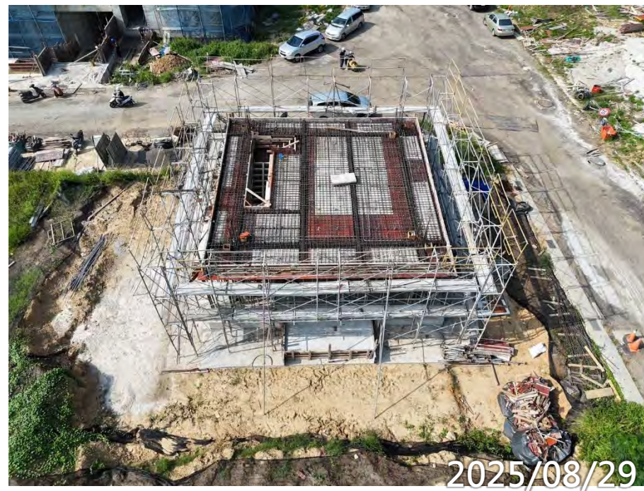
2F梁版鋼筋模板施作 木欄杆基座預埋
