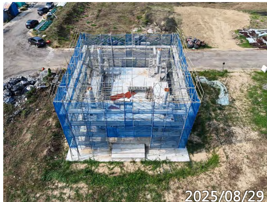
鋼構屋頂待吊裝
