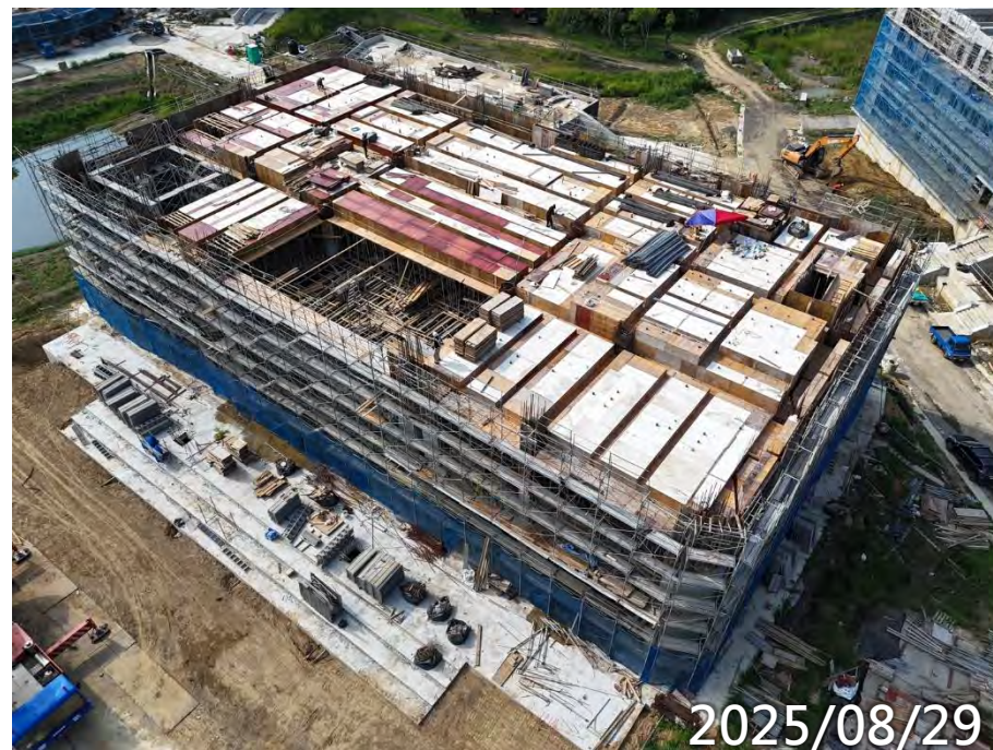
3F梁版鋼筋模板施作 B1F泥作打底
