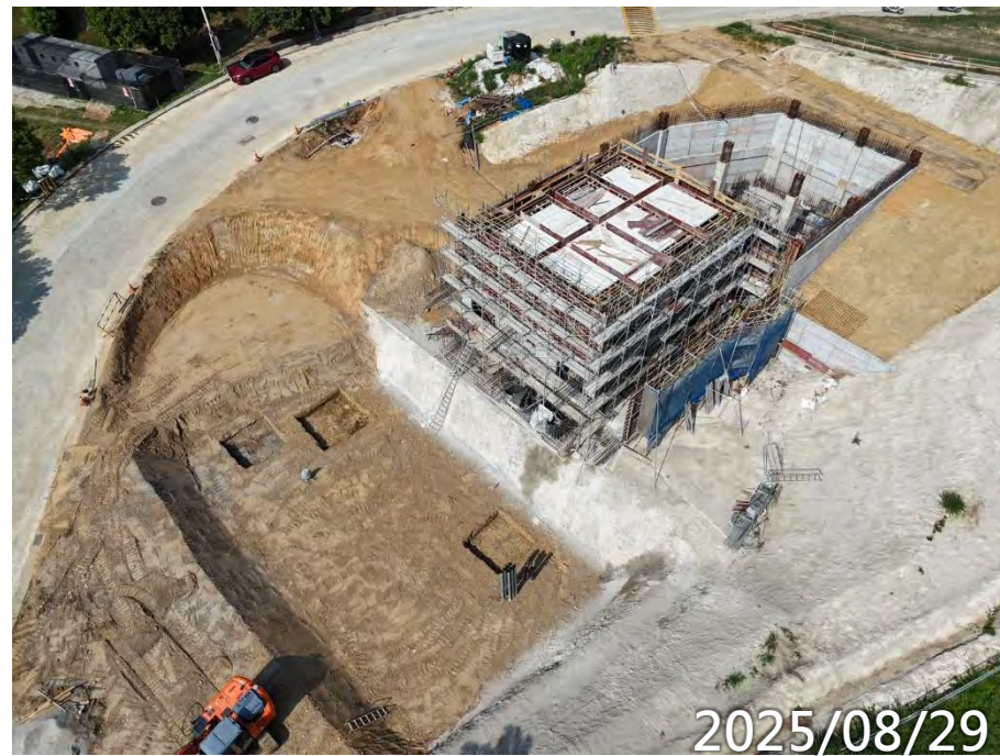
高版區RF梁版鋼筋模板水電 低版區土方開挖、五大管路引進
