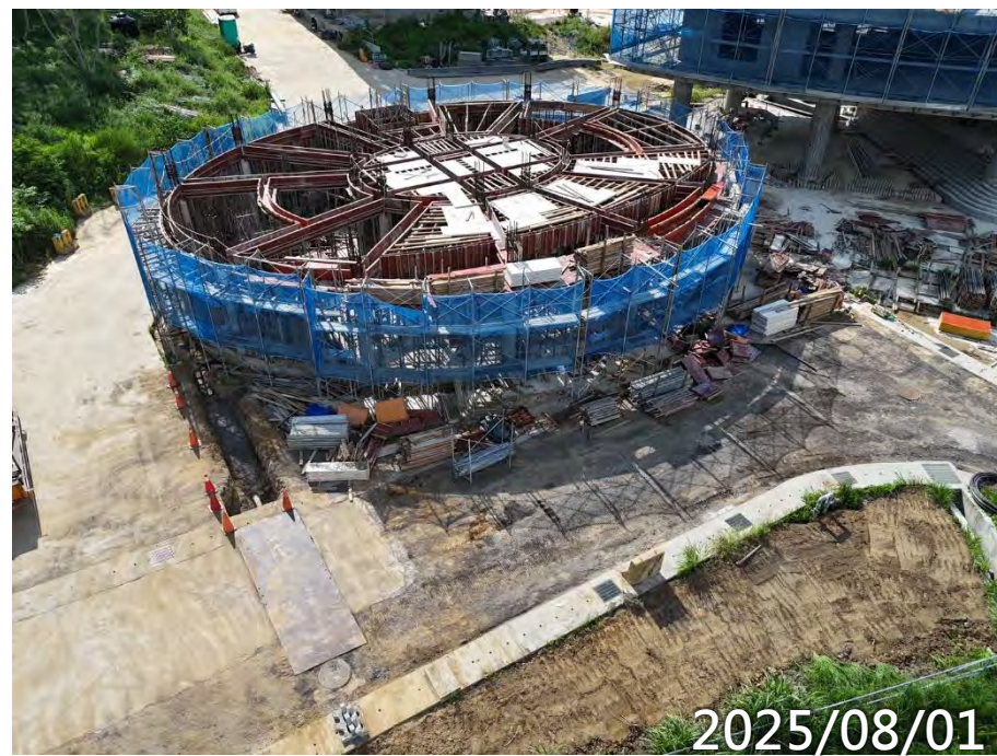
2F梁版模板施作
