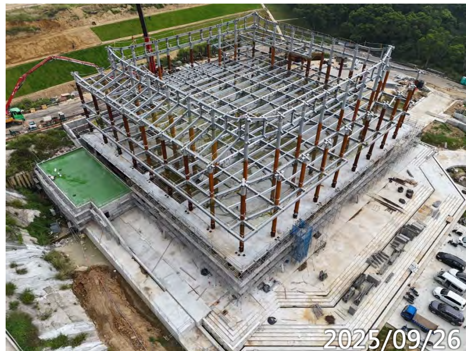
鋼構3F梁柱、下層屋簷吊裝 B2F-B1F泥作吊線 聚脲防水施作
