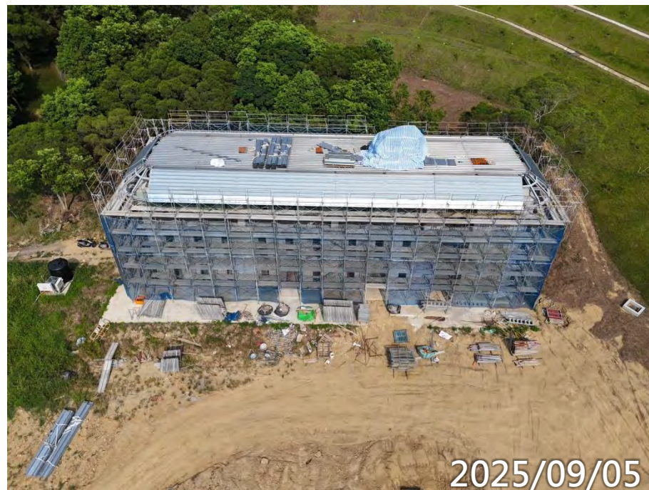
金屬屋頂防火層施作 B1F-2F泥作打底 B1F-2F輕隔間放樣 機電配管拉線
