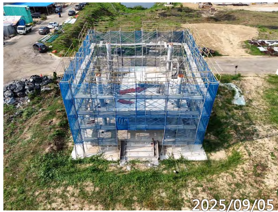
鋼構屋頂待吊裝
