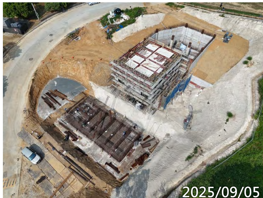
高版區RF梁版鋼筋模板水電 低版區基礎層鋼筋綁紮
