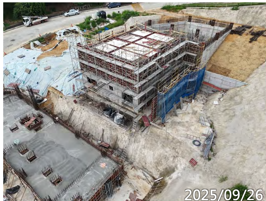
高版區RF梁版鋼筋模板水電 低版區基礎層澆置
