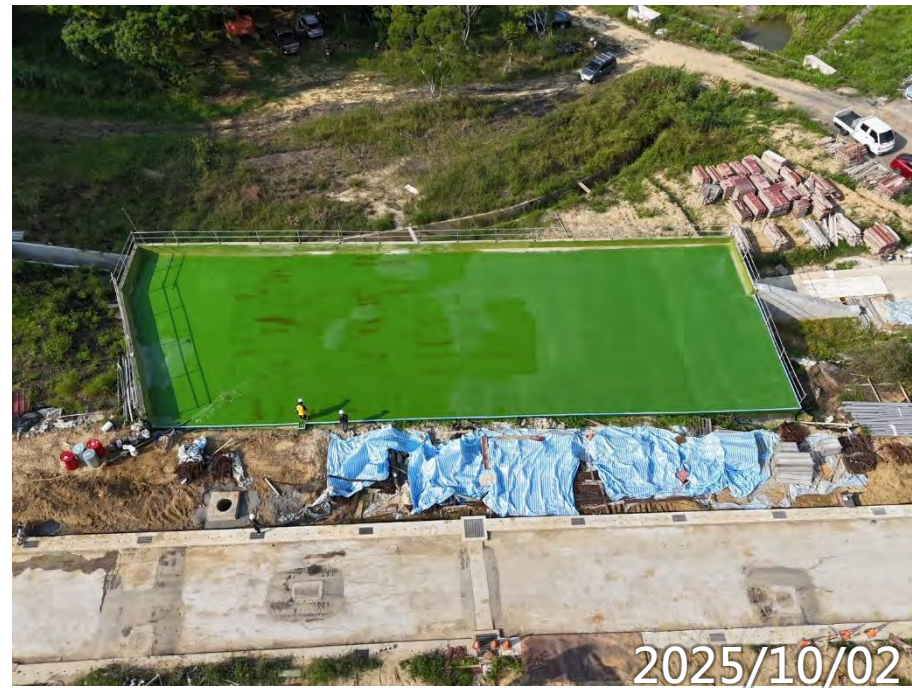
屋頂聚脲防水試水
