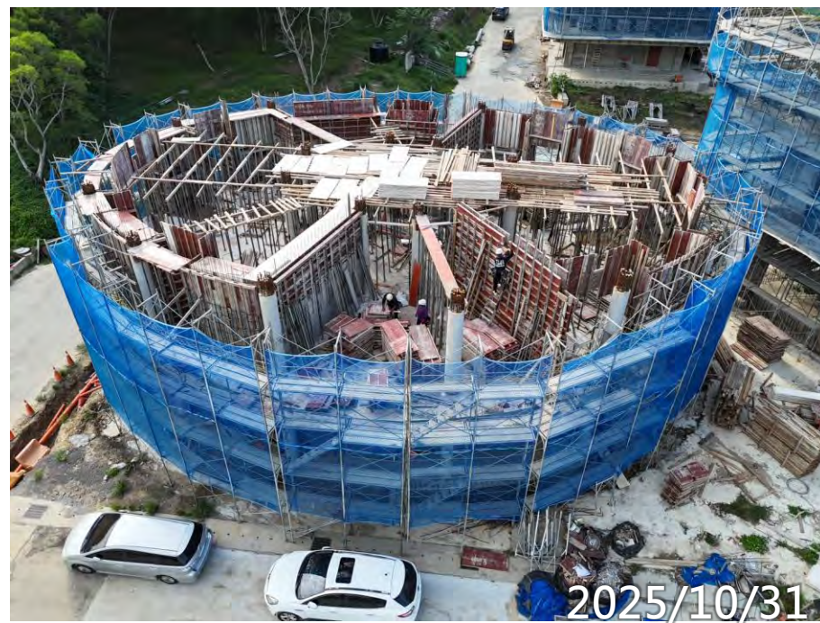
RF梁鋼筋模板水電施作
