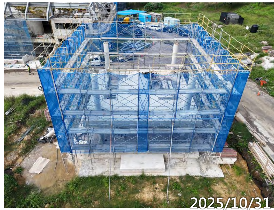
鋼構屋頂待吊裝
