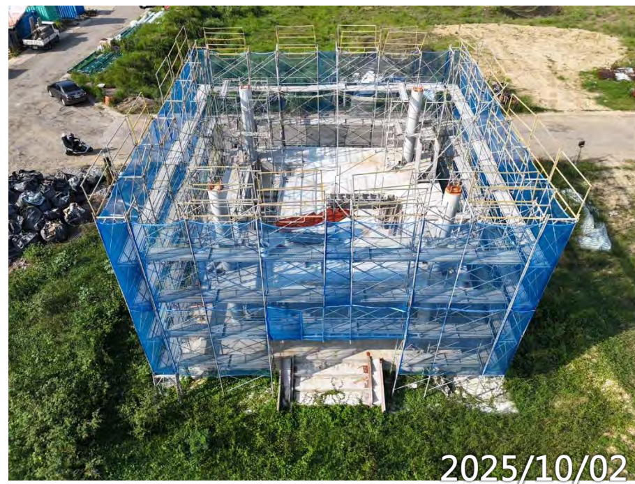
鋼構屋頂待吊裝
