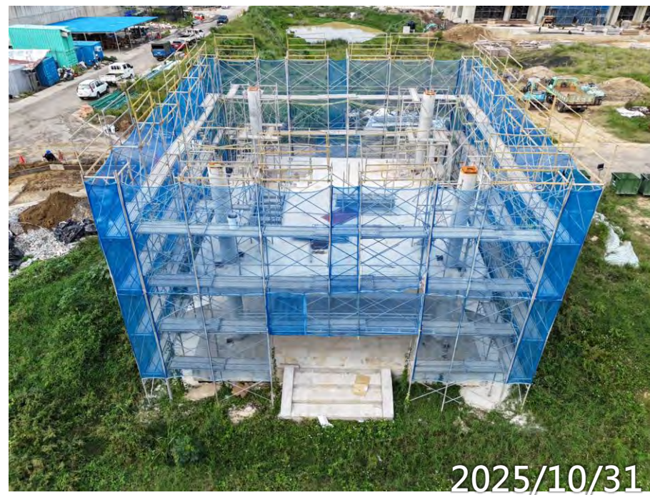
鋼構屋頂待吊裝
