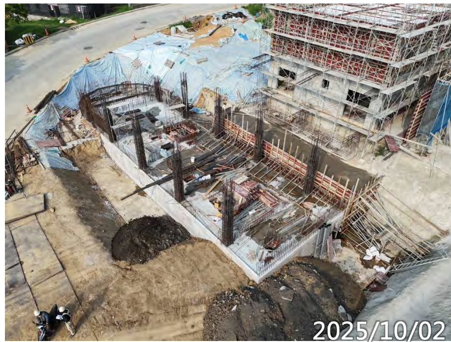
高版區RF梁版鋼筋模板水電 高低版交界CLSM回填 低版區1F柱續接
