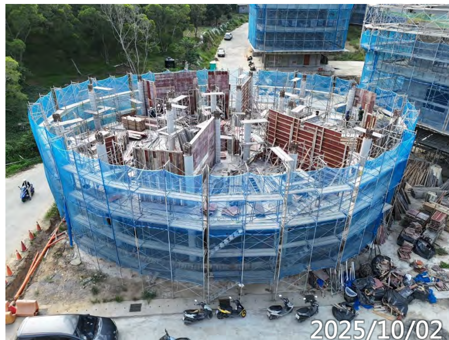
2F牆鋼筋模板水電施作
