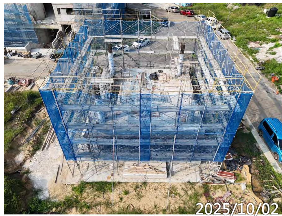
2F柱澆置 屋頂鋼構預埋
