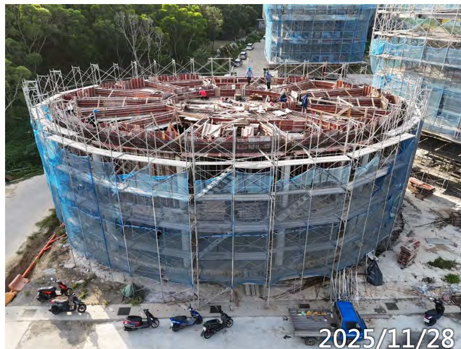
RF梁鋼筋模板水電施作 筏基配管
