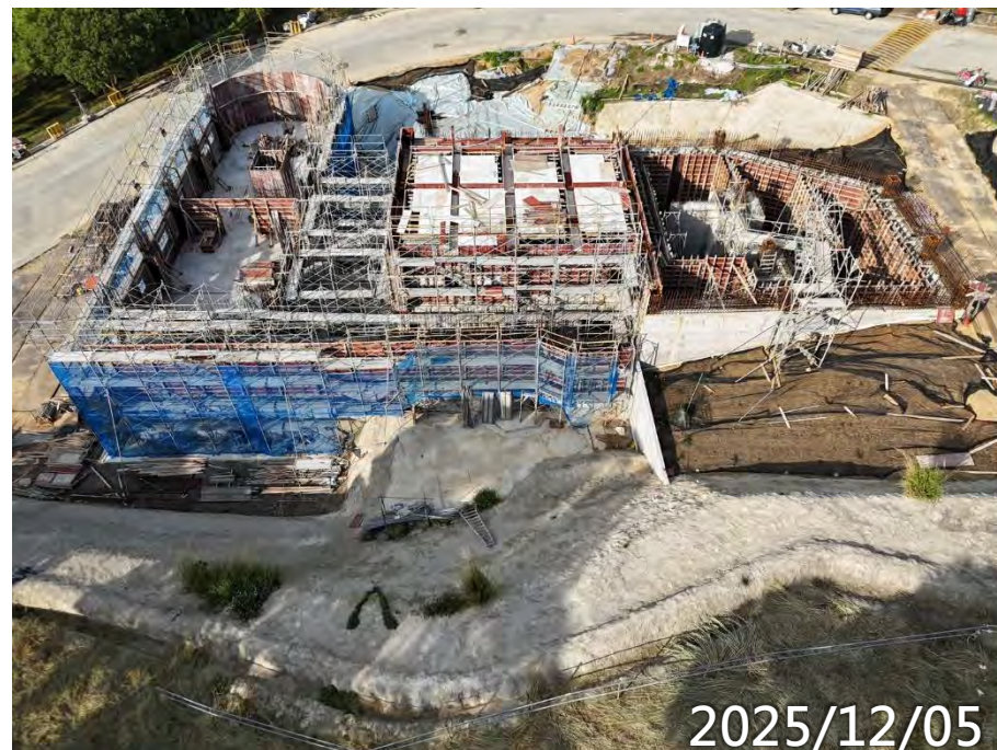
高版區水箱鋼筋模板水電 低版區2F柱牆鋼筋模板水電
