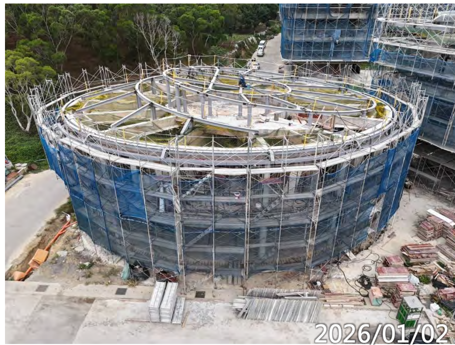
屋頂鋼構電鍍校正
