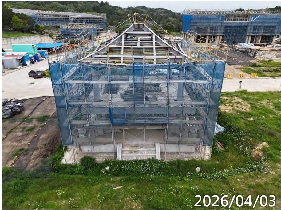
鋼構屋頂電銲校正 1F泥作
