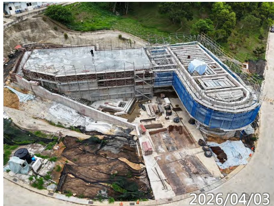
高版區頂版澆置 戶外景觀樓梯澆置
