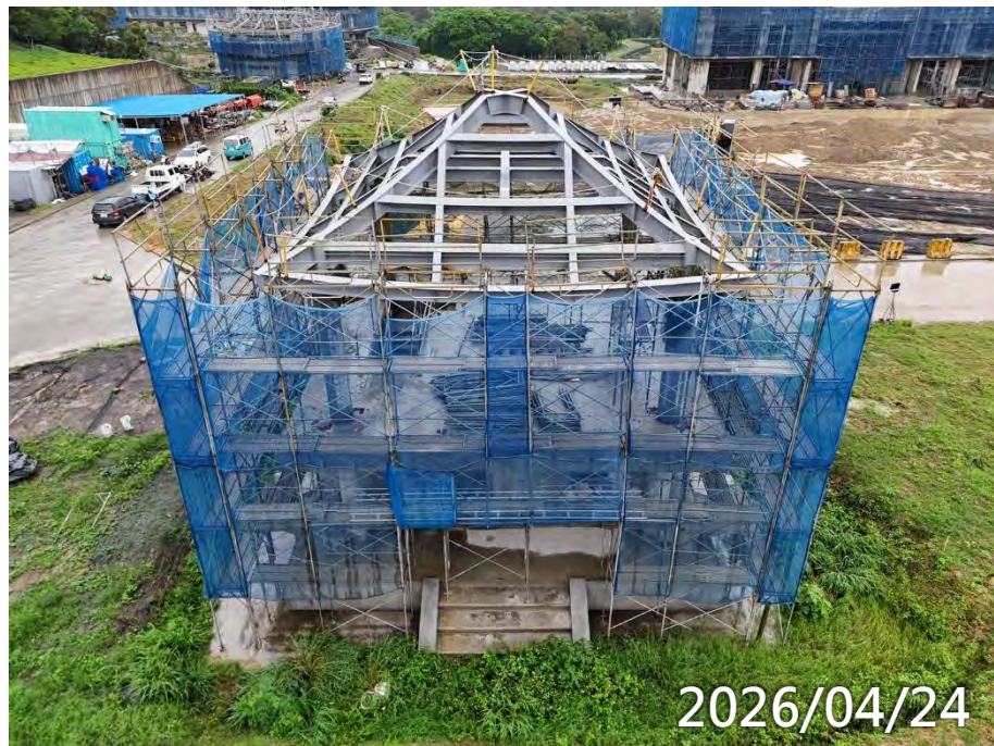
鋼構屋頂電鍍校正 1F泥作
