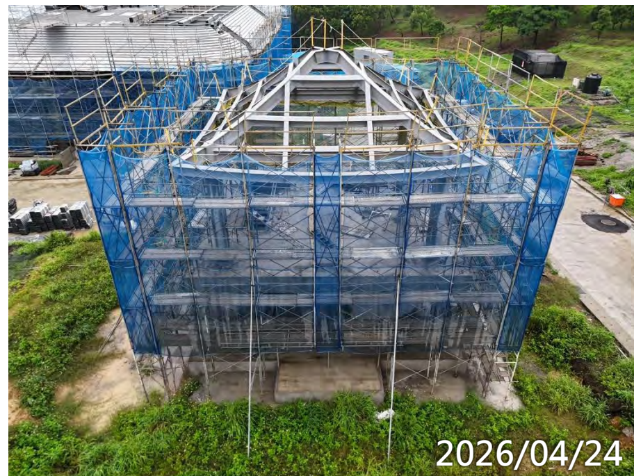
鋼構屋頂電銲校正 1F泥作
