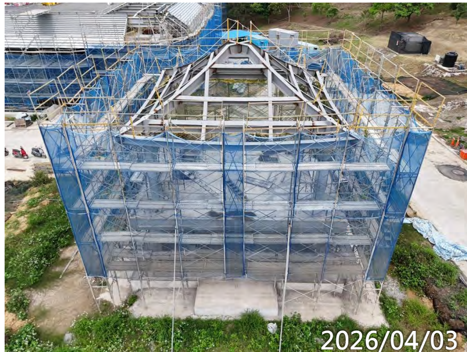
鋼構屋頂電銲校正 1F泥作
