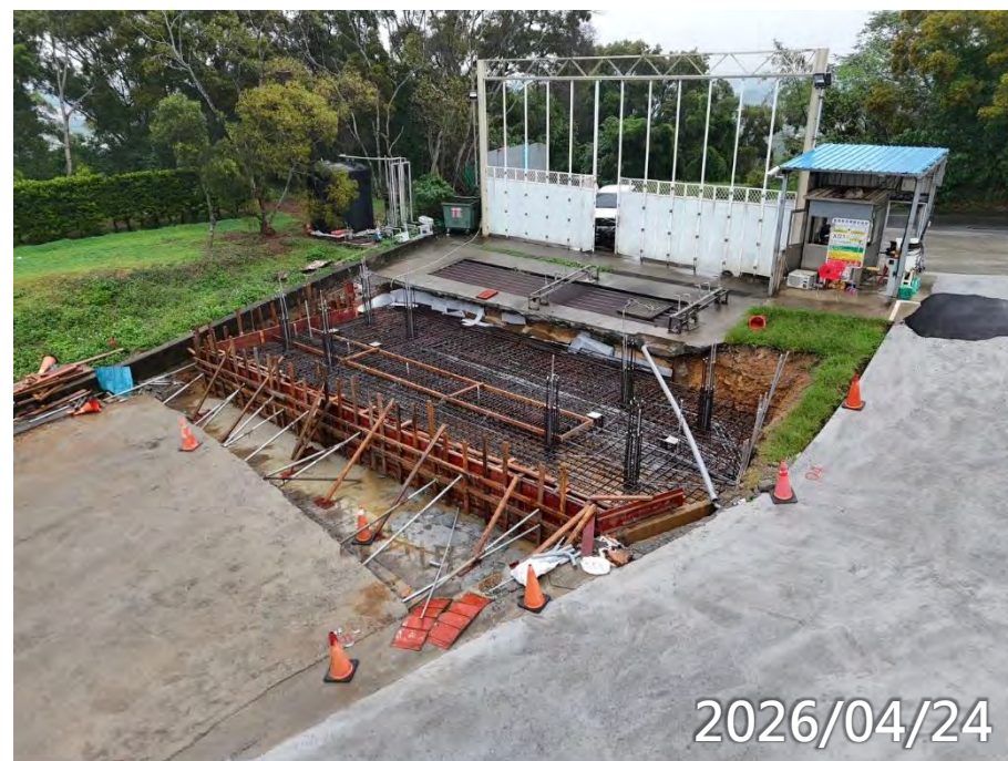
基礎版鋼筋綁紮
