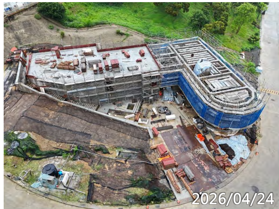
1F-2F泥作、戶外欄杆預埋施作
