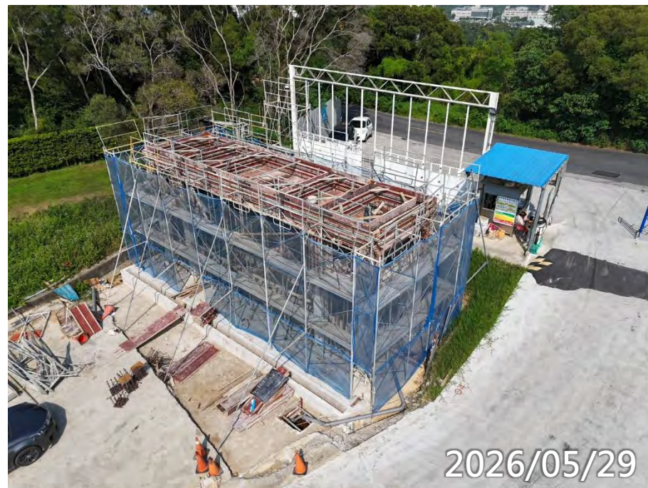
屋頂鋼構預埋
