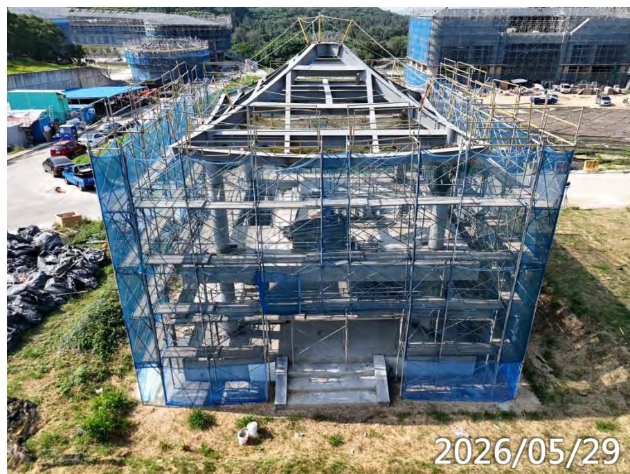
鋼構屋頂電銲校正 1F泥作
