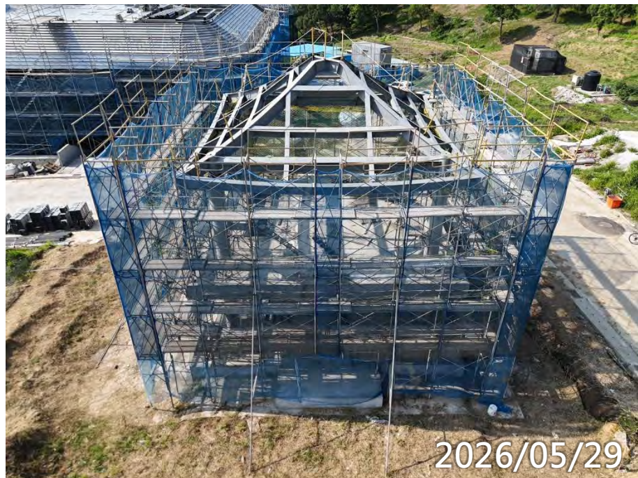
鋼構屋頂電銲校正 1F泥作
