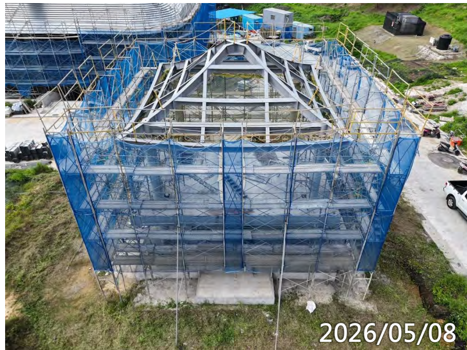
鋼構屋頂電銲校正 1F泥作
