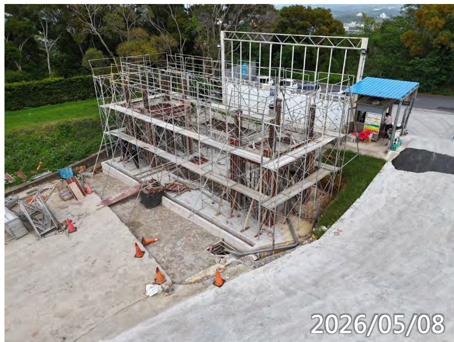
柱鋼筋模板水電施作
