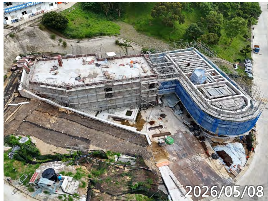
1F-2F泥作、戶外欄杆預埋施作
