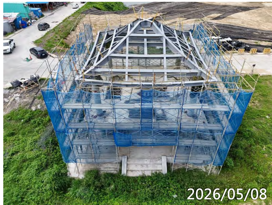
鋼構屋頂電銲校正 1F泥作
