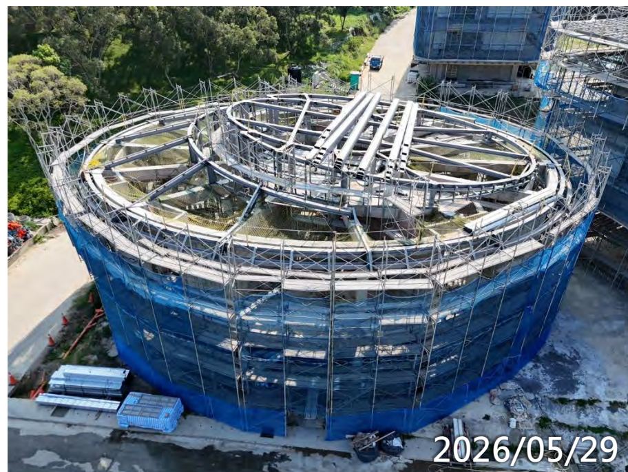
金屬屋頂防火層施作 1F-2F泥作、輕隔間、油漆、 鋁窗、金屬門施作
