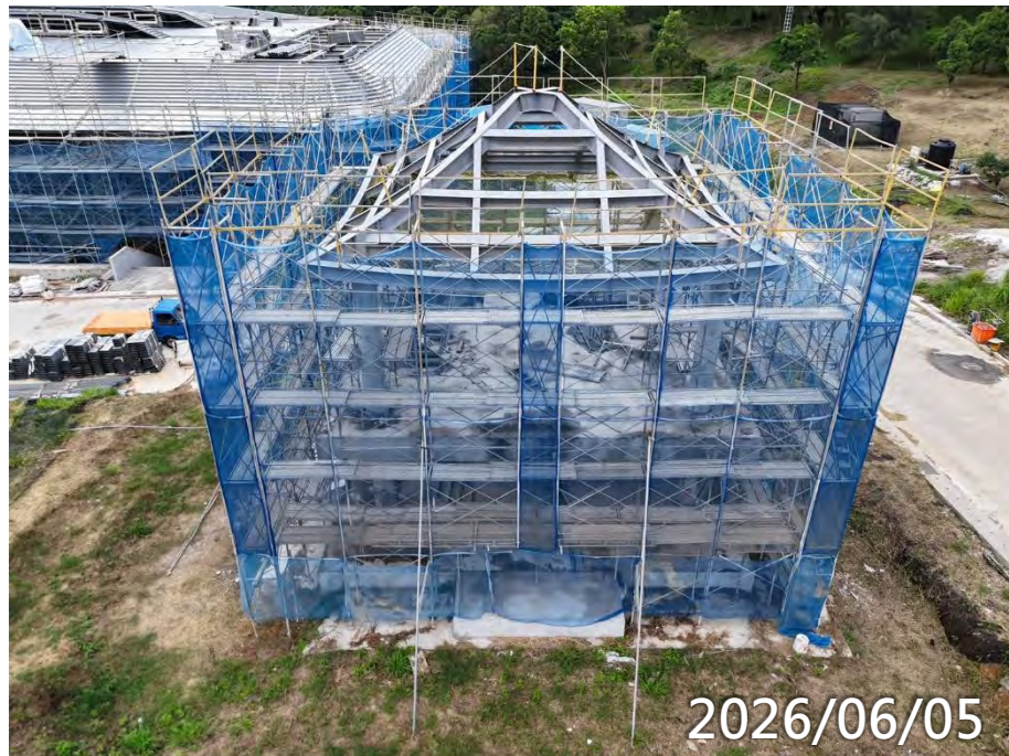
待金屬屋頂施作 1F泥作
