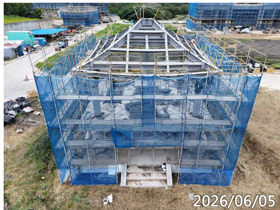
待金屬屋頂施作 1F泥作
