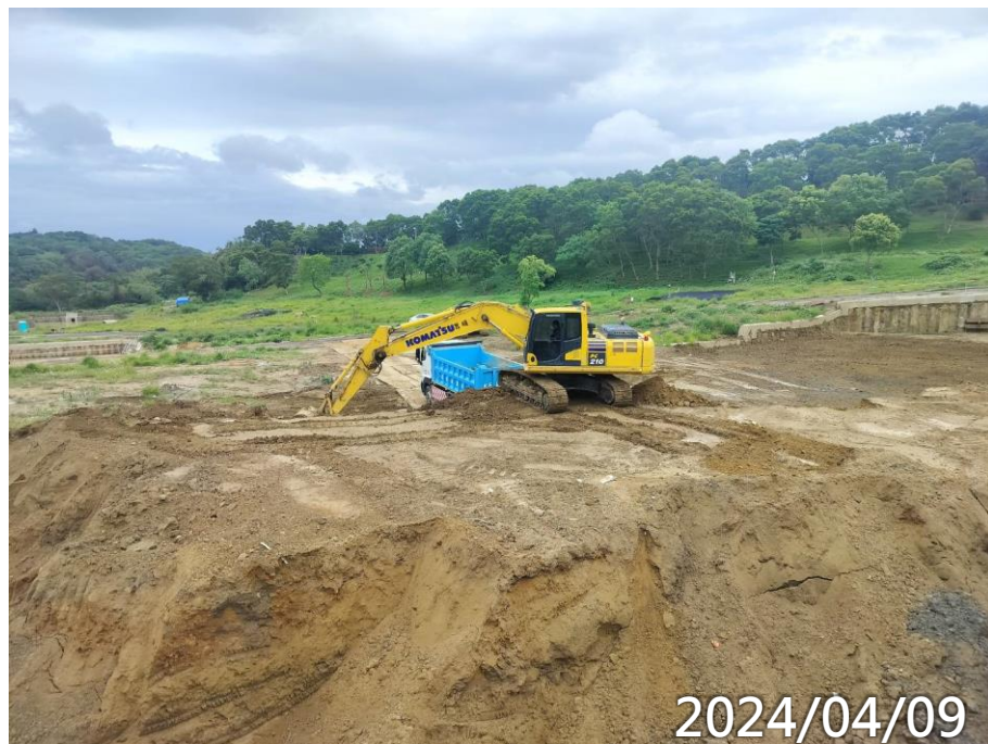
齋堂第二層土方開挖
