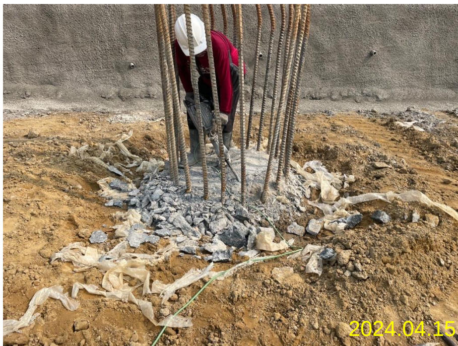
主殿樁頭劣質打除
