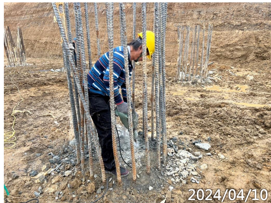
主殿基樁樁頭劣質打除
