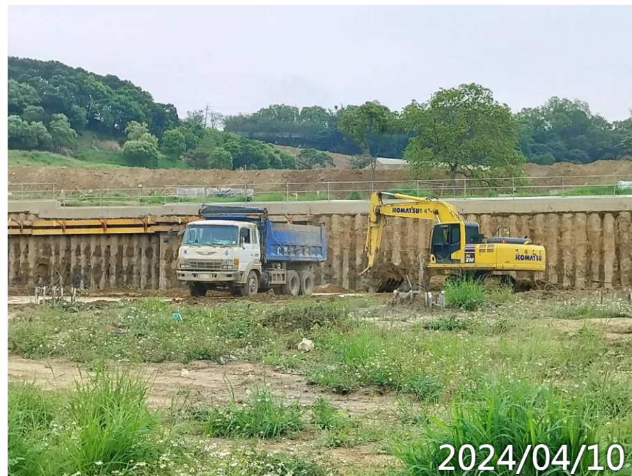
齋堂第二層土方開挖
