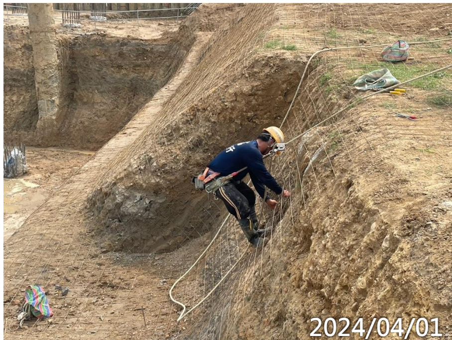
主殿噴漿護坡
