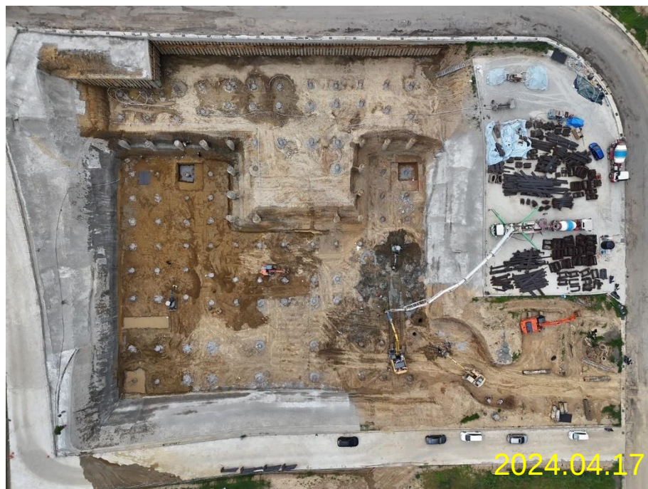
主殿土方開挖
