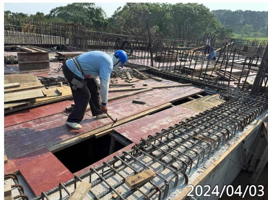
女寮1區B1F版鋼筋綁紮
