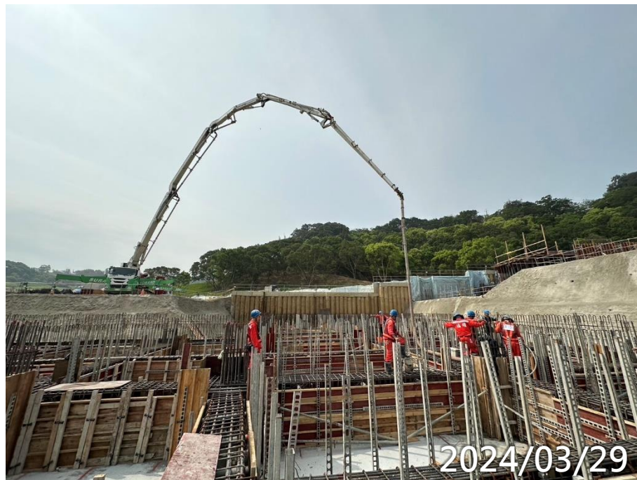
女寮1區地梁澆置
