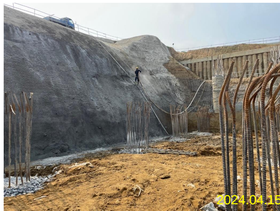
主殿噴漿護坡
