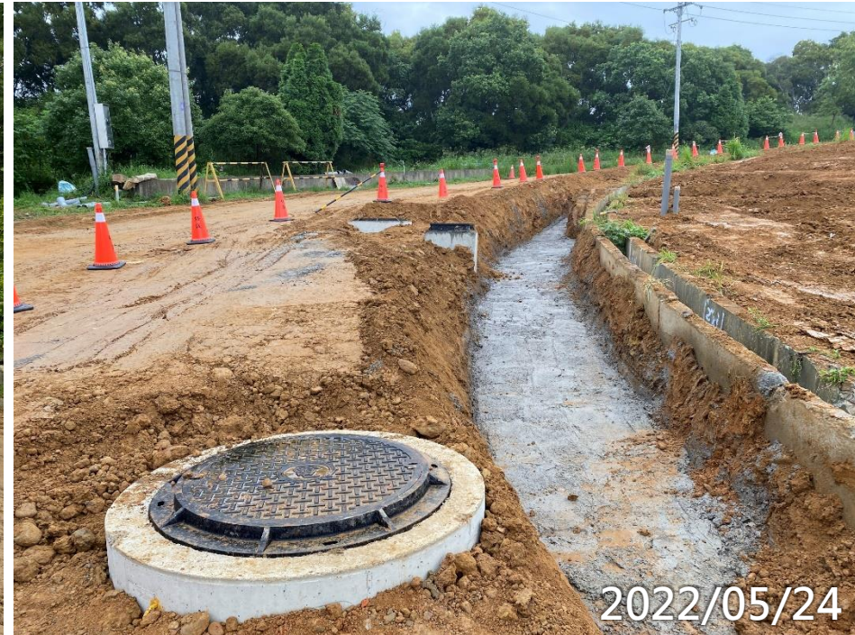
給水及消防管路CLSM打底
