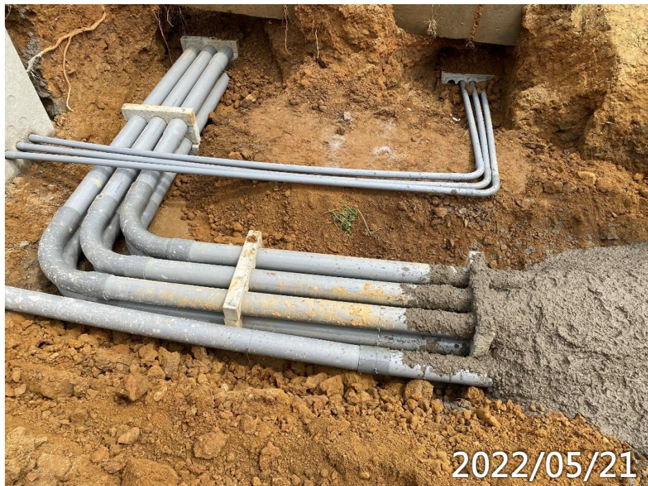
高壓及弱電管路配管
