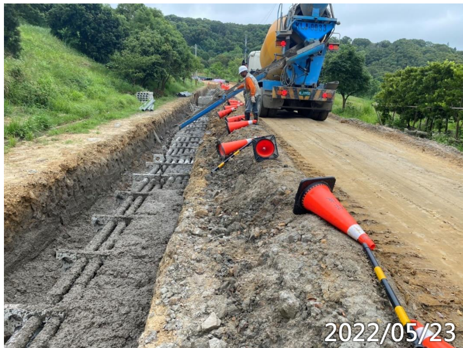
高低壓及弱電管路CLSM回填
