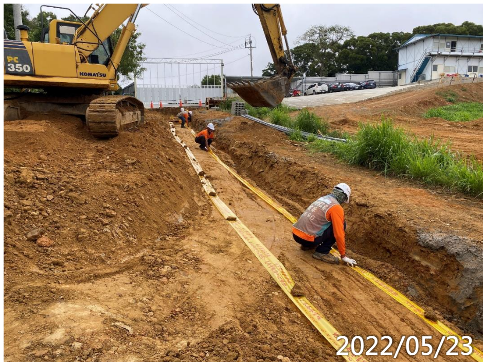
高低壓及弱電管路回填
