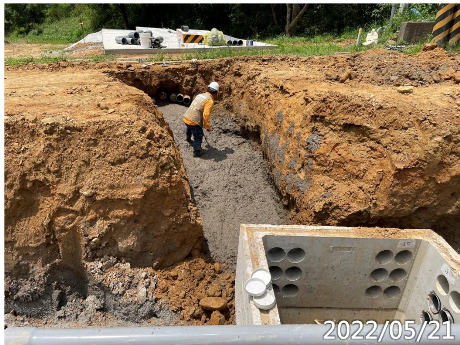
臨時變電站管路CLSM打底
