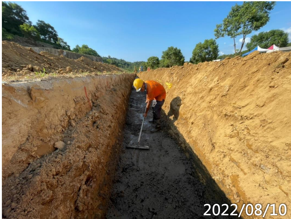
CM9至CM10給水管路CLSM打底 CM9至CM10給水管路CLSM打底
