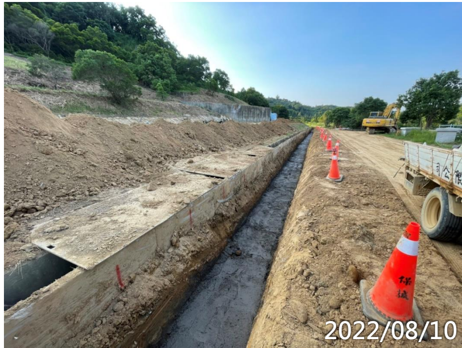
CM9至CM10給水管路CLSM打底 CM9至CM10給水管路CLSM打底
