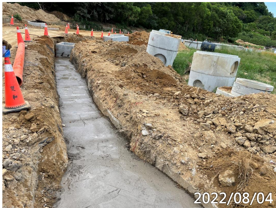
#5至#25污水管路CLSM回填
