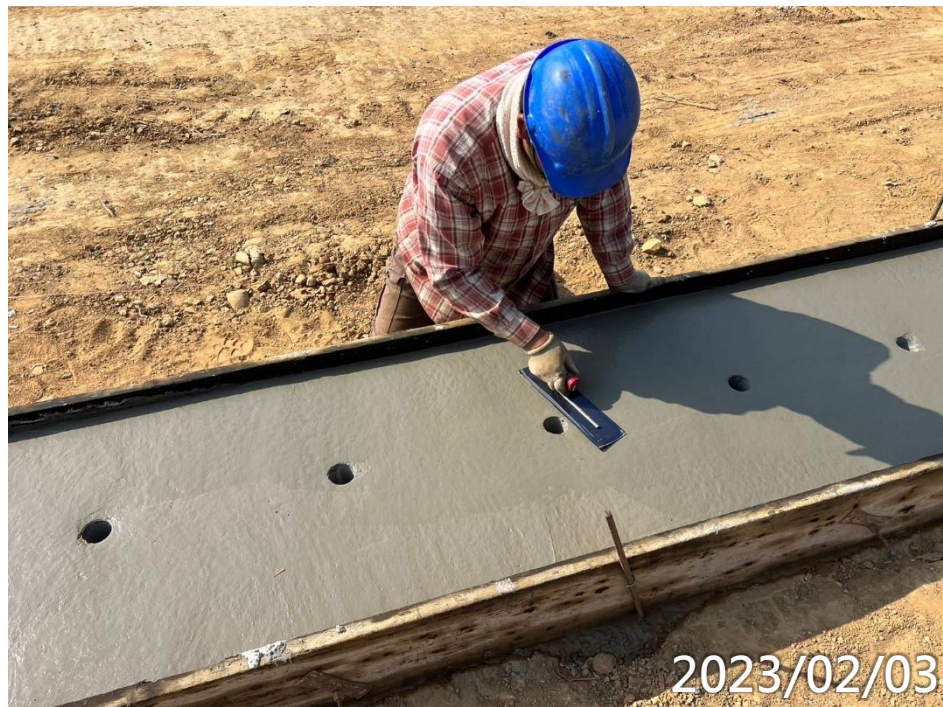
AU-45既有水溝加蓋施作
