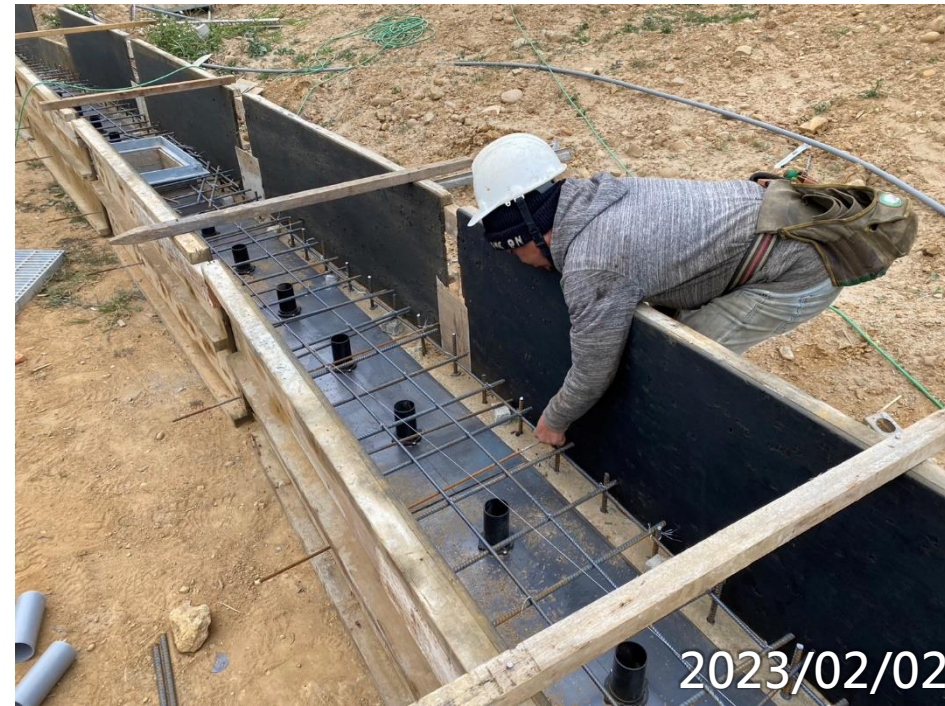
AU-45既有水溝加蓋施作
