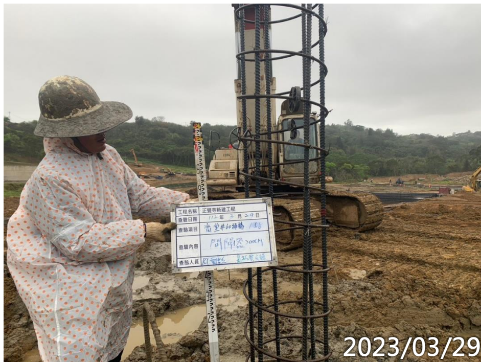
鋼筋間隔器查驗
