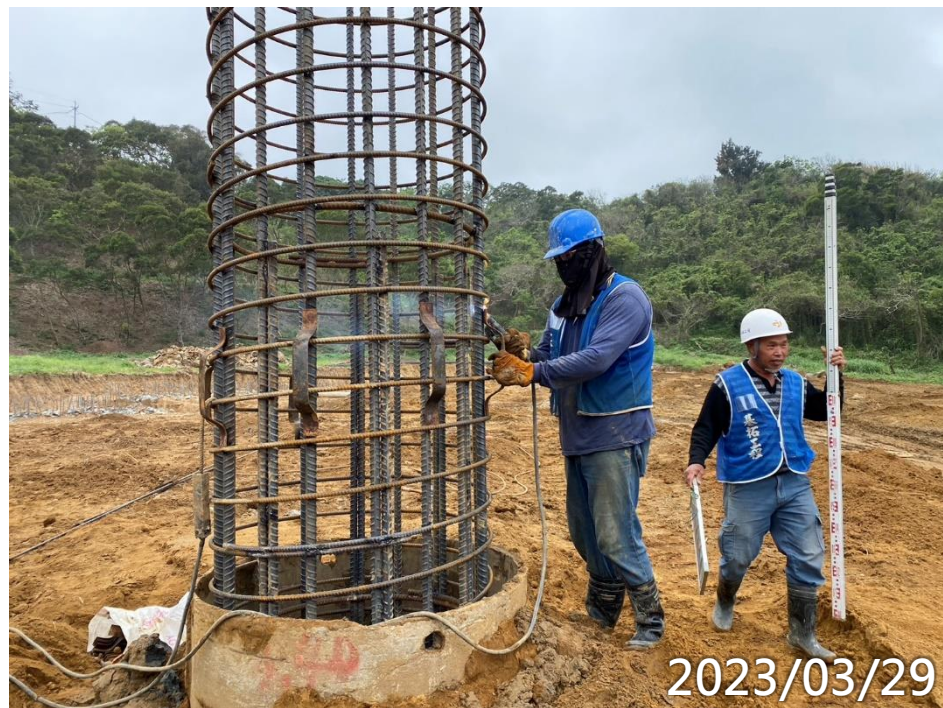
鋼筋籠護耳焊接
