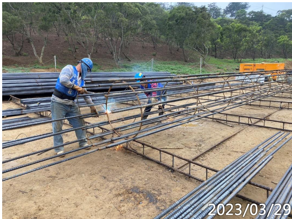
鋼筋籠焊接
