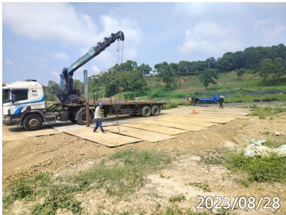
汙水廠、玄文動線鋼板鋪設
