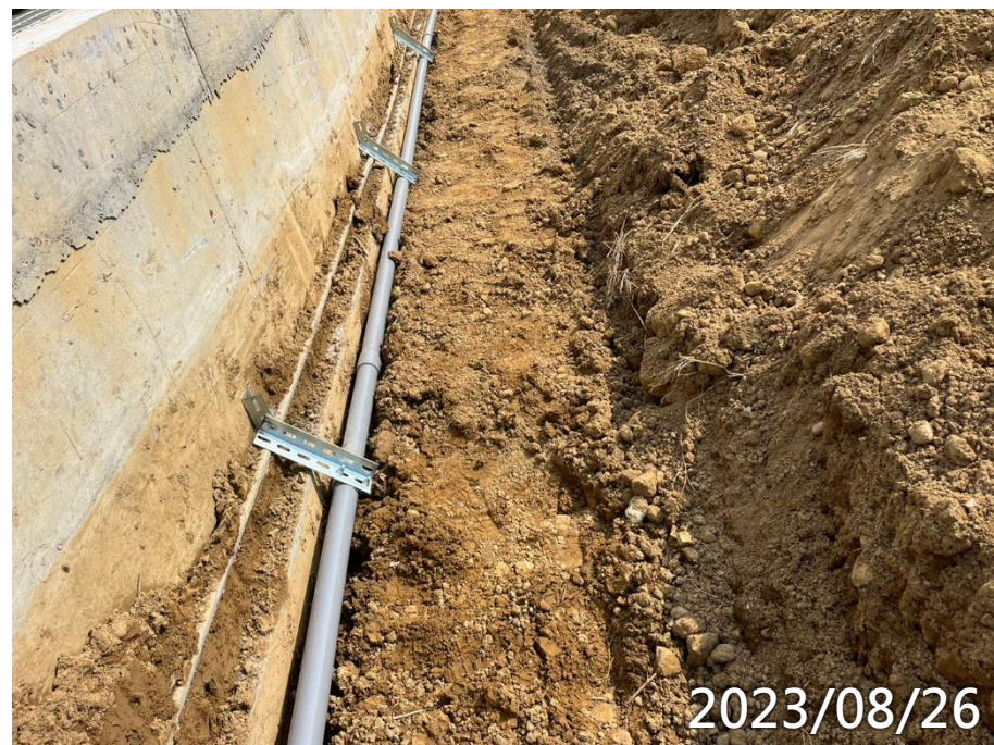
女寮臨時水管配管
