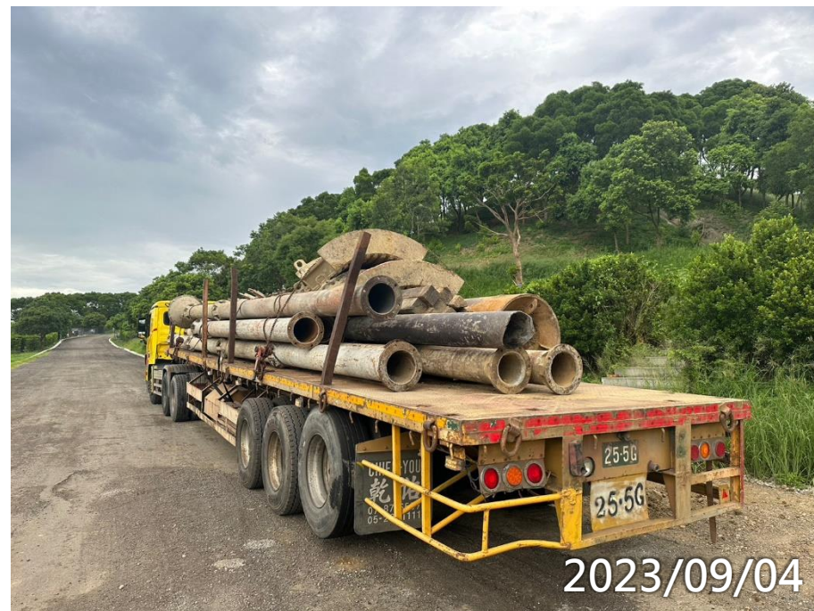
齋堂全套管基樁機具退場
