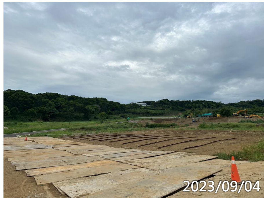
汙水廠、玄文動線鋼板鋪設
