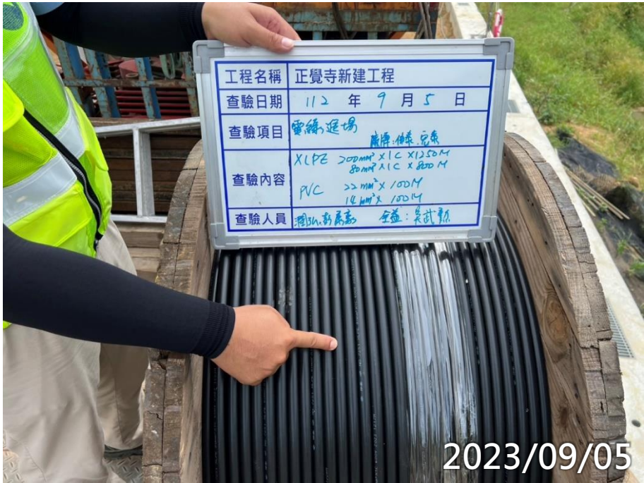
臨時電電線材料進場查驗
