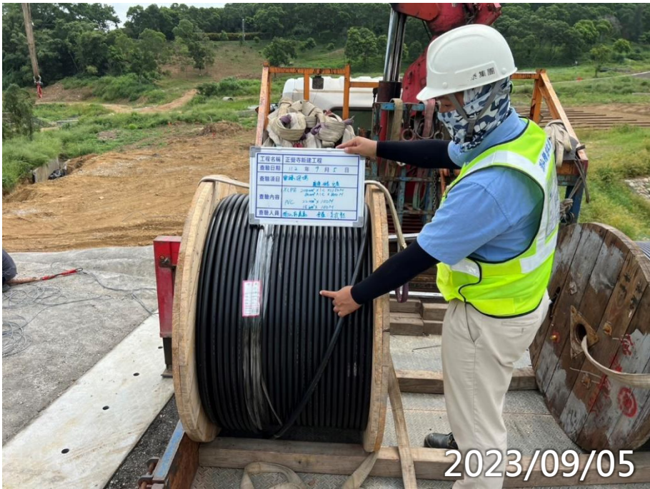
臨時電電線材料進場查驗
