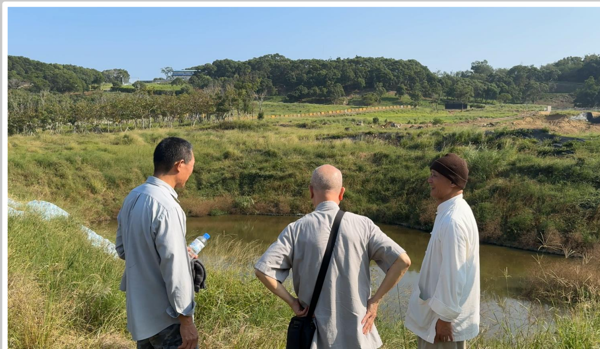
查看PA滯洪池 2023.12.08
