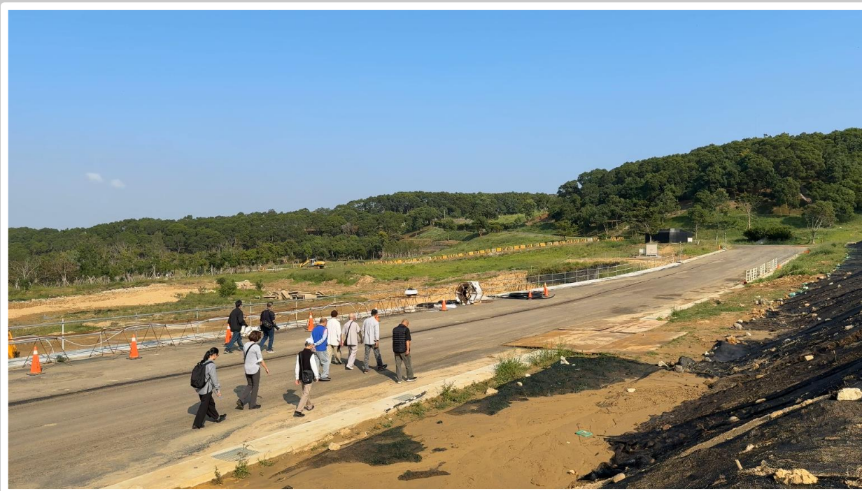
路面左側為主殿整地現況，路面右側為主殿 後方回填整地現況。 2023.12.08
