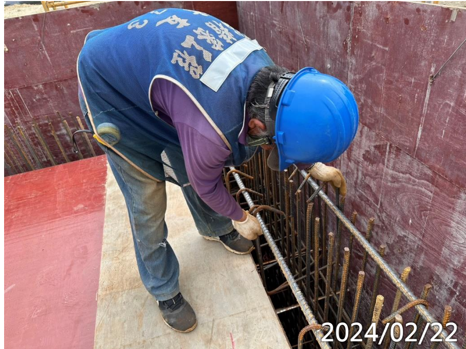
污水廠RF版梁鋼筋綁紮
