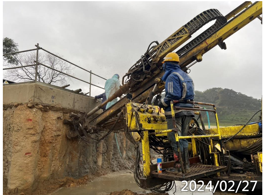
齋堂第一層地錨施作
