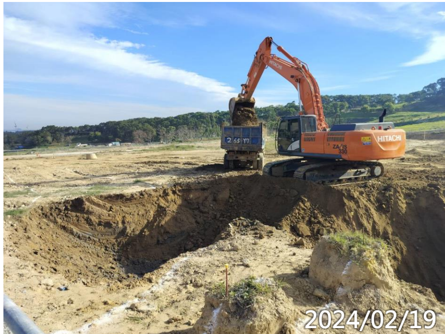
主殿土方開挖
