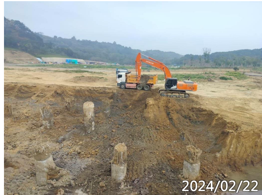
主殿土方開挖
