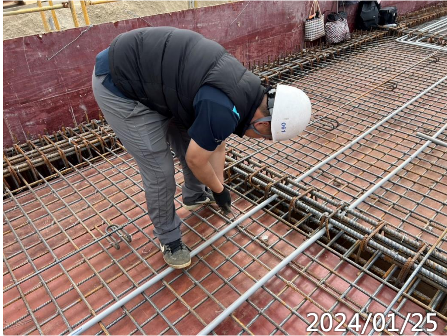
污水廠RF版水電配管
