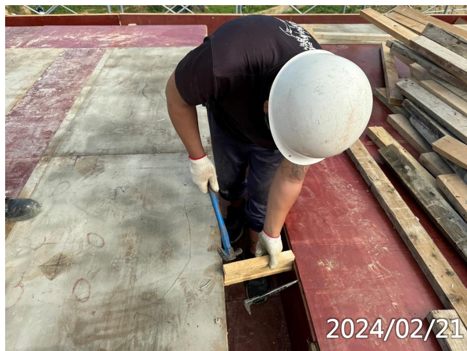
污水廠RF梁版模板組立
