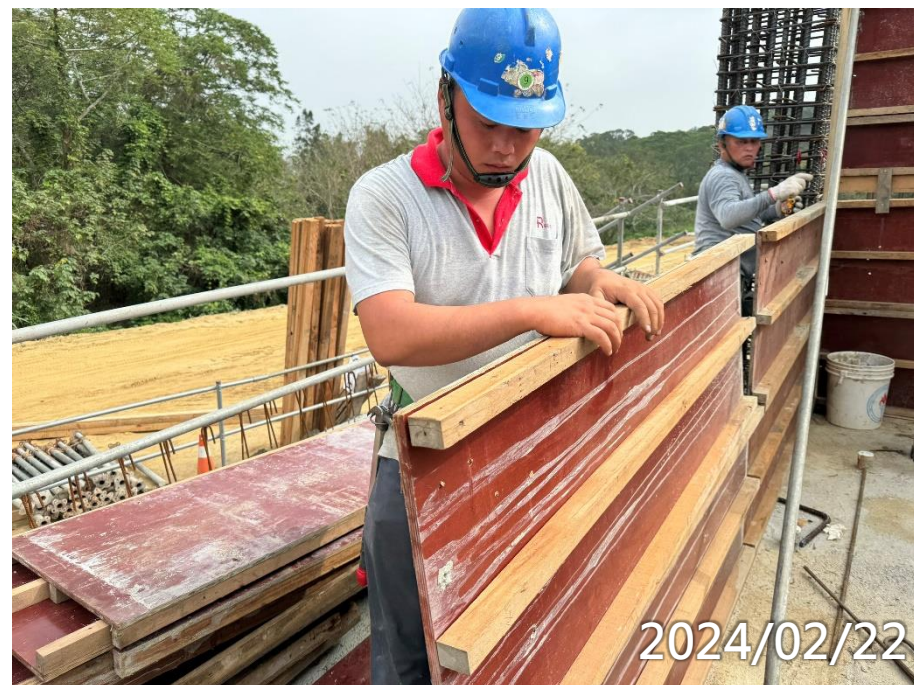
女寮2區1F柱牆模板組立
