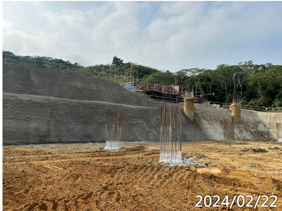
女寮1區噴漿護坡
