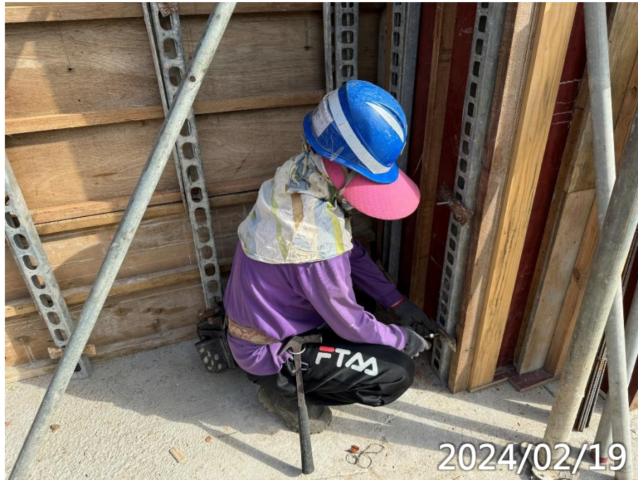
污水處理廠B1F柱牆模板組立
