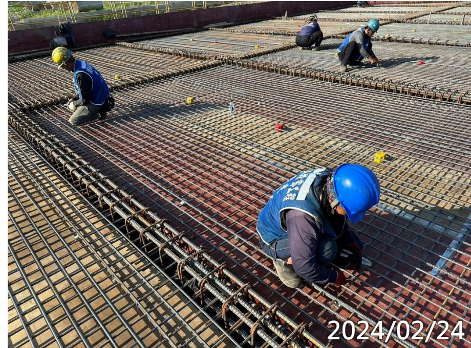
污水廠RF版梁鋼筋綁紮
