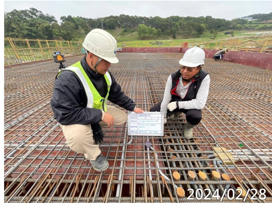
污水廠RF版水電配管查驗
