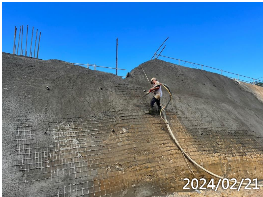
女寮1區噴漿護坡
