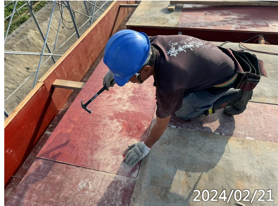
污水處理廠RF版梁模板組立
