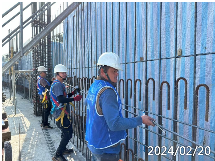
女寮2區1F柱牆鋼筋綁紮
