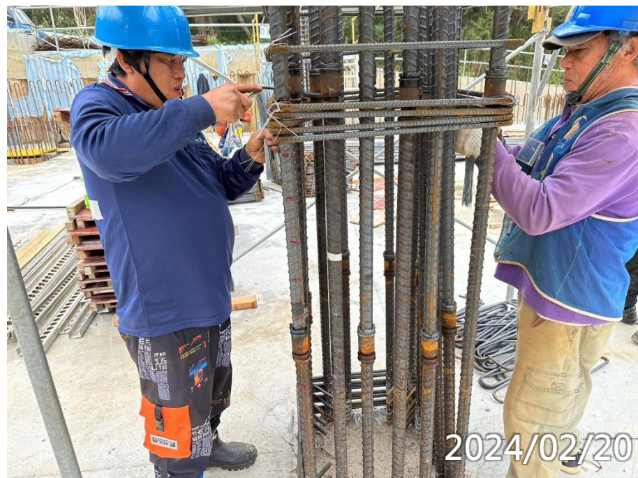
女寮2區1F柱牆鋼筋綁紮
