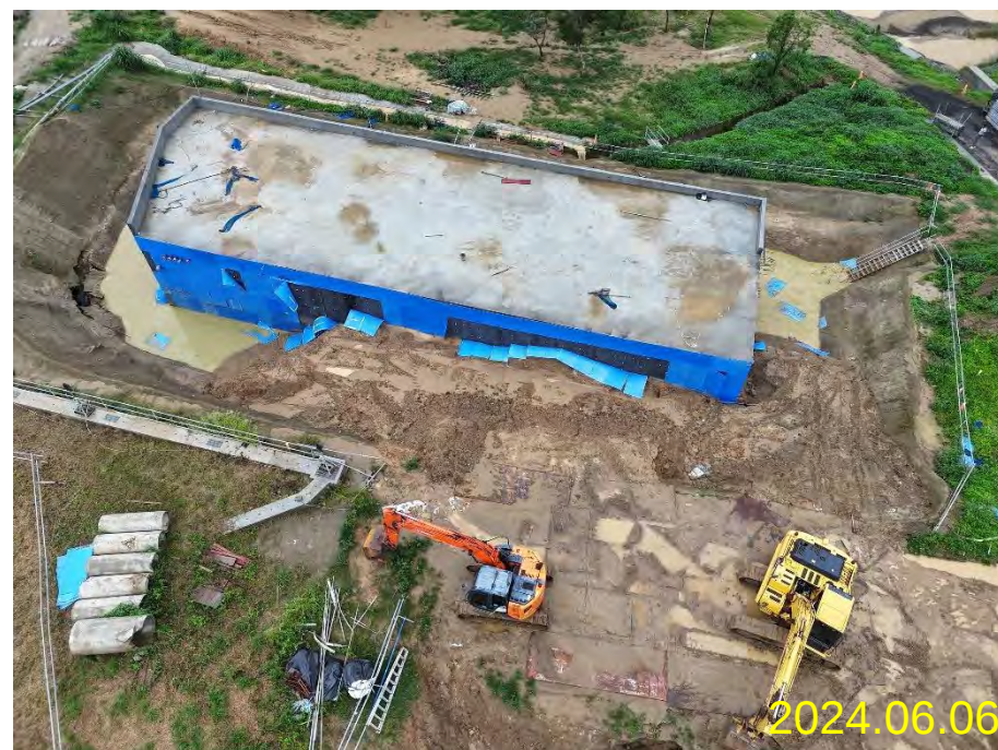
汙水處理廠土方回填
