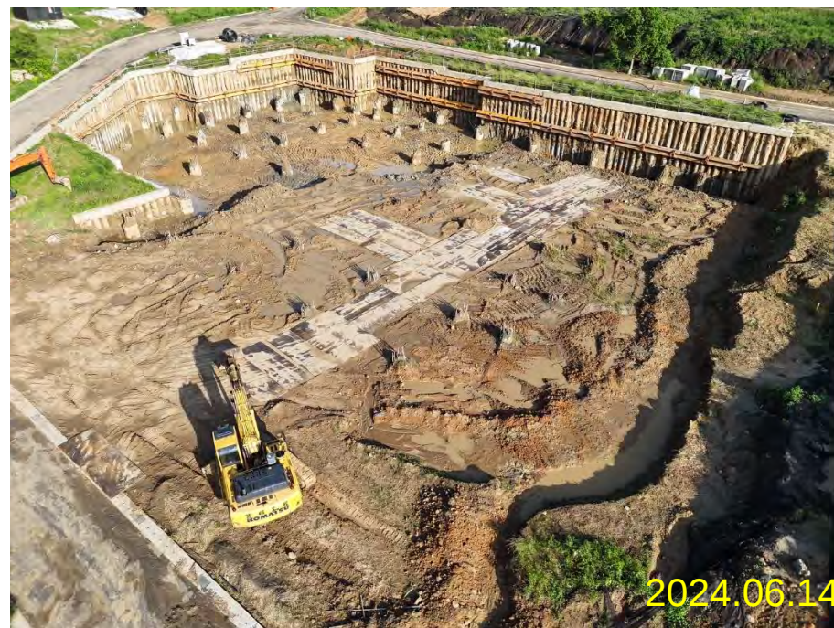
齋堂第三層土方開挖
