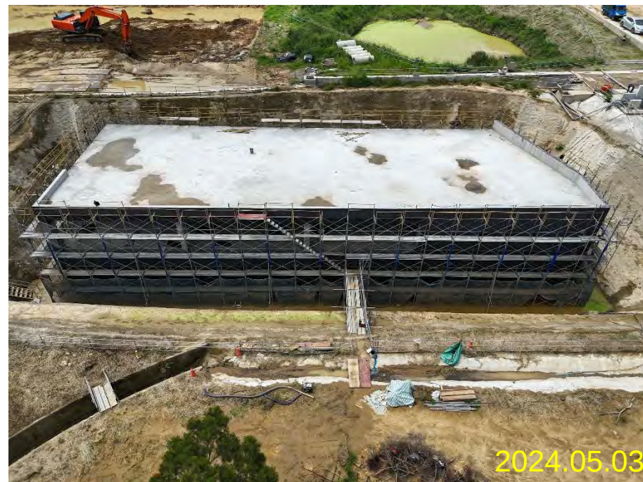
汙水處理廠外牆防水
