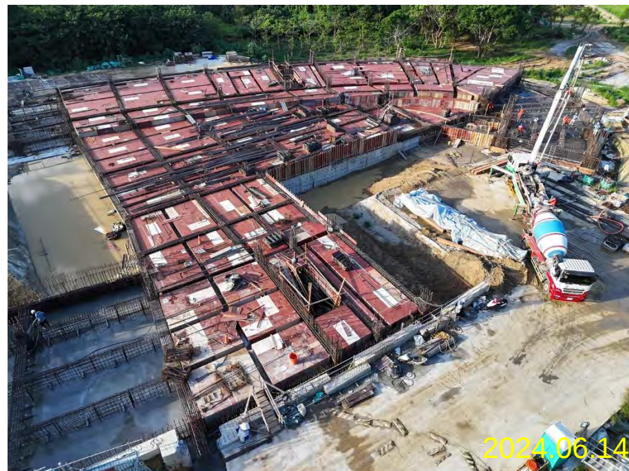
女寮1區1F梁版鋼筋、模板、水電施作 3區基礎版澆置
