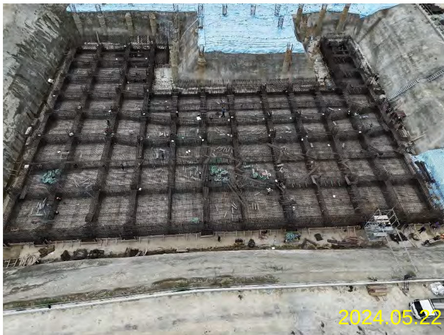
主殿筏基層鋼筋、模板、機電施作
