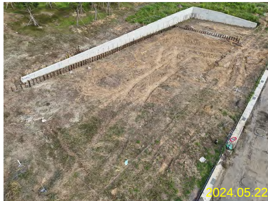
男義工鋼軌樁施作
