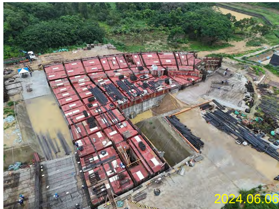
女寮1區1F梁版鋼筋、模板、水電施作
