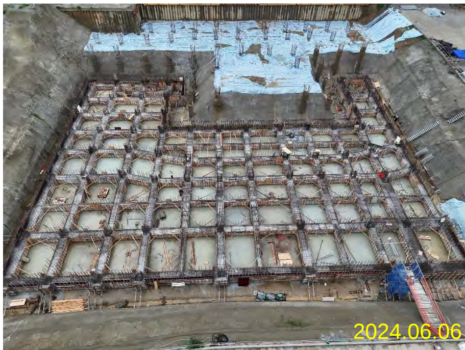
主殿基礎層鋼筋、模板、機電施作 (地梁已澆置完)
