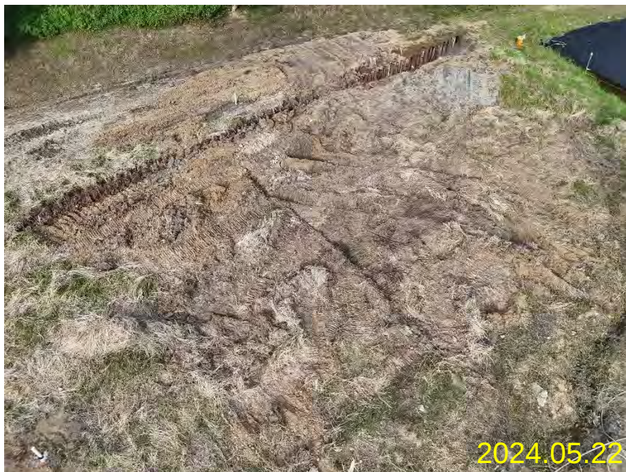
男常住鋼軌樁施作
