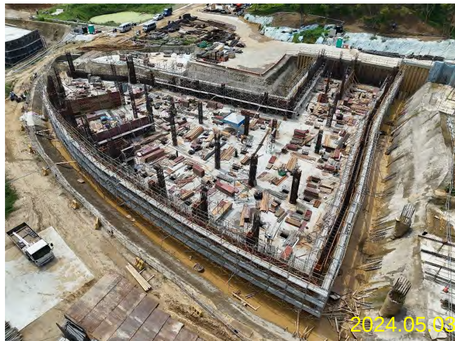
女寮1區B1F柱牆鋼筋、模板、水電施作
