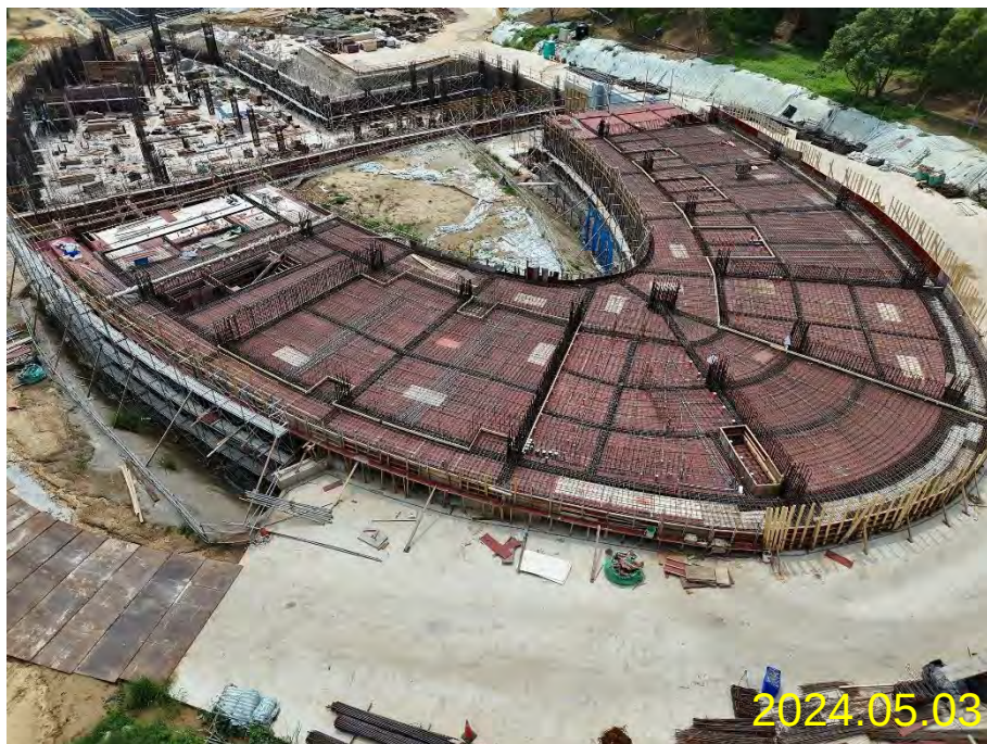
女寮2區2F梁版鋼筋、模板、水電施作
