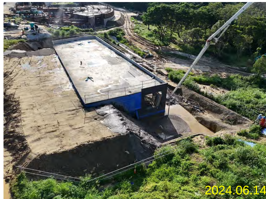
汙水處理廠土方回填 CLSM回填灌漿
