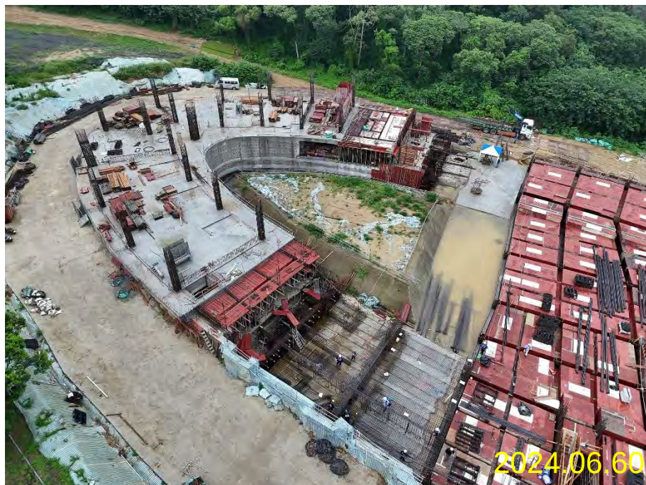
女寮2區2F柱牆鋼筋、模板、水電施作
