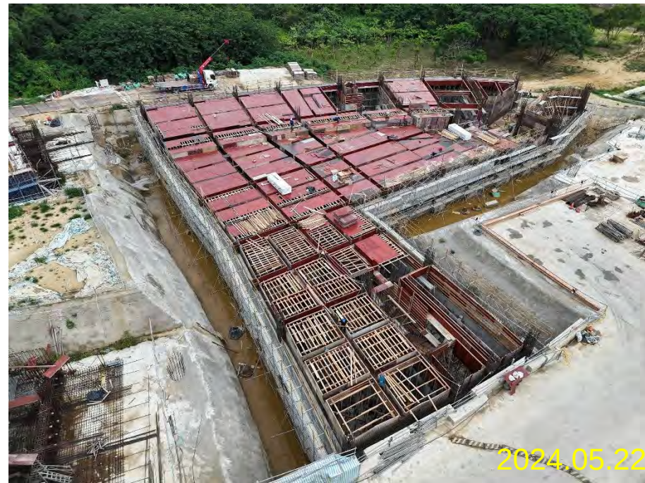
女寮1區B1F柱牆鋼筋、模板、水電施作 1F梁版模板施作
