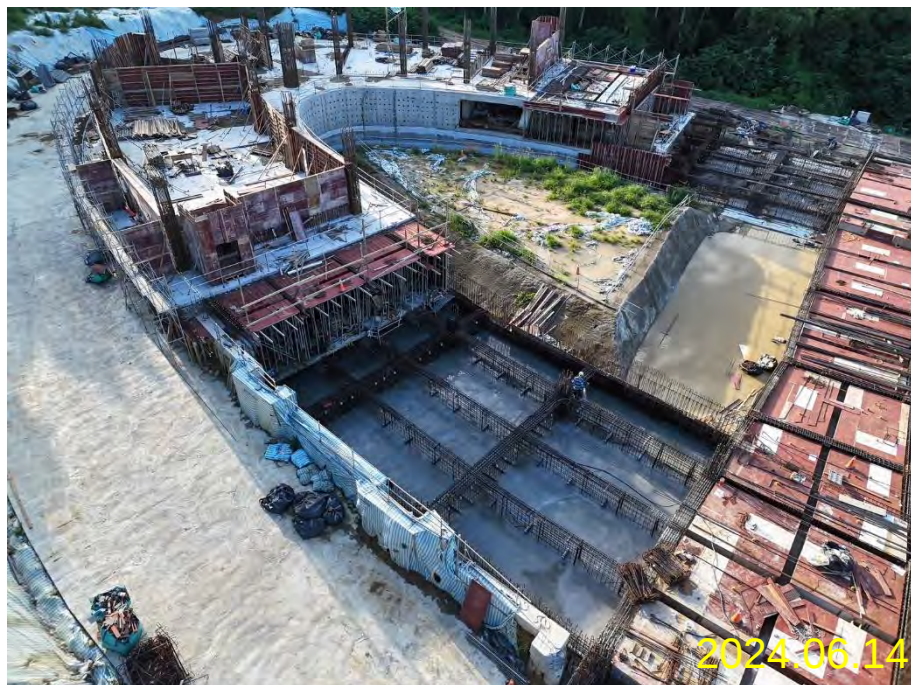
女寮2區2F柱牆鋼筋、模板、水電施作 2-2區基礎版澆置
