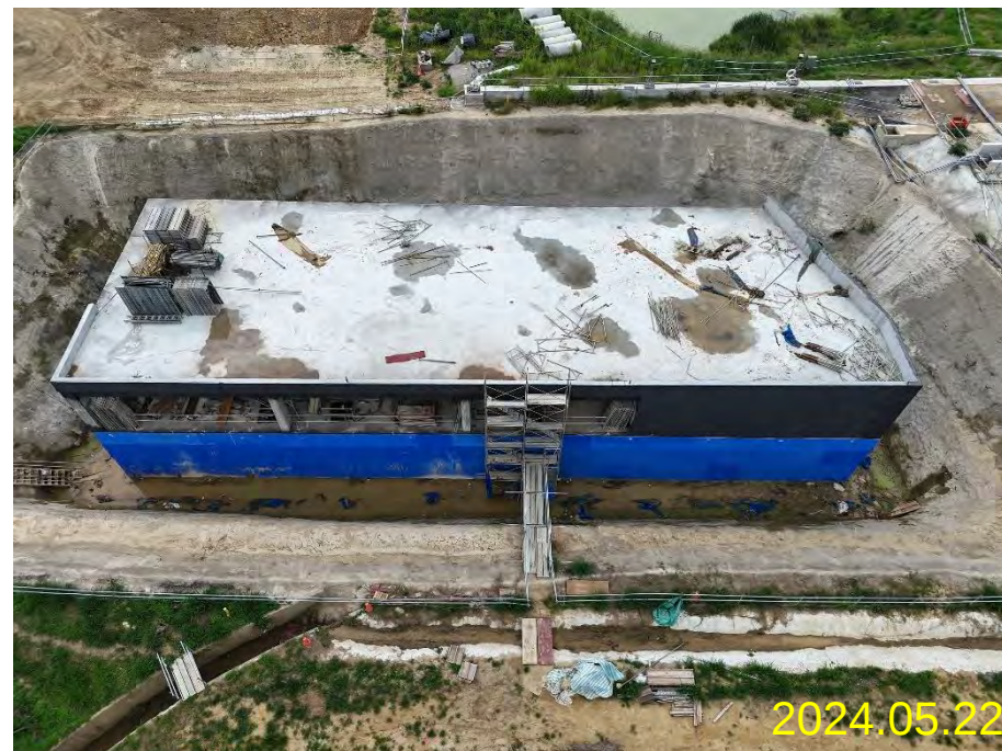
汙水處理廠外牆拆架
