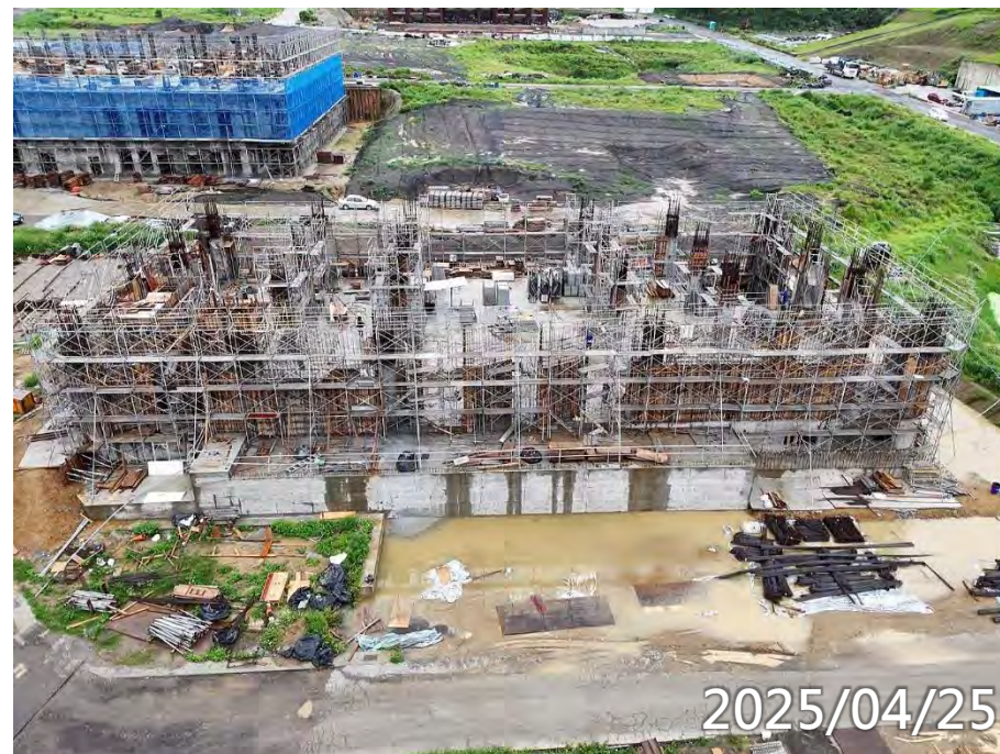
1F柱牆鋼筋模板水電施作
