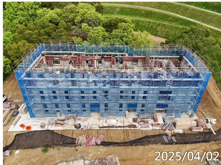
3F柱牆鋼筋模板水電施作
