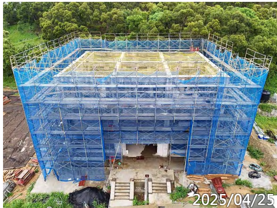
1F至RF梁底、螺桿清理 屋頂待鋼構吊裝(預計05/01)
