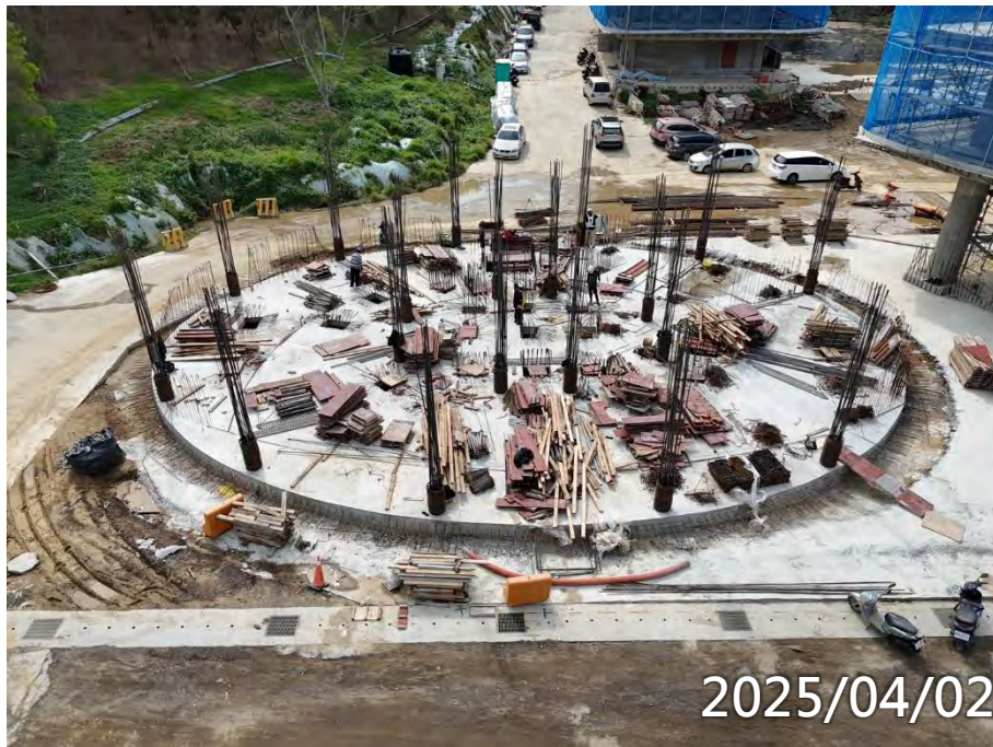
1F柱牆施作 筏基拆模
