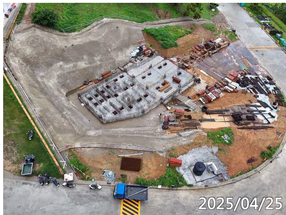
筏基層鋼筋水電施作
