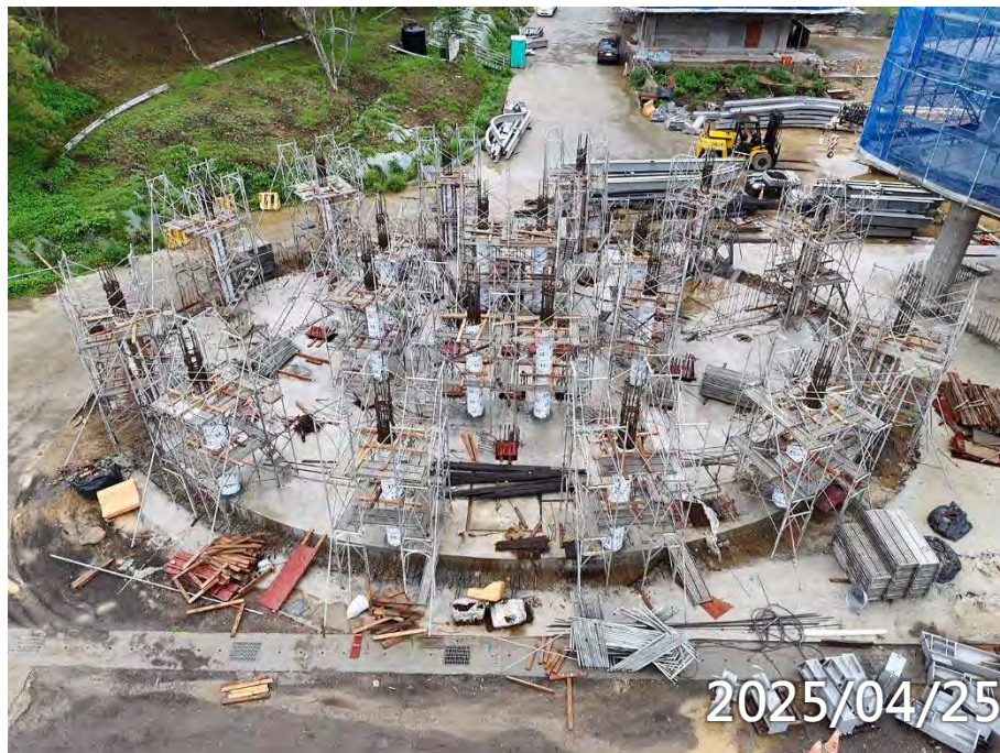
1F柱牆鋼筋模板水電施作
