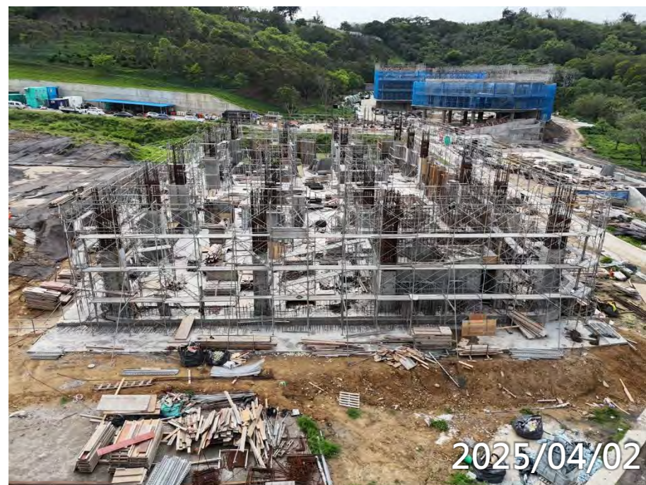
1F柱牆鋼筋模板水電施作
