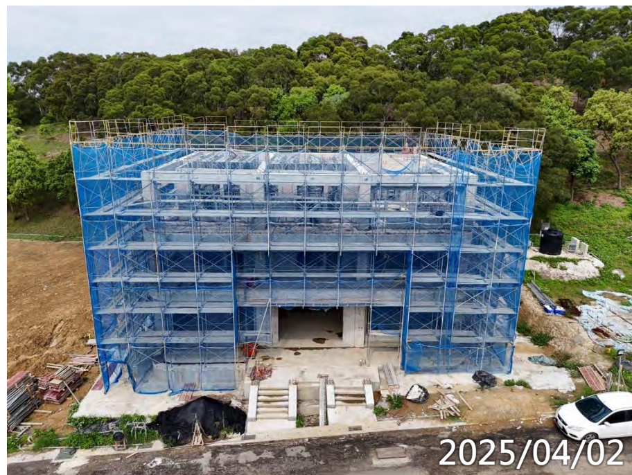
1F至RF梁底、螺桿清理 屋頂待鋼構吊裝
