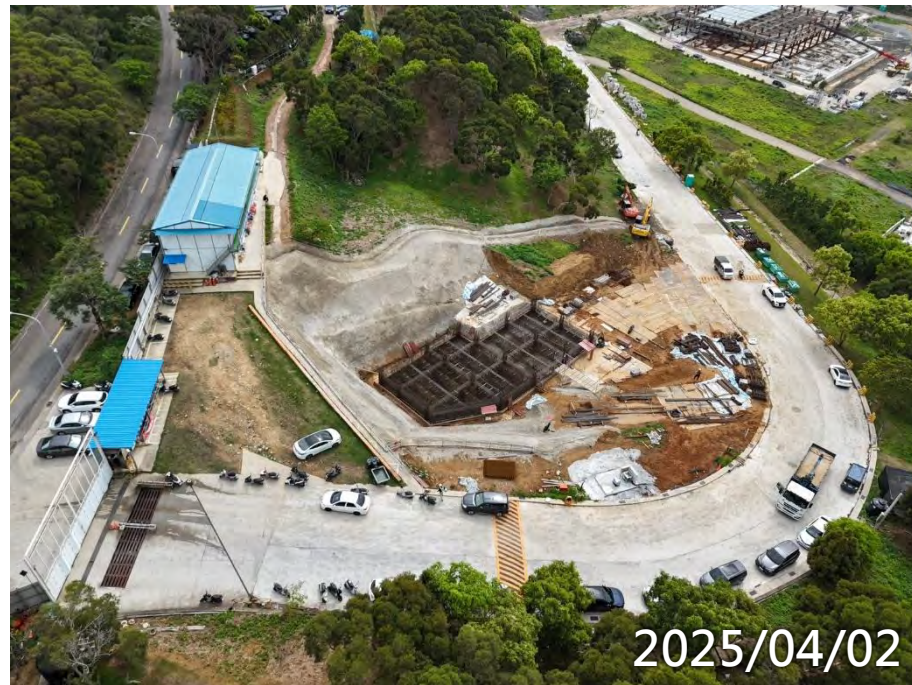
筏基層鋼筋水電施作
