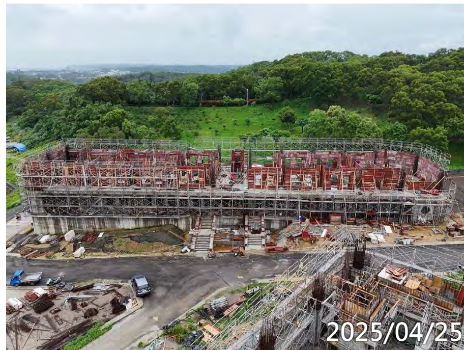
2F柱牆鋼筋模板水電施作
