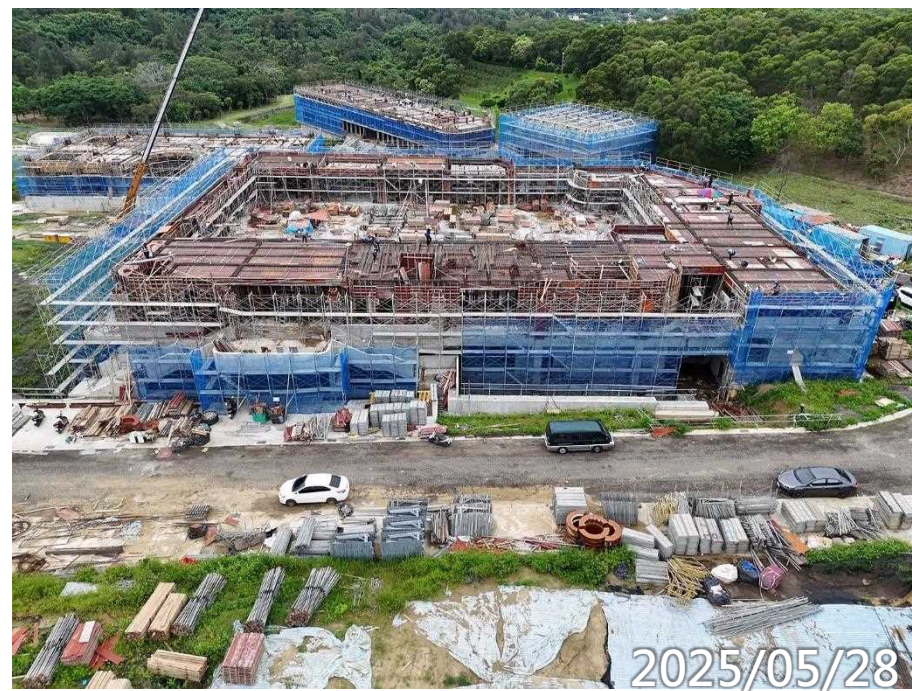
4F柱牆、閣樓梁版 鋼筋模板水電施作
