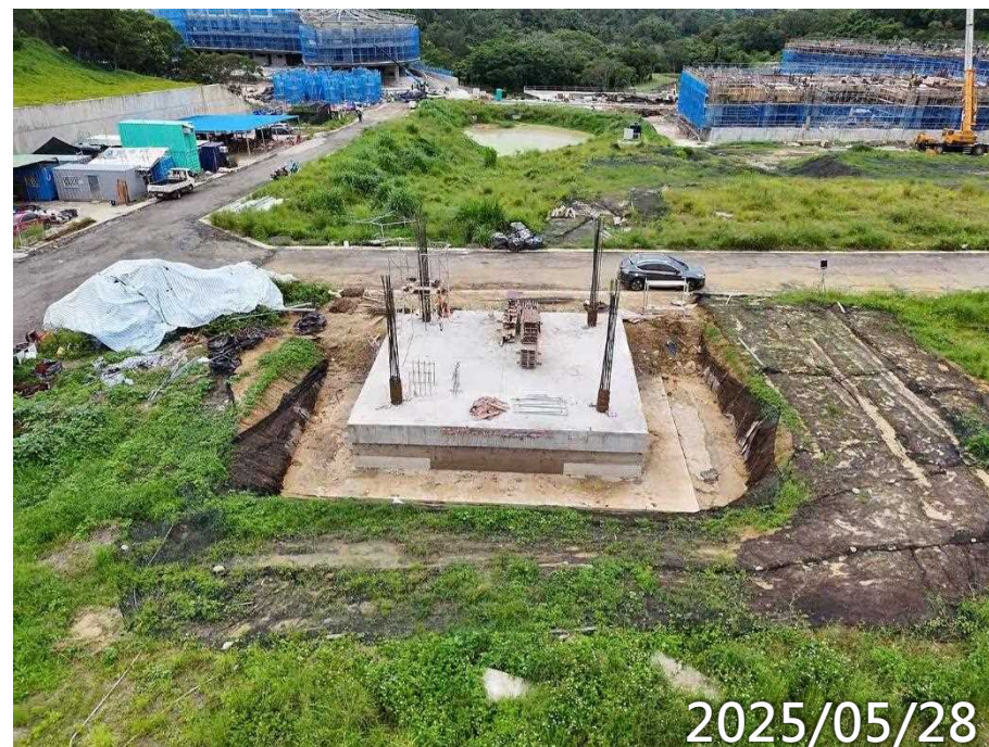
1F柱鋼筋綁紮 土方回填
