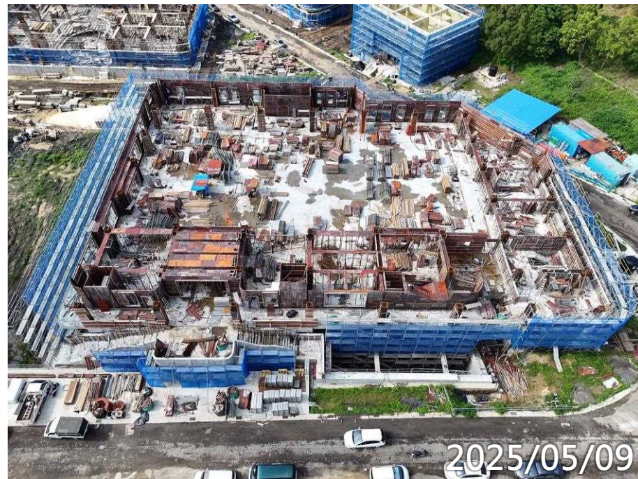
4F柱牆、4MF梁版 鋼筋模板水電施作
