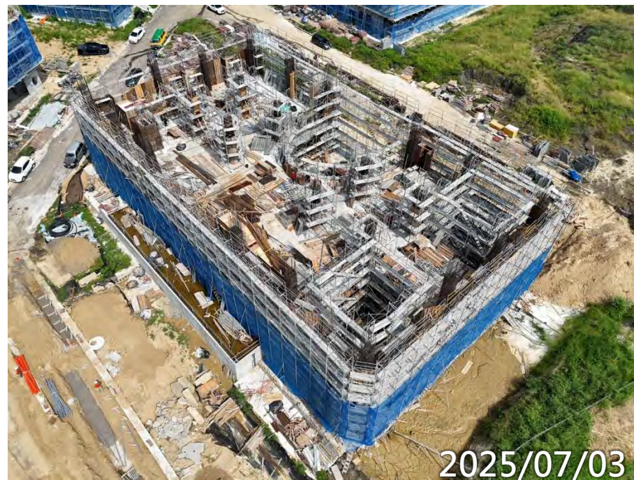
2F柱牆鋼筋模板施作
