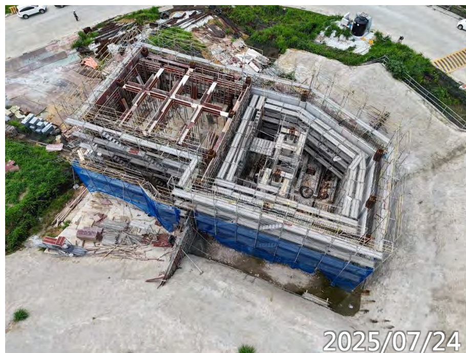
高版區3F柱牆鋼筋模板水電
