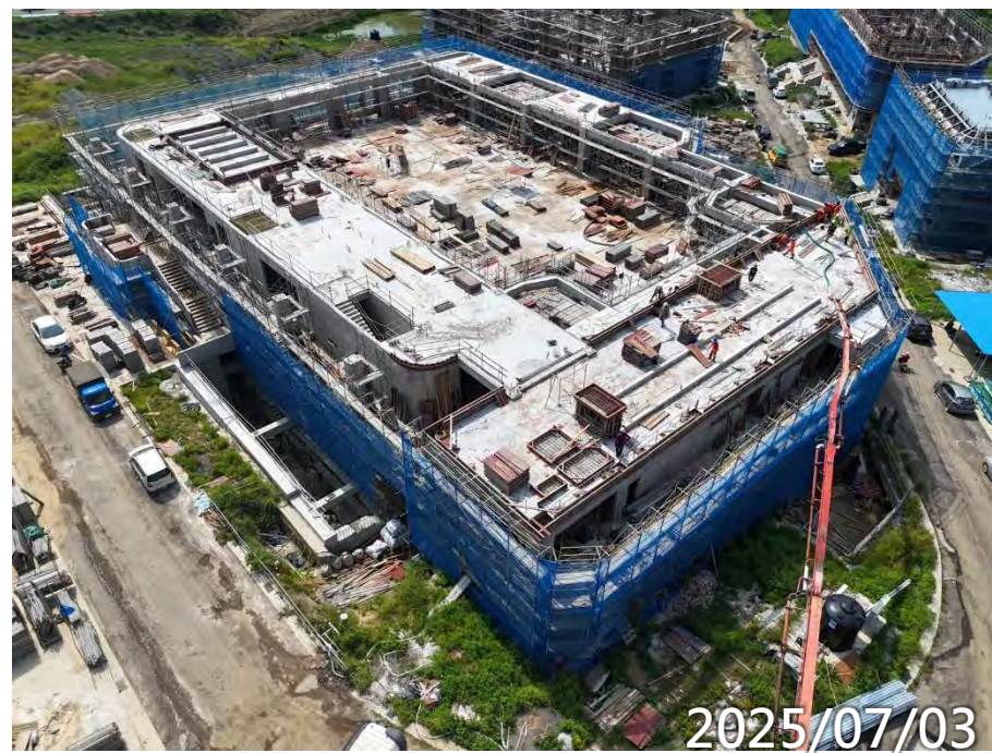
閣樓版水箱基座施作 1F油漆平頂批土 1F輕隔間放樣
