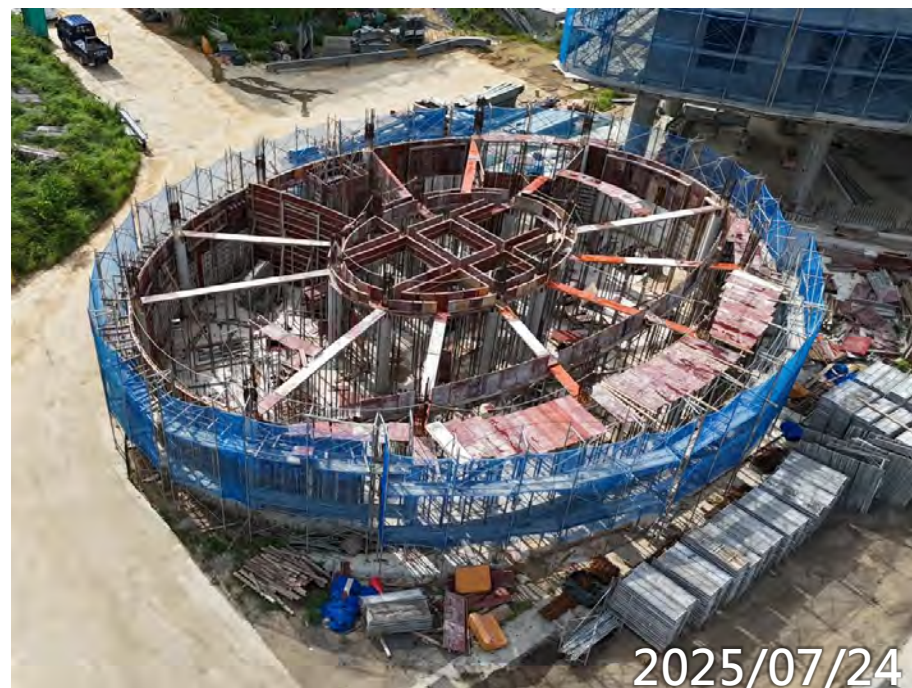
2F梁版模板施作
