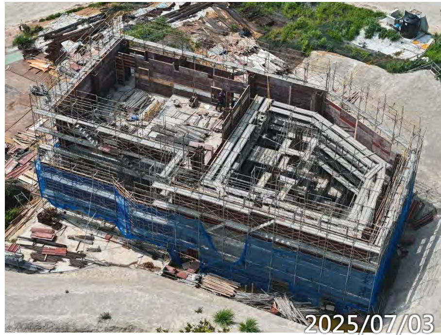
高版區3F柱牆鋼筋模板水電
