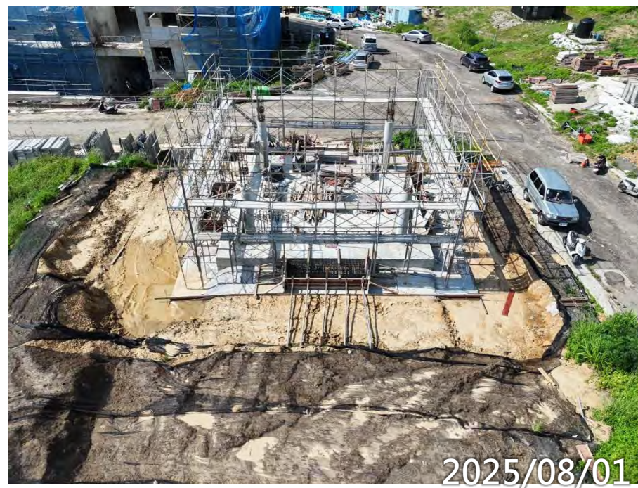
1F樓梯鋼筋模板施作
