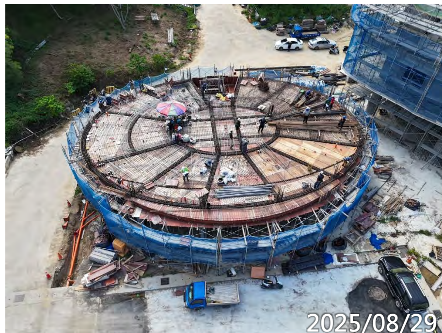
2F梁版鋼筋模板水電施作
