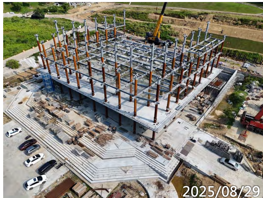
鋼構3F桁架吊裝
