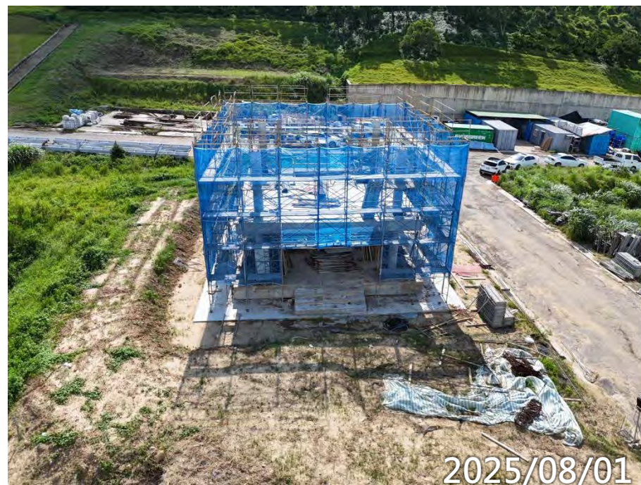
鋼構屋頂待吊裝
