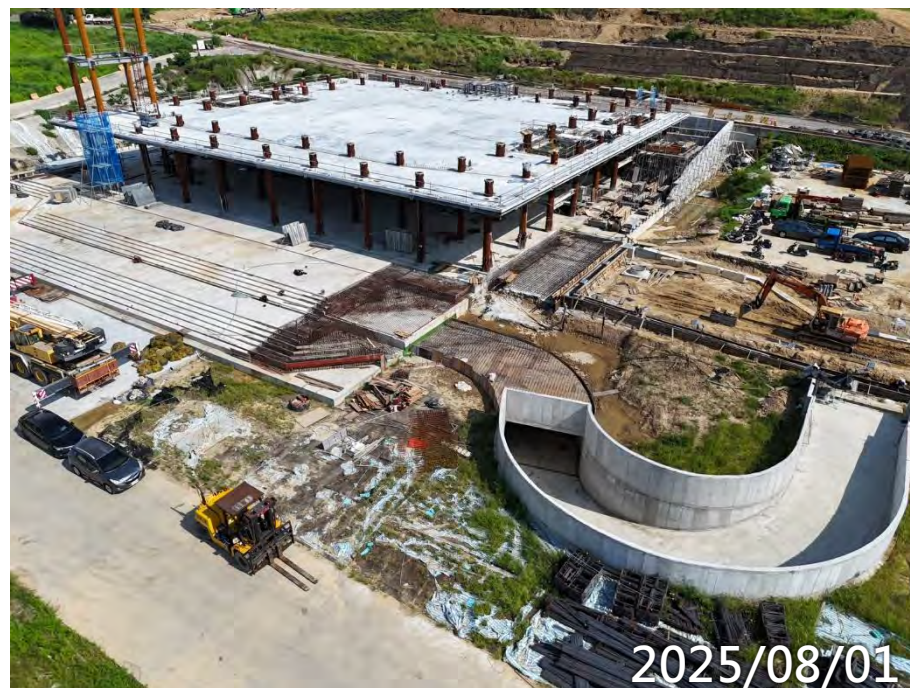
鋼構第二節柱吊裝 車道頂版聚脲防水施作
