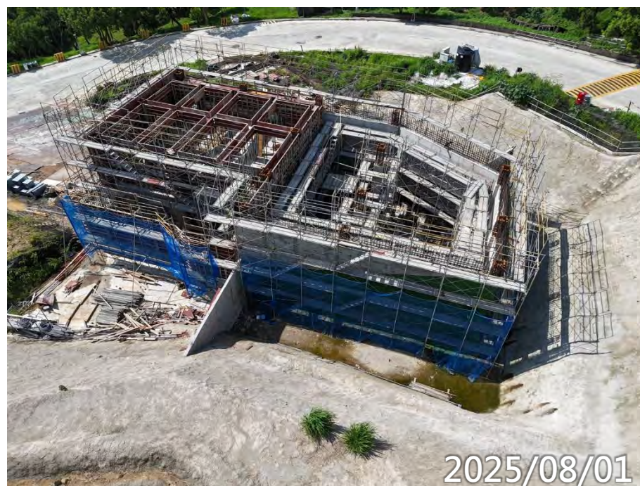
高版區3F柱牆鋼筋模板水電 外牆聚脲防水施作
