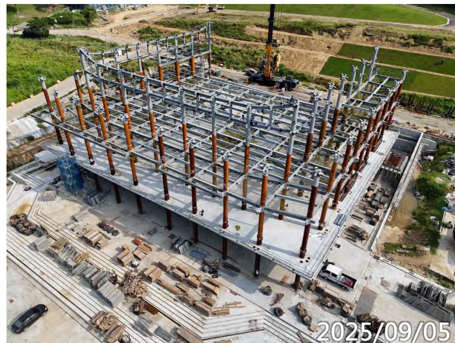
鋼構3F梁吊裝
