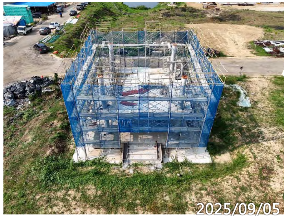
鋼構屋頂待吊裝
