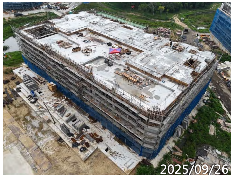
3F梁版澆置 B1F泥作打底
