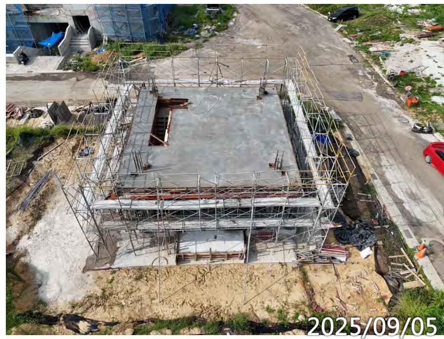
2F梁版澆置
