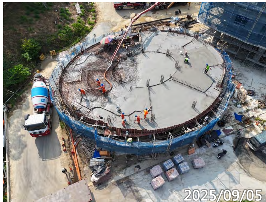
2F梁版澆置
