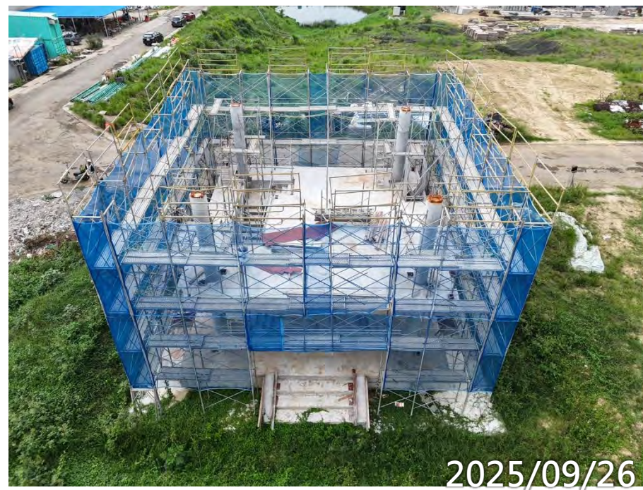
鋼構屋頂待吊裝
