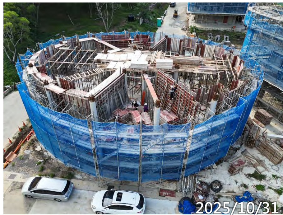
RF梁鋼筋模板水電施作
