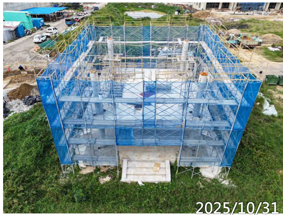
鋼構屋頂待吊裝
