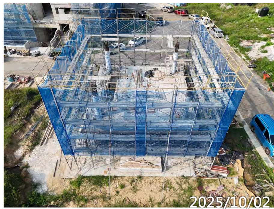
2F柱澆置 屋頂鋼構預埋
