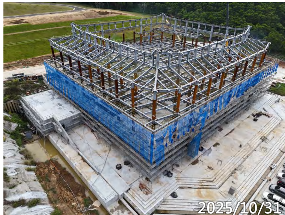
鋼構3F梁柱、下層屋簷校正電銲 B2F-B1F泥作吊線
