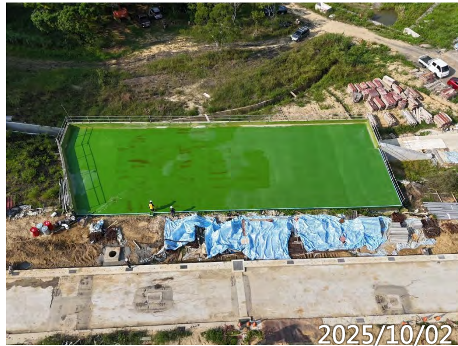
屋頂聚脲防水試水
