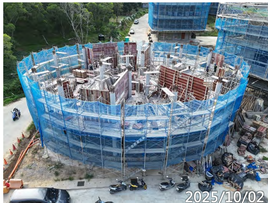
2F牆鋼筋模板水電施作
