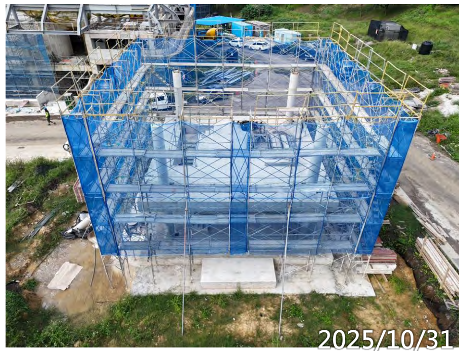
鋼構屋頂待吊裝
