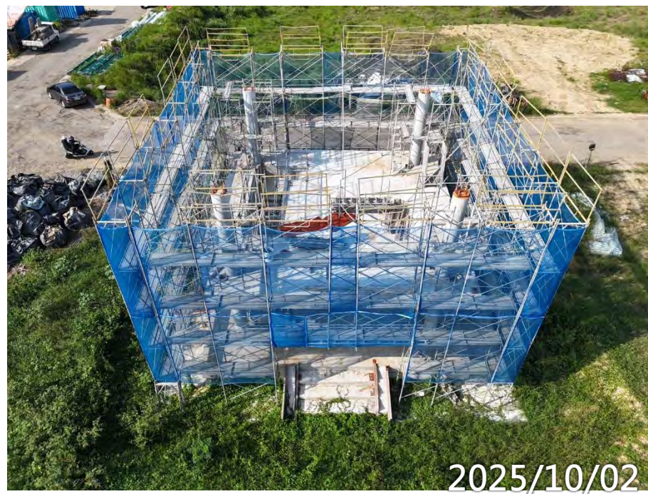
鋼構屋頂待吊裝
