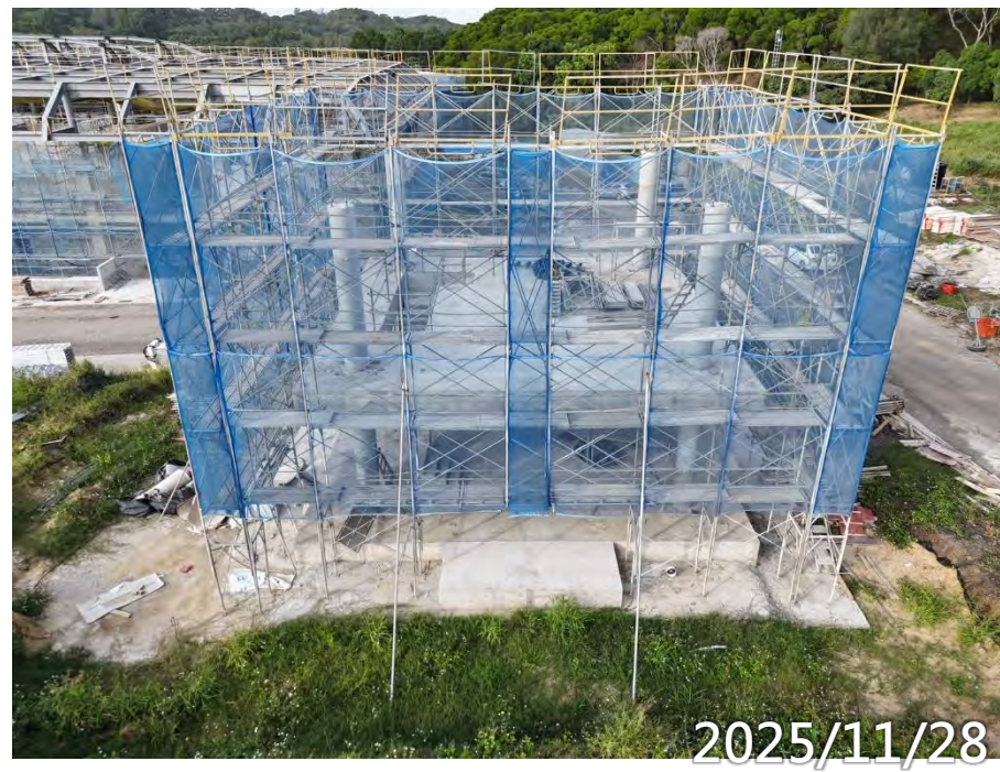
鋼構屋頂待吊裝
