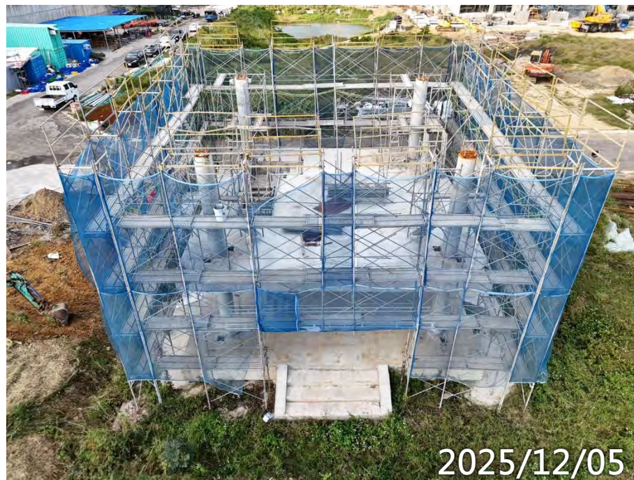
鋼構屋頂待吊裝
