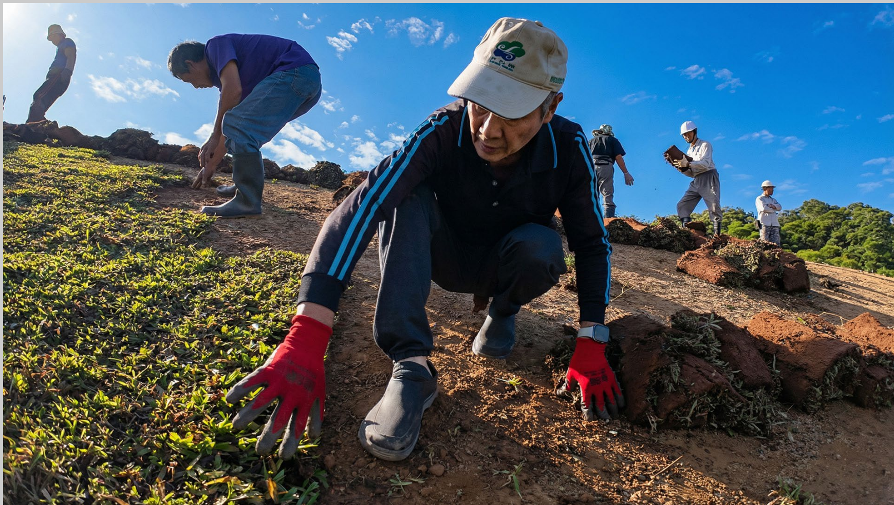
大殿正後方山坡，由人工整平、夯實、鋪排種植草皮 | 2025年11月
