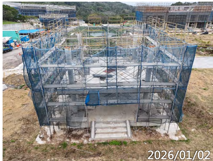
鋼構屋頂待吊裝
