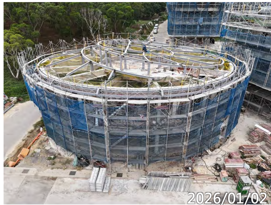
屋頂鋼構電鍍校正
