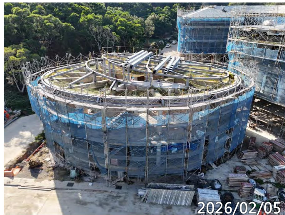
金屬屋頂防火層施作
