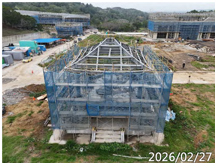
鋼構屋頂電銲校正
