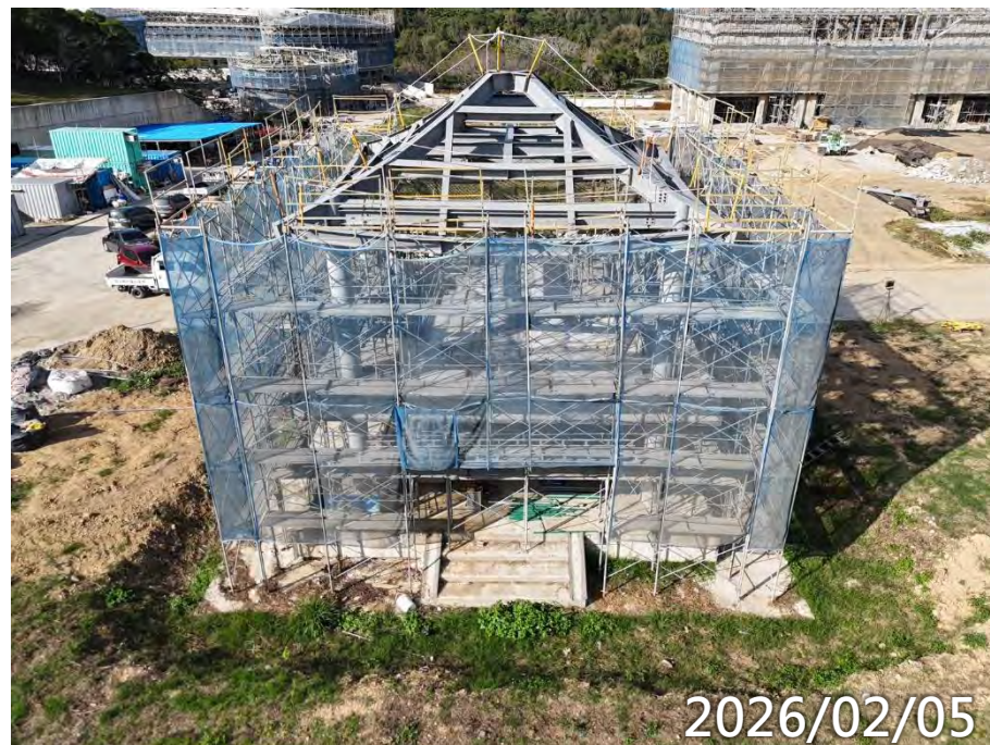
鋼構屋頂吊裝
