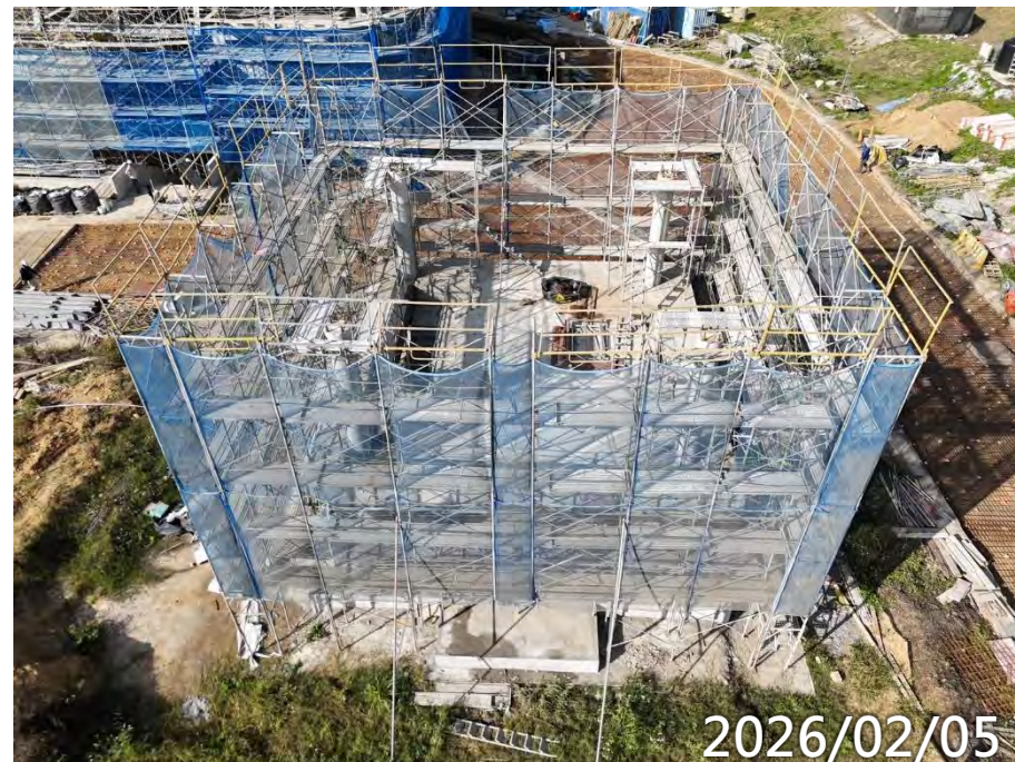
鋼構屋頂待吊裝
