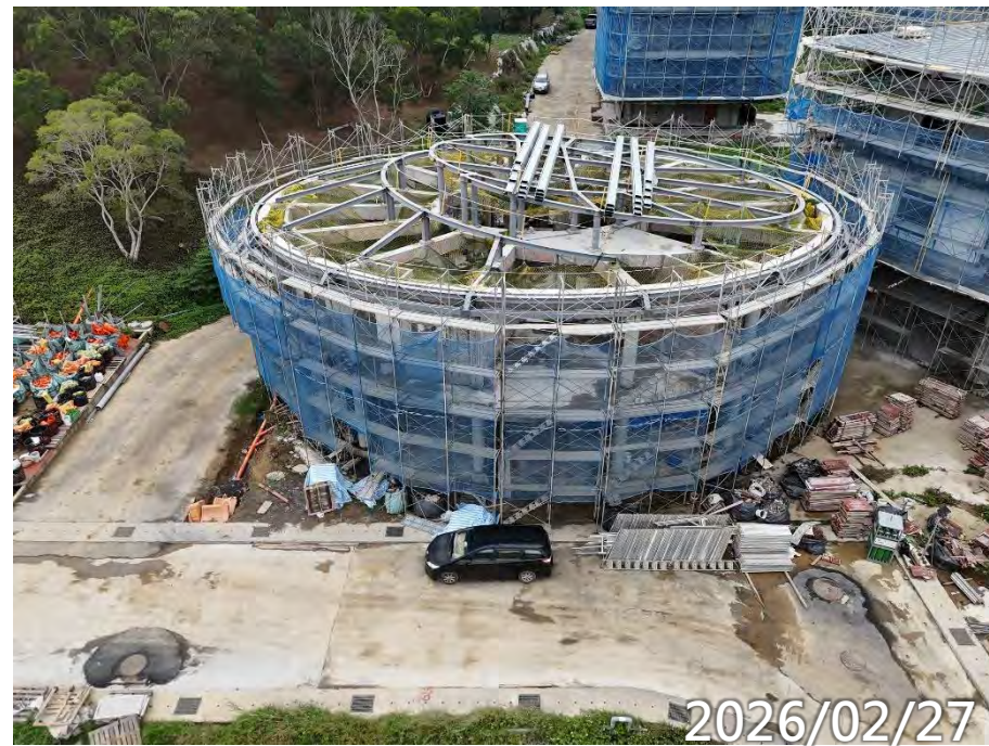
金屬屋頂防火層施作
