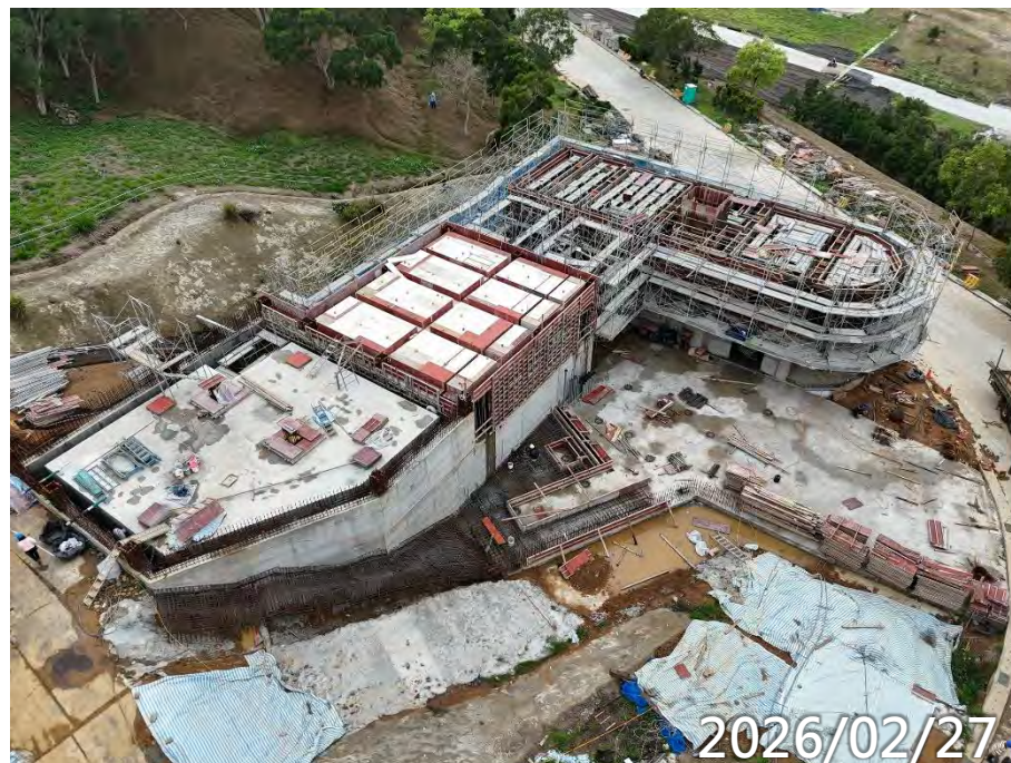
高版區水箱鋼筋模板水電 低版區RF梁鋼筋模板水電 戶外廣場鋪面、樓梯施作
