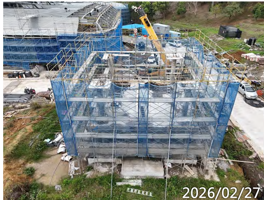
鋼構屋頂待吊裝
