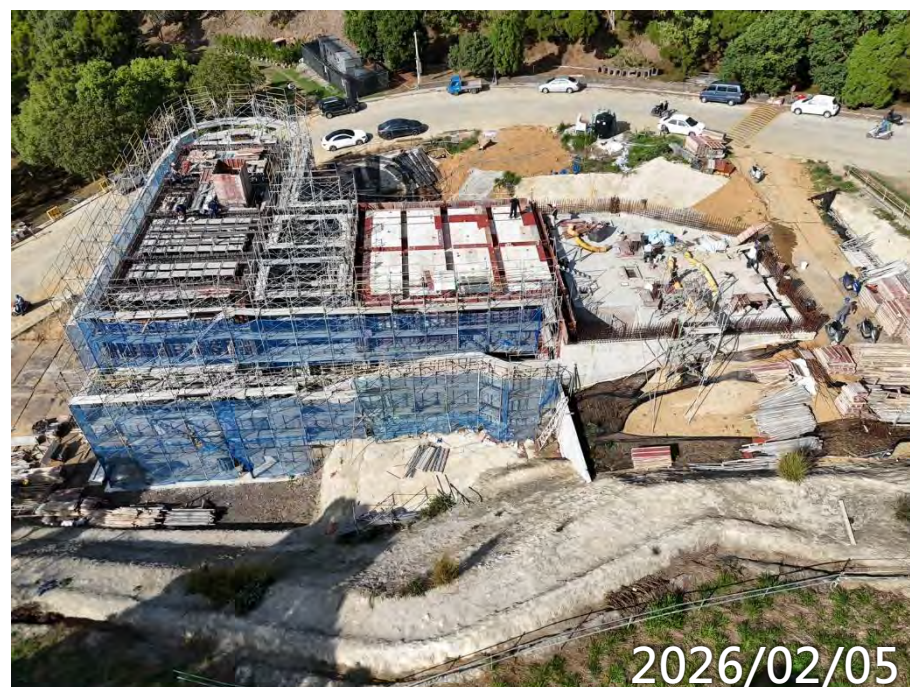
高版區水箱鋼筋模板水電 低版區3F柱牆鋼筋模板水電 戶外廣場獨立基腳柱施作
