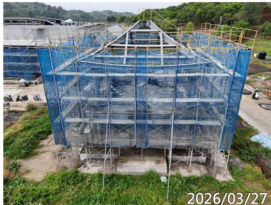
鋼構屋頂電銲校正 1F泥作
