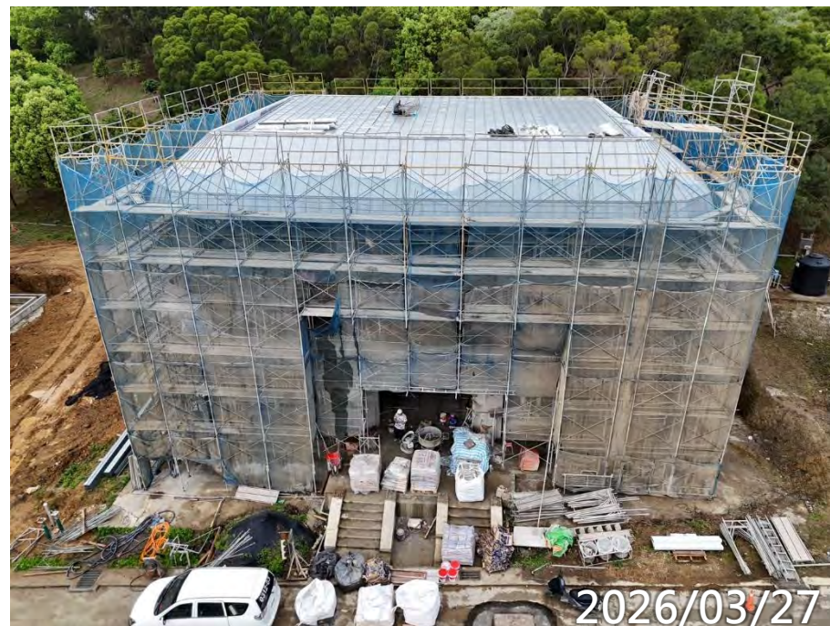
金屬屋頂面層施作
