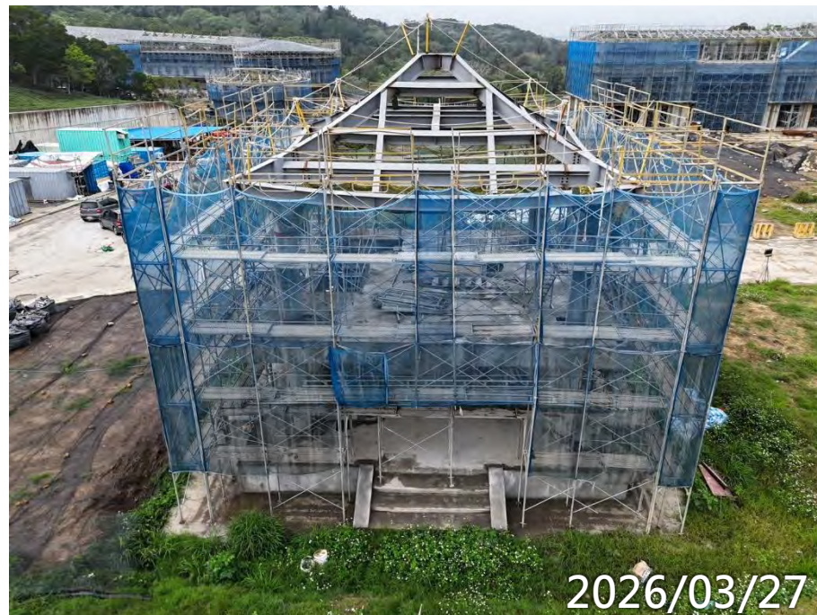
鋼構屋頂電銲校正 1F泥作
