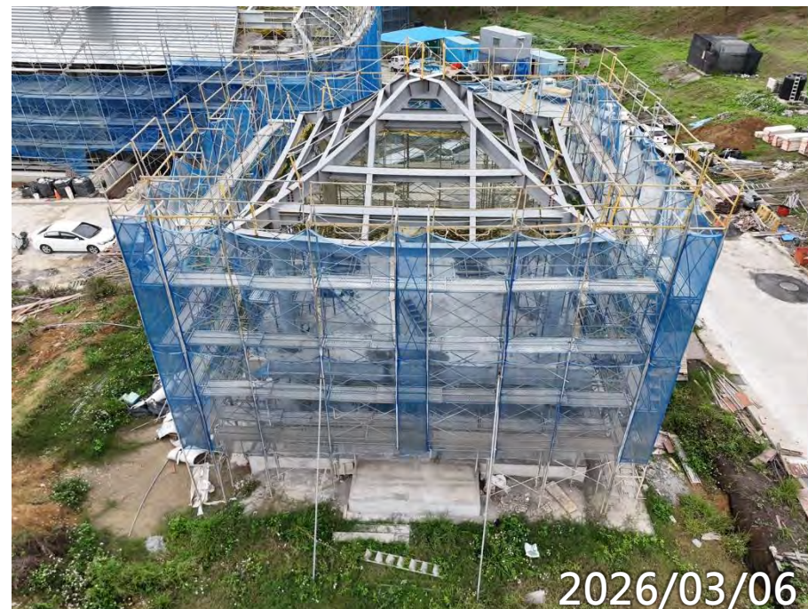
鋼構屋頂電銲校正
