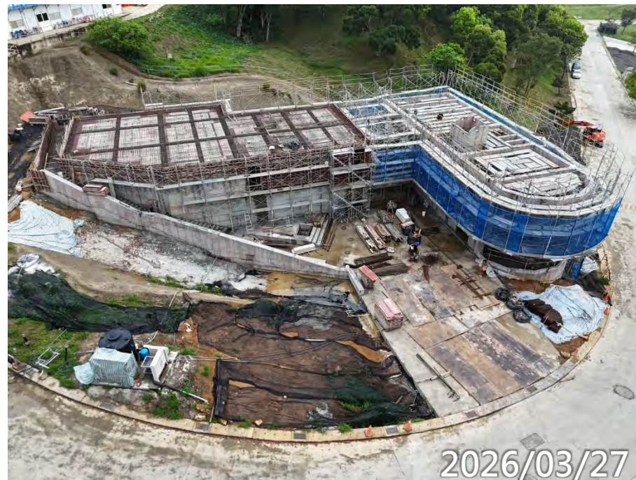
高版區頂版鋼筋模板水電 戶外景觀樓梯施作
