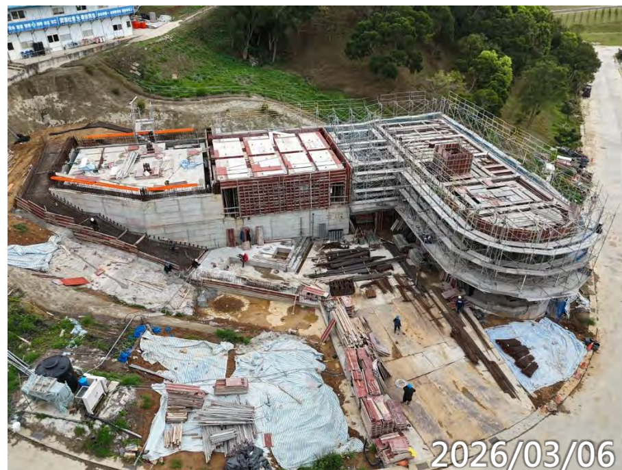
高版區水箱鋼筋模板水電 低版區RF梁澆置 戶外廣場鋪面、樓梯施作
