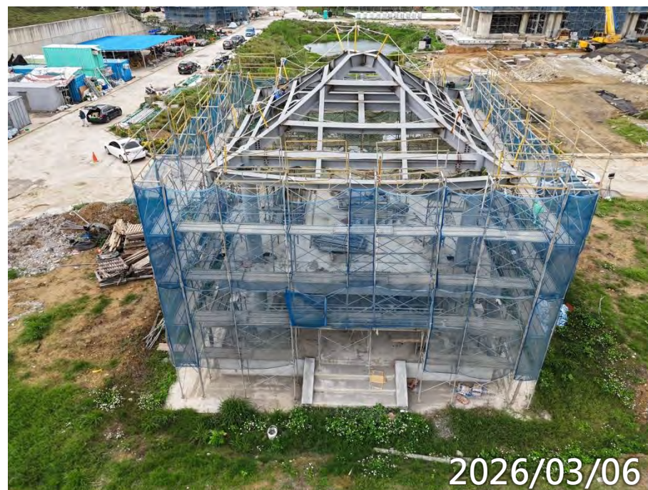
鋼構屋頂電銲校正
