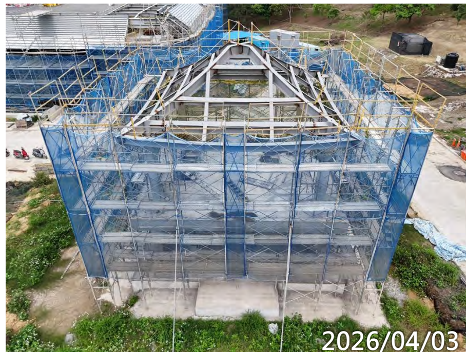
鋼構屋頂電銲校正 1F泥作
