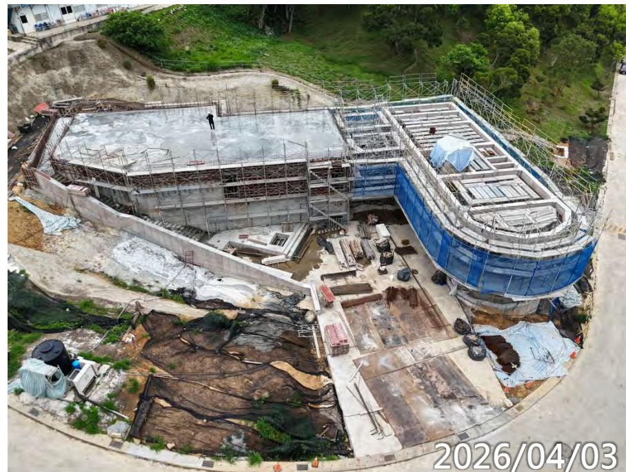
高版區頂版澆置 戶外景觀樓梯澆置
