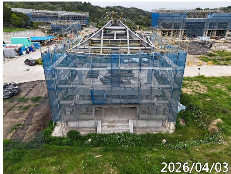
鋼構屋頂電銲校正 1F泥作
