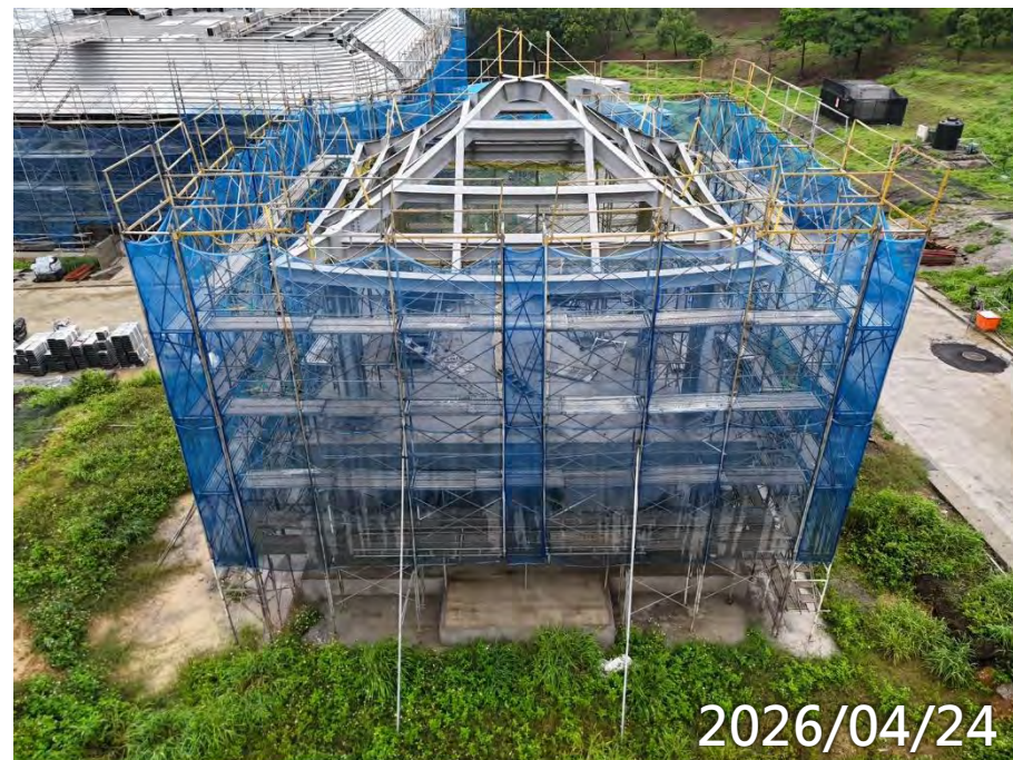
鋼構屋頂電銲校正 1F泥作
