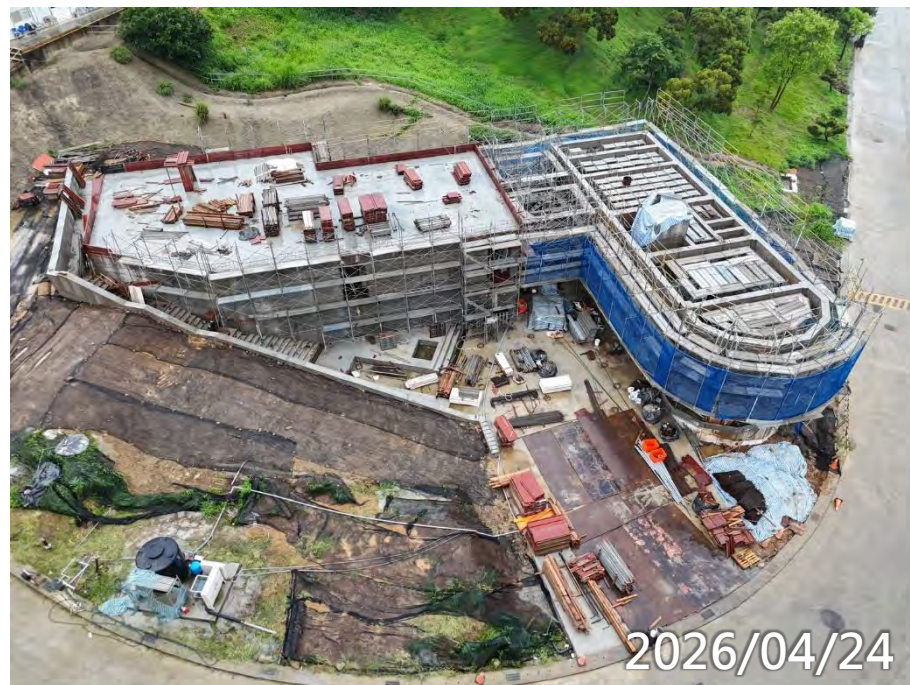
1F-2F泥作、戶外欄杆預埋施作
