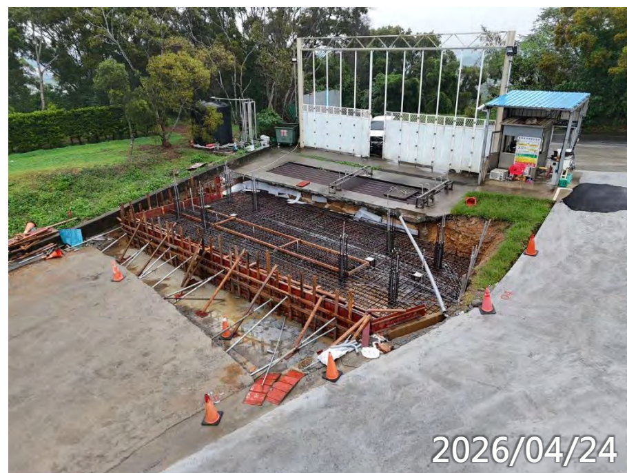
基礎版鋼筋綁紮
