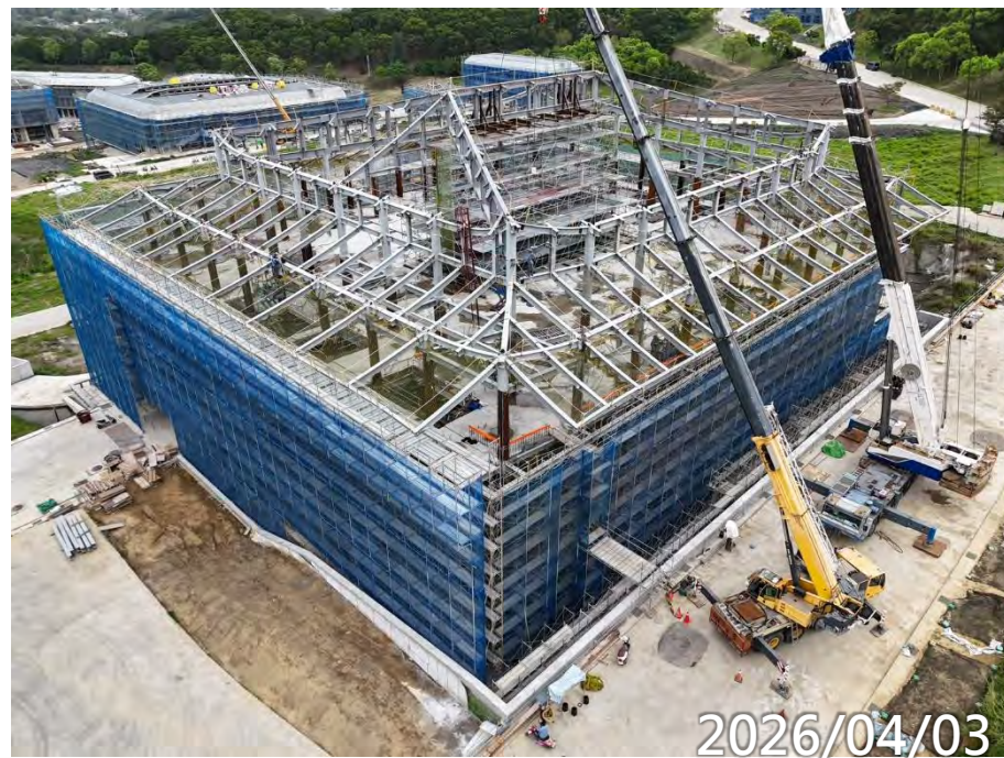
鋼構屋頂吊裝
