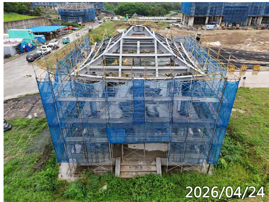
鋼構屋頂電銲校正 1F泥作
