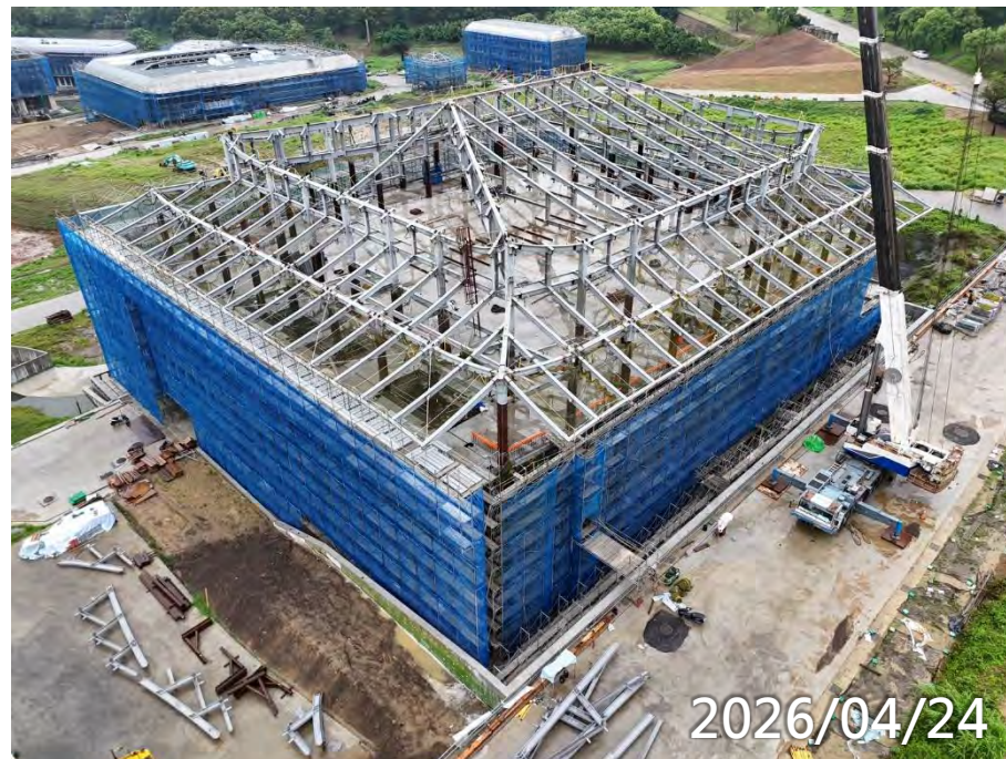
鋼構屋頂吊裝
