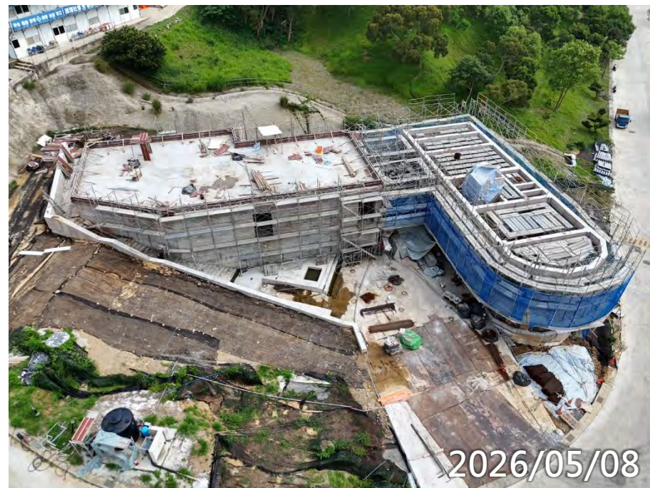
1F-2F泥作、戶外欄杆預埋施作
