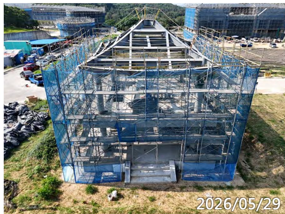
鋼構屋頂電銲校正 1F泥作
