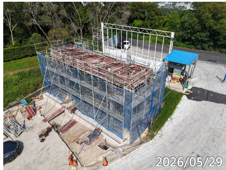
屋頂鋼構預埋
