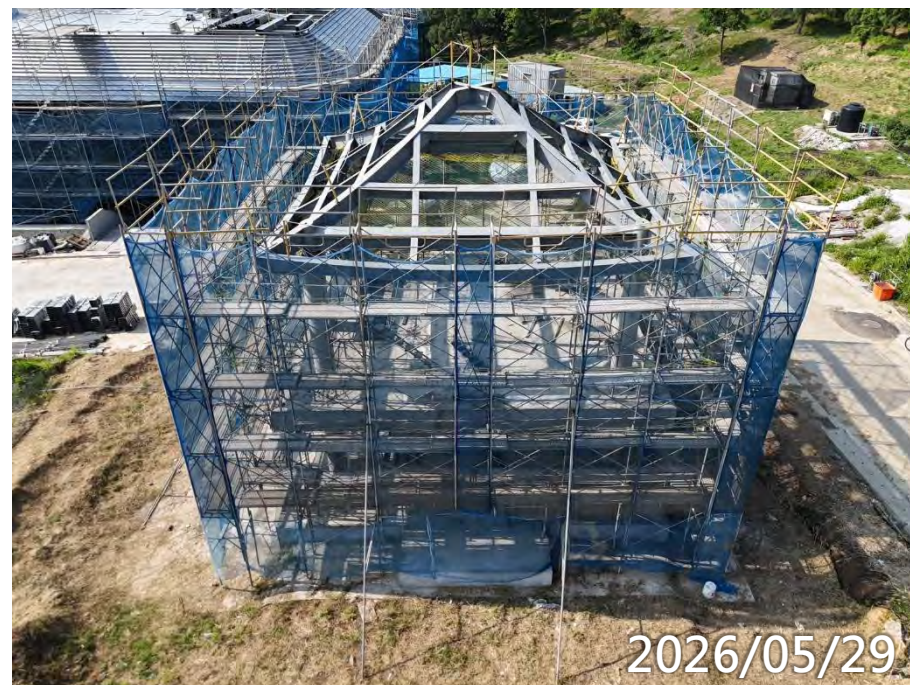
鋼構屋頂電銲校正 1F泥作
