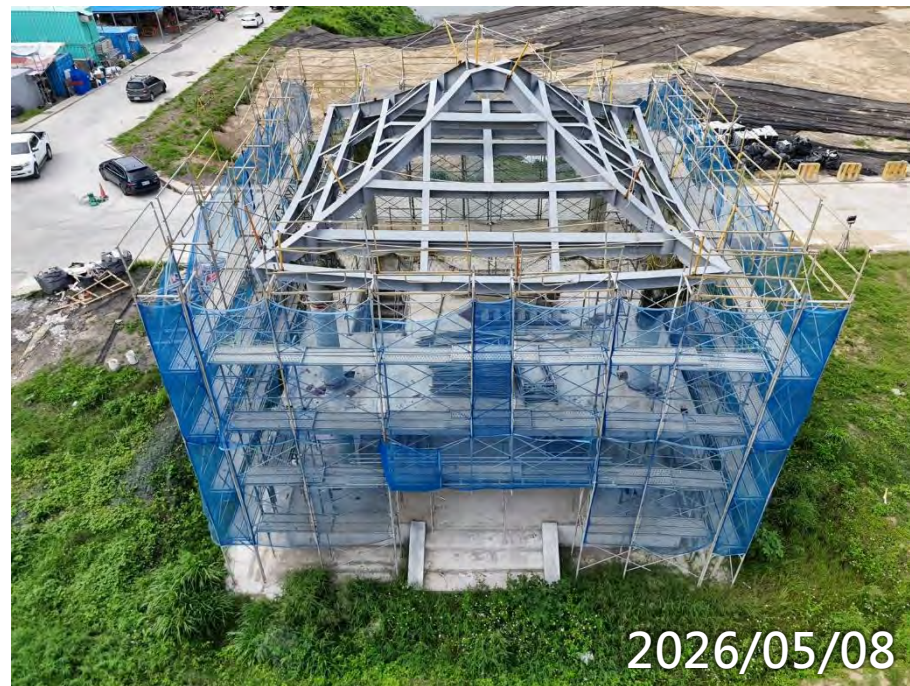
鋼構屋頂電銲校正 1F泥作
