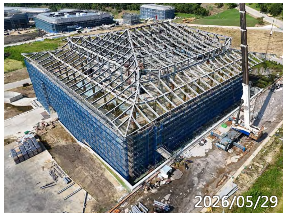
鋼構屋頂吊裝
