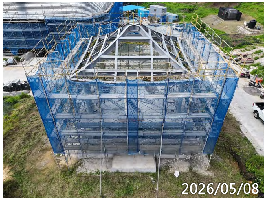
鋼構屋頂電銲校正 1F泥作
