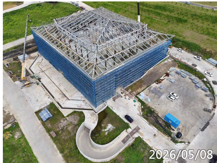
鋼構屋頂吊裝
