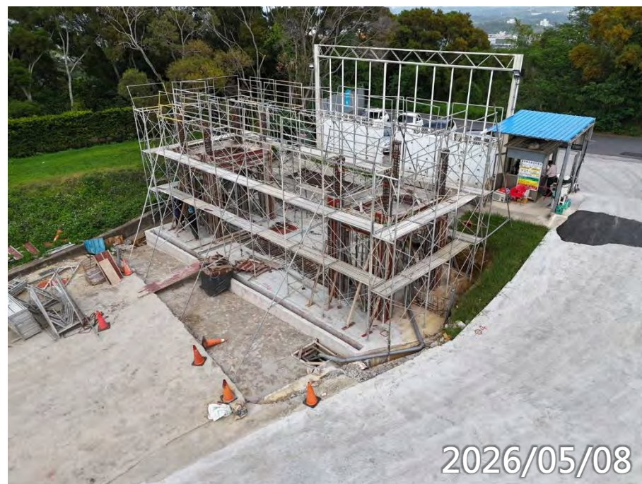
柱鋼筋模板水電施作
