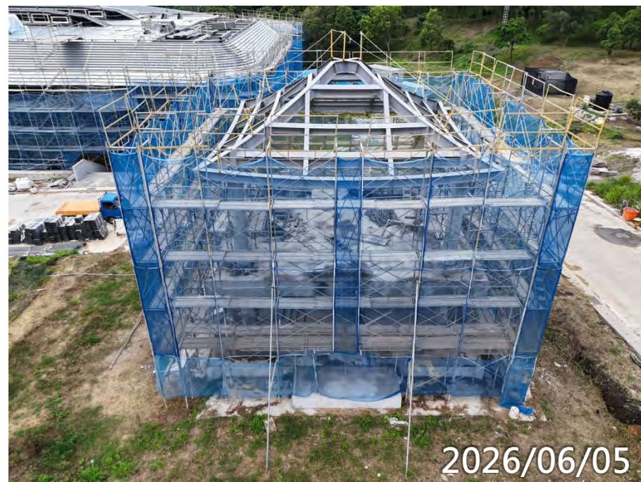
待金屬屋頂施作 1F泥作
