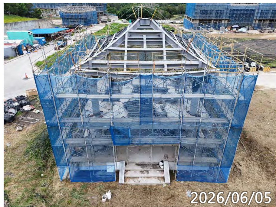
待金屬屋頂施作 1F泥作
