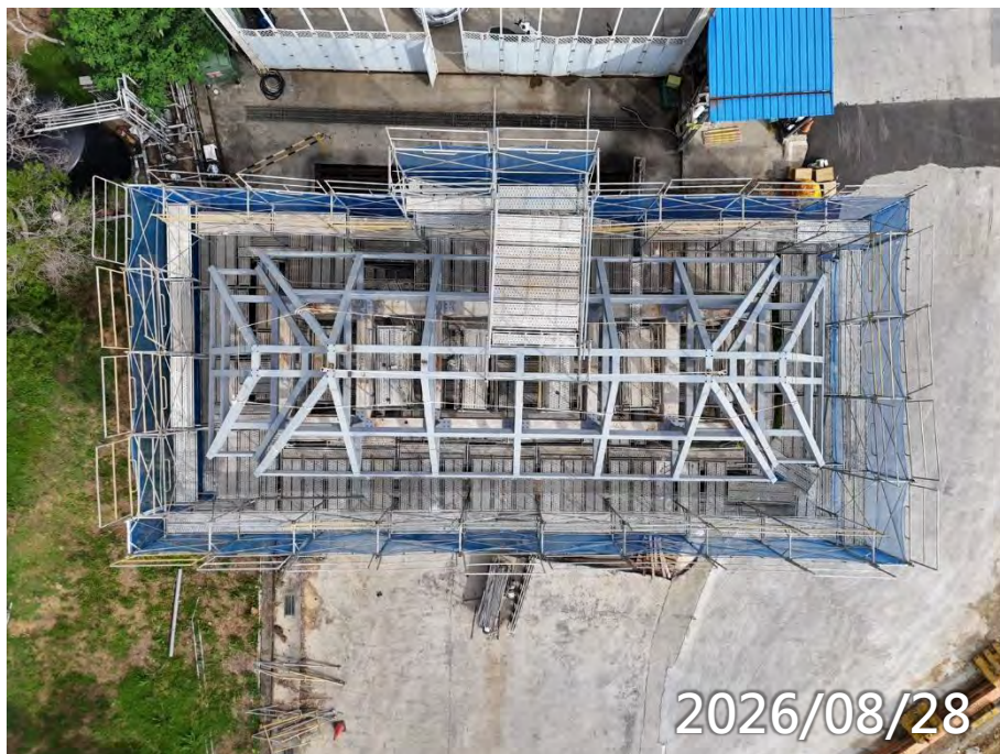
山門 屋頂鋼構吊裝、電焊(100%)
