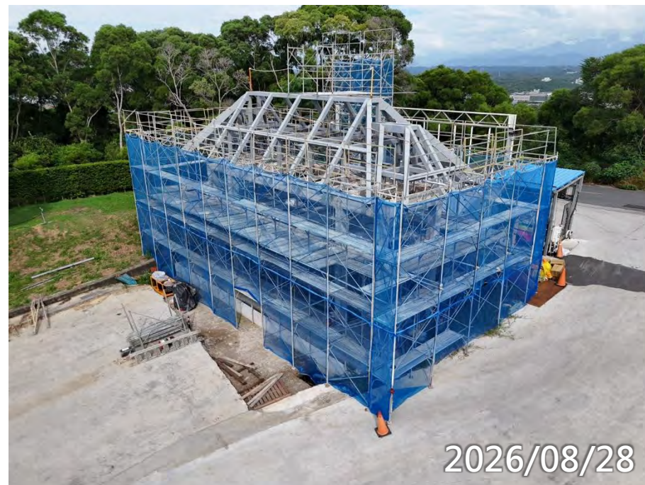
山門 屋頂鋼構吊裝、電焊(100%)
