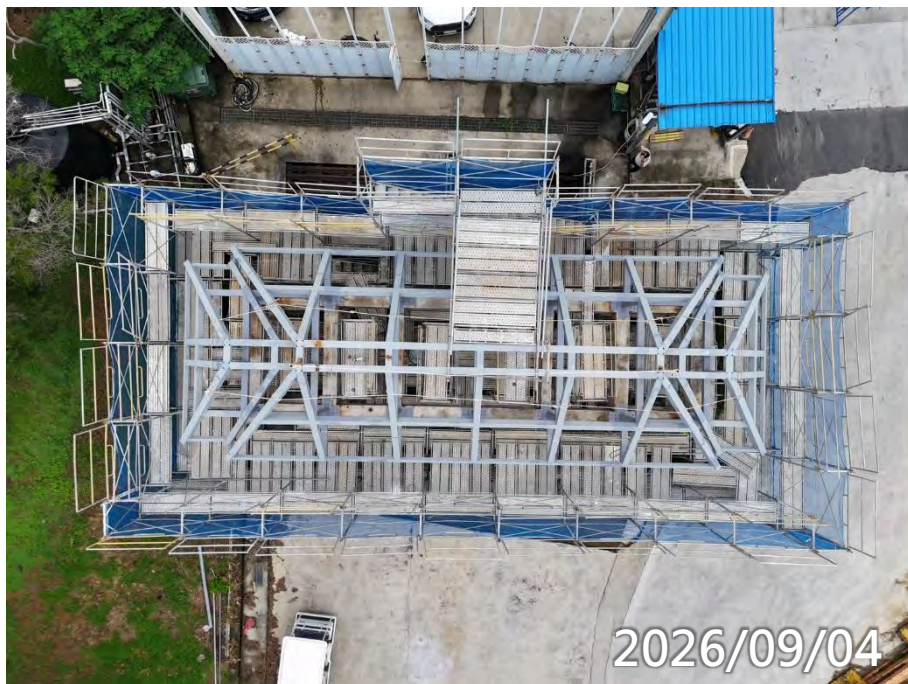
山門 屋頂鋼構除鏽補漆(70%)
