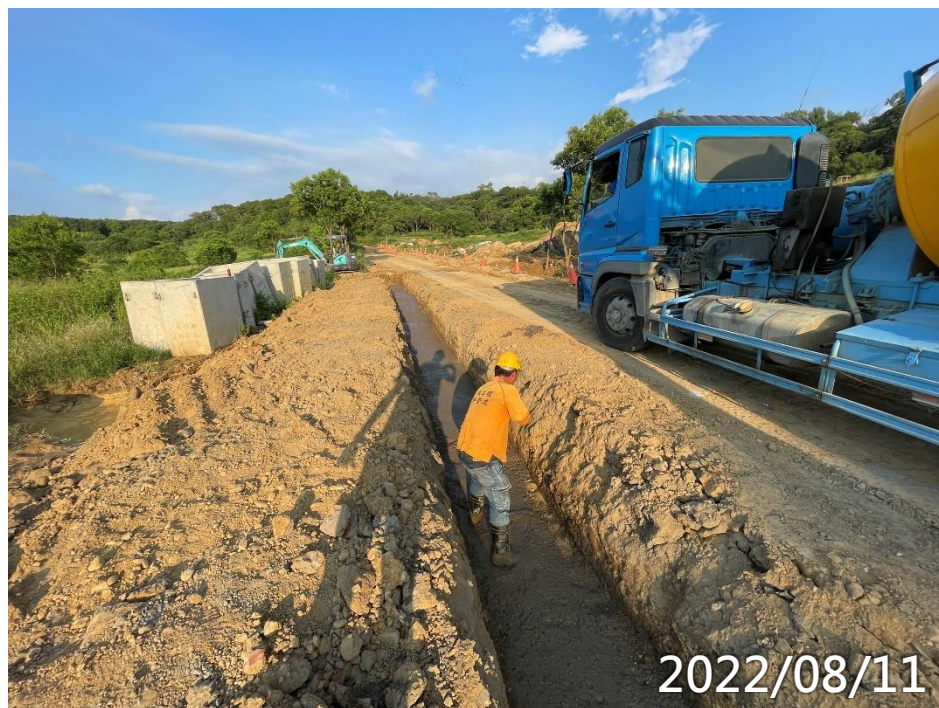
#5至#25污水管路CLSM打底
