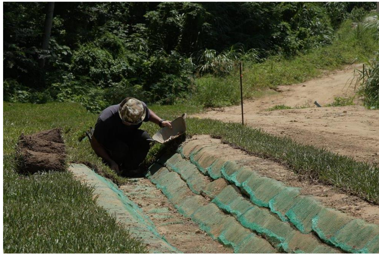
義工施作草皮排水溝 2024/6月
