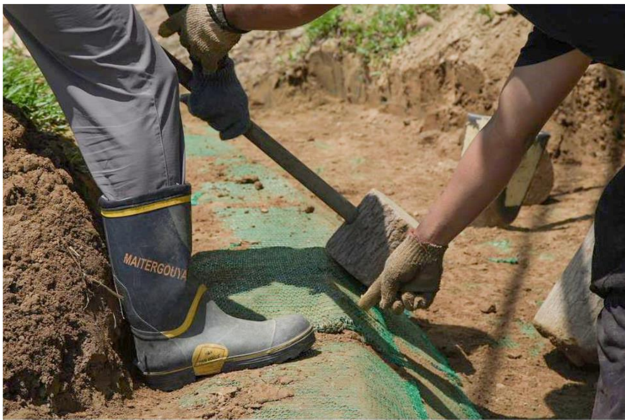
義工施作草皮排水溝 2024/6月
