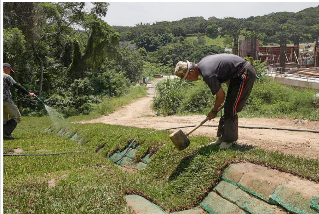
義工施作草皮排水溝 2024/6月
