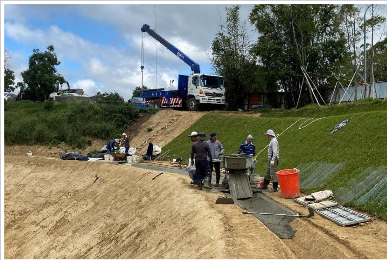
義工施作回填區排水溝 2024/12月
